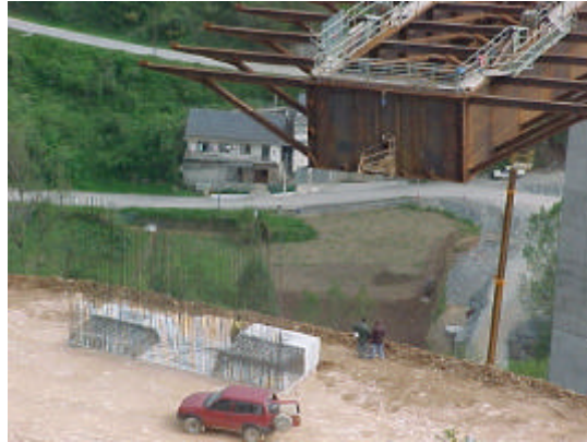
Foto 1. Cajón metálico llegando al estribo (Viaducto de As Nogais). Obsérvese la disposición de los jabalcones, coincidentes con marcos transversales.
