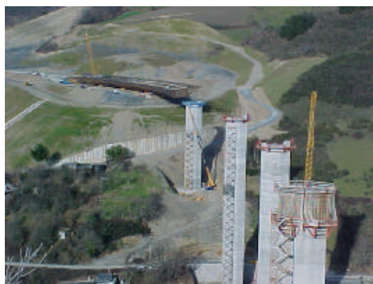
Foto 4. Vista general de las pilas con los encofrados trepantes. Viaducto de As Nogais.
