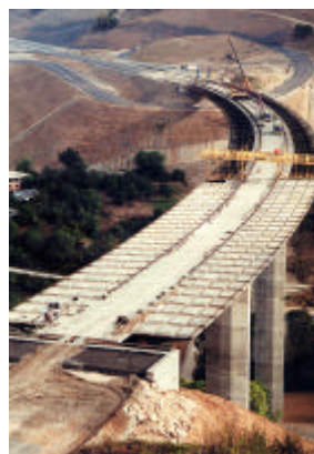
Foto 3. Colocación de placas prefabricadas y hormigonado de juntas sobre el Viaducto de As Nogais.
