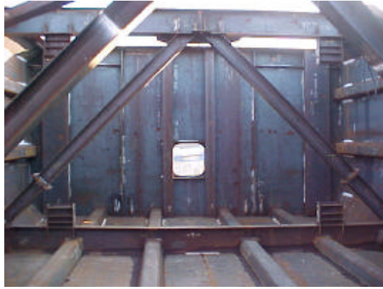
Foto 2. Vista del interior del cajón metálico (Viaducto de As Nogais). Se aprecia la configuración en K de los rigidizadores transversales. Observar el diafragma de pila y la rigidización longitudinal dispuesta.
