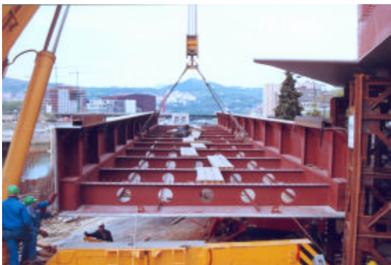
Fig. 7: Izado tramo lateral
