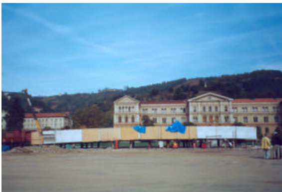
Fig. 5: Premontaje tramo central a la ribera
