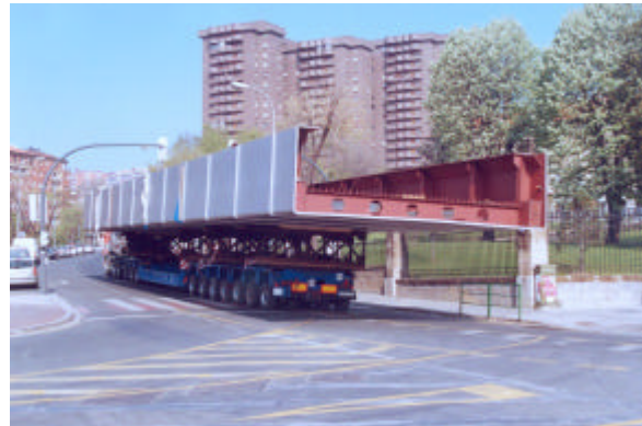
Fig. 6: Transporte tramo lateral en camión
