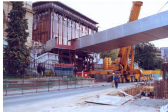
Fig. 8: Tramo lateral del lado Deusto ya montado
