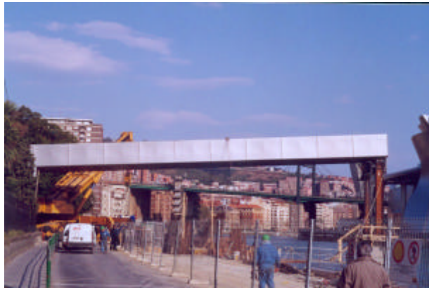
Fig. 9: Tramo lateral lado Deusto ya montado
