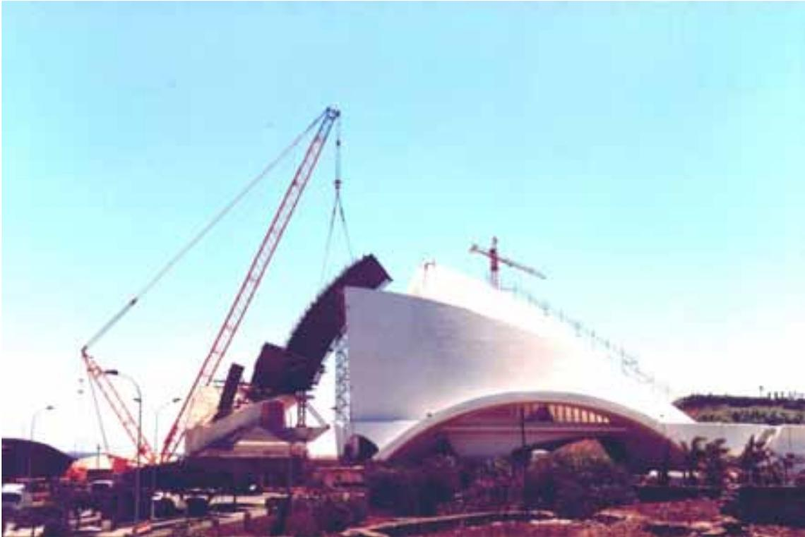
**Figura 3. Montaje de la estructura metálica**
