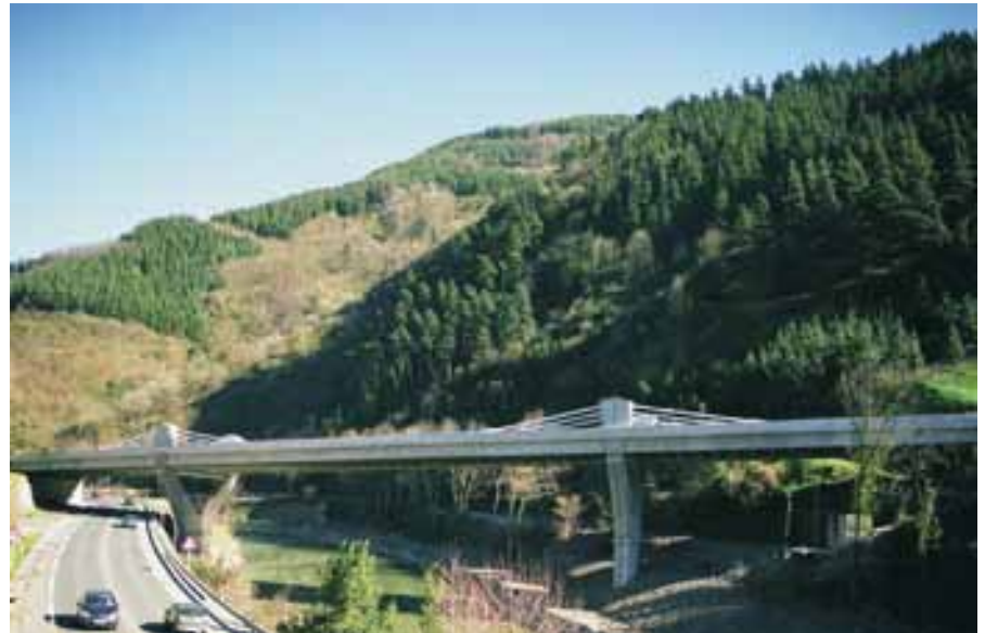
Figura 2. Puente sobre el río Deba. En la izquierda de la imagen aparece el paso de la Carretera N-634 por debajo del tablero. Figure 2. Bridge over the river Deba. The N-634 road appears passing under the deck on the left of the picture.
