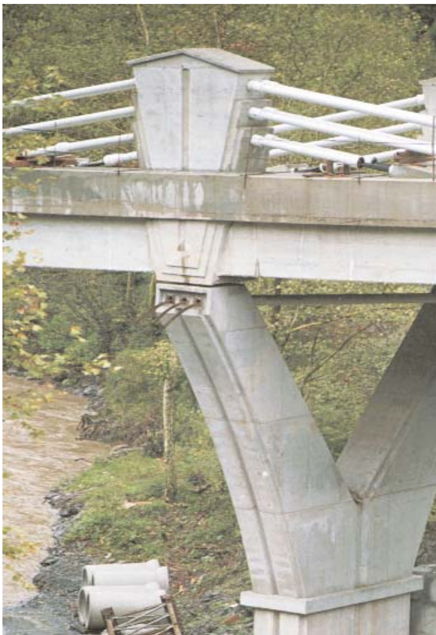
Figura 20. Detalle de la zona superior de una pila en proceso de construcción. Pueden apreciarse los extremos salientes de los tendones, que discurren por el interior de los tubos metálicos
