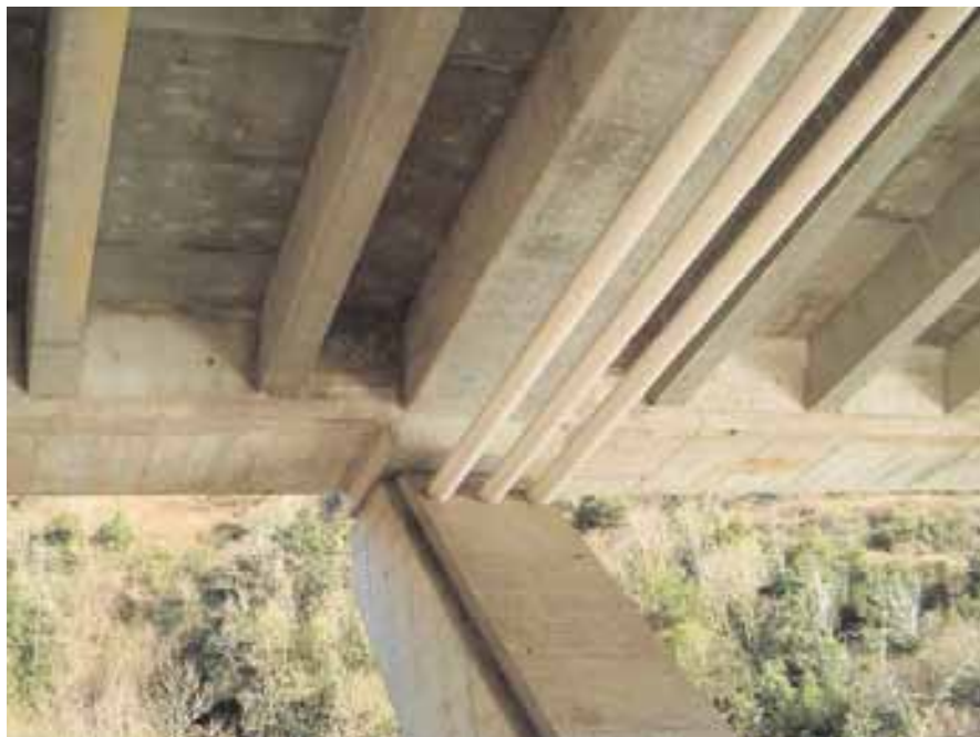
Figura 19. Detalle de la zona de apoyo del tablero sobre las pilas. Pueden apreciarse los tres tubos de atirantamiento transversal. Figure 19. Detail of the deck support area on the piers. The three cross stay tubes can be seen.
