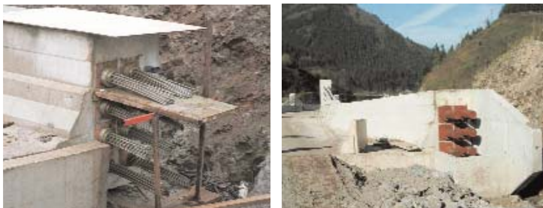
Figura 13. Anclajes de pretensado en un extremo del tablero. En la imagen de la izquierda, con el conjunto de tendones en fase de tesado. En la imagen de la derecha, protección exterior de los anclajes de pretensado extradosado.
