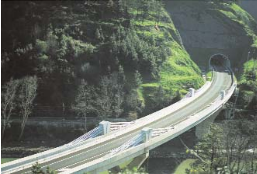
Figura 8. Tablero del Puente sobre el río Deba. Vista superior.
