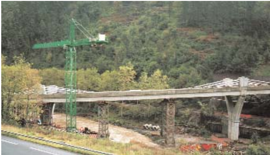
Figura 22. Tablero en fase de construcción. Vista lateral. Figure 22. Deck in the construction phase. Side view.
