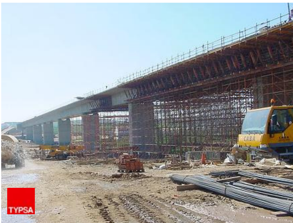
Figura 3. Viaducto sobre el Guadalquivir. Vista de los vanos de acceso en construcción.
