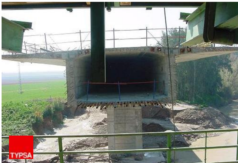
Figura 5. Viaducto sobre el Guadalquivir. Vista de la sección transversal en construcción.
