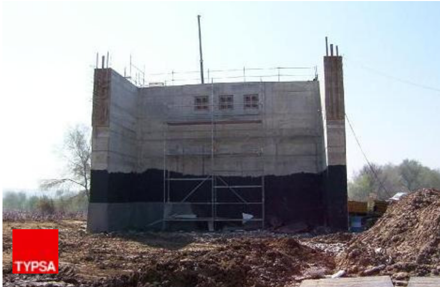
Figura 7. Viaducto sobre el Guadalquivir. Estribo 1 (fijo) en construcción.
