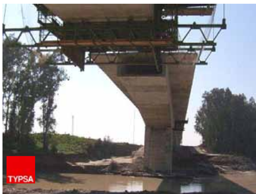
Figura 10. Viaducto sobre el Guadalquivir. Ejecución de vanos centrales por voladizos sucesivos.
