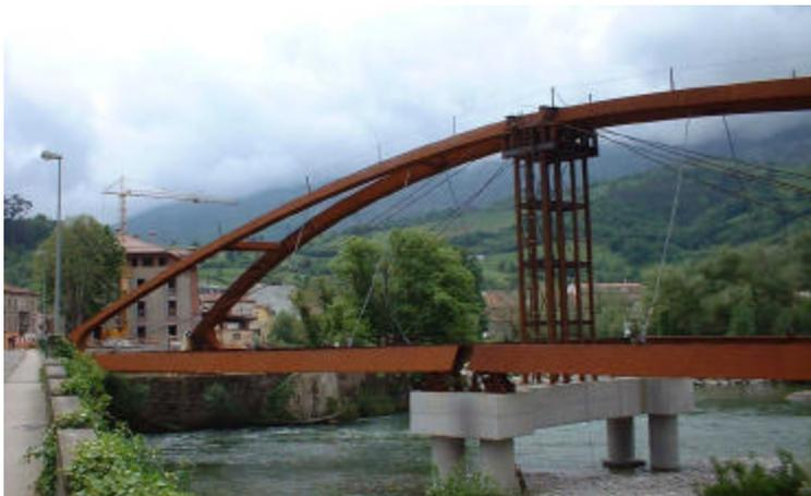
Para corregir flechas producidas durante la construcción, así como para poner en carga los arcos bajo su propio peso, se optó por tesar los arcos según la línea de su cuerda. Con esta solución no sólo se introdujeron los clásicos
