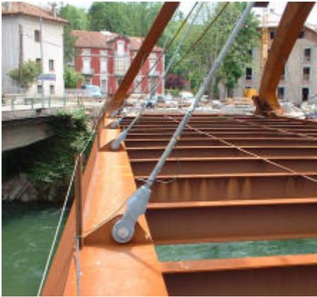
Las cargas verticales son transmitidas de las viguetas transversales a las dos vigas-cajón laterales, que trabajan cada una como una viga continua, dado que cada 9 metros en sentido longitudinal al puente existe un cable cerrado galvanizado trabajando a modo de péndola, que cuelga el tablero inferior de los arcos inclinados.
