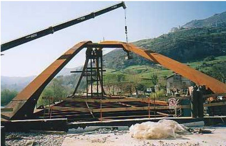
para después elevarlos sobre los tirantes. Sin embargo, por la insuficiencia de espacio a pie de obra para el montaje previo, fue imprescindible montar cada uno de los 4 semiarcos sobre los tirantes, para realizar posteriormente las uniones a las vigas riostras.
