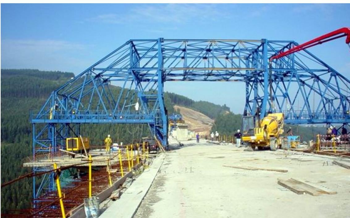
El pretensado exterior de un vano se tesa después del hormigonado del voladizo de ese vano. Cada tendón tiene una longitud de un vano y ancla en las riostras de pila, de este modo en las riostras de pilas existen cuatro anclajes, dos activos y dos pasivos. La riostra se ha recrecido longitudinalmente para dar cabida a los desviadores, ocupando tres dovelas. Los desviadores en el interior del vano tiene una sección transversal de 1.5 m de ancho por 0.95 m de canto.
