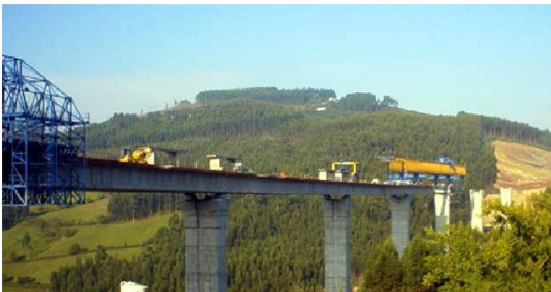
Las dovelas se colocan aproximándolas con la cimbra y se aseguran inicialmente con barras de cosido provisionales ancladas a cajetines dejados al efecto en las dovelas. Una vez completado el pretensado interior se retiran las barras.
