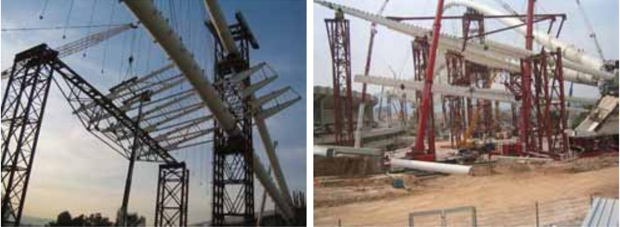
Fig. 11 Montaje de las costillas por parejas en general e individualmente las más pesadas (ejes 25, 26 y 27).
