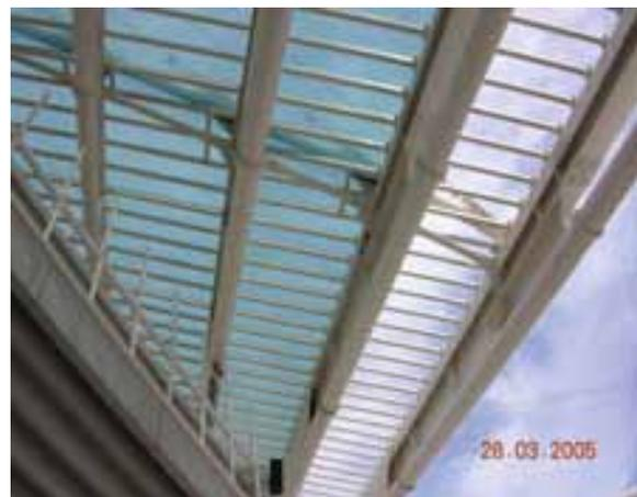
Fig. 6 Vigas Vierendeel de arriostramiento entre ejes 25 y 27, costilla diagonal y tubos de atado de los cables secundarios.
