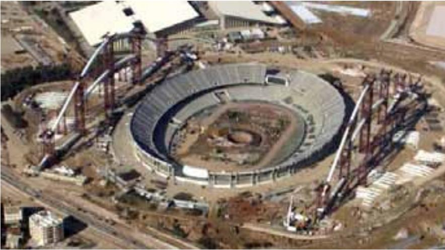
Fig. 8 Posición de las torres provisionales principales y tramos de arco
