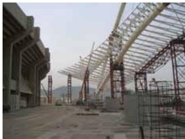
Fig. 5 Costillas transversales, correas y elementos de arriostramiento cada 5 correas (acabados y durante el montaje).
