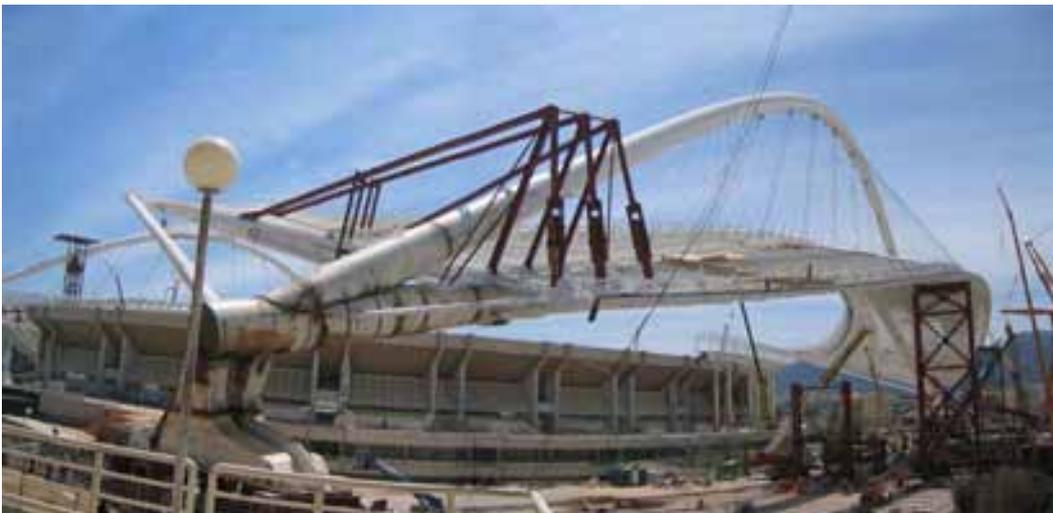
Fig. 12 Semi-cubierta liberada de apoyos provisionales.
