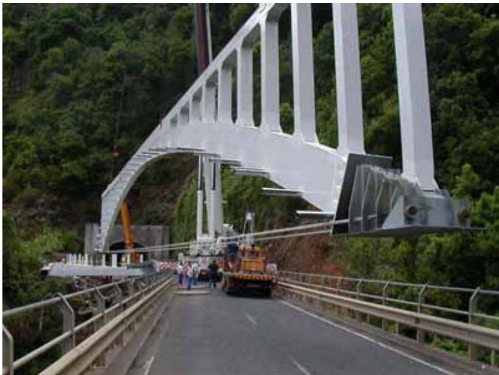
Figura 8. Maniobra de colocación del primer arco metálico.
