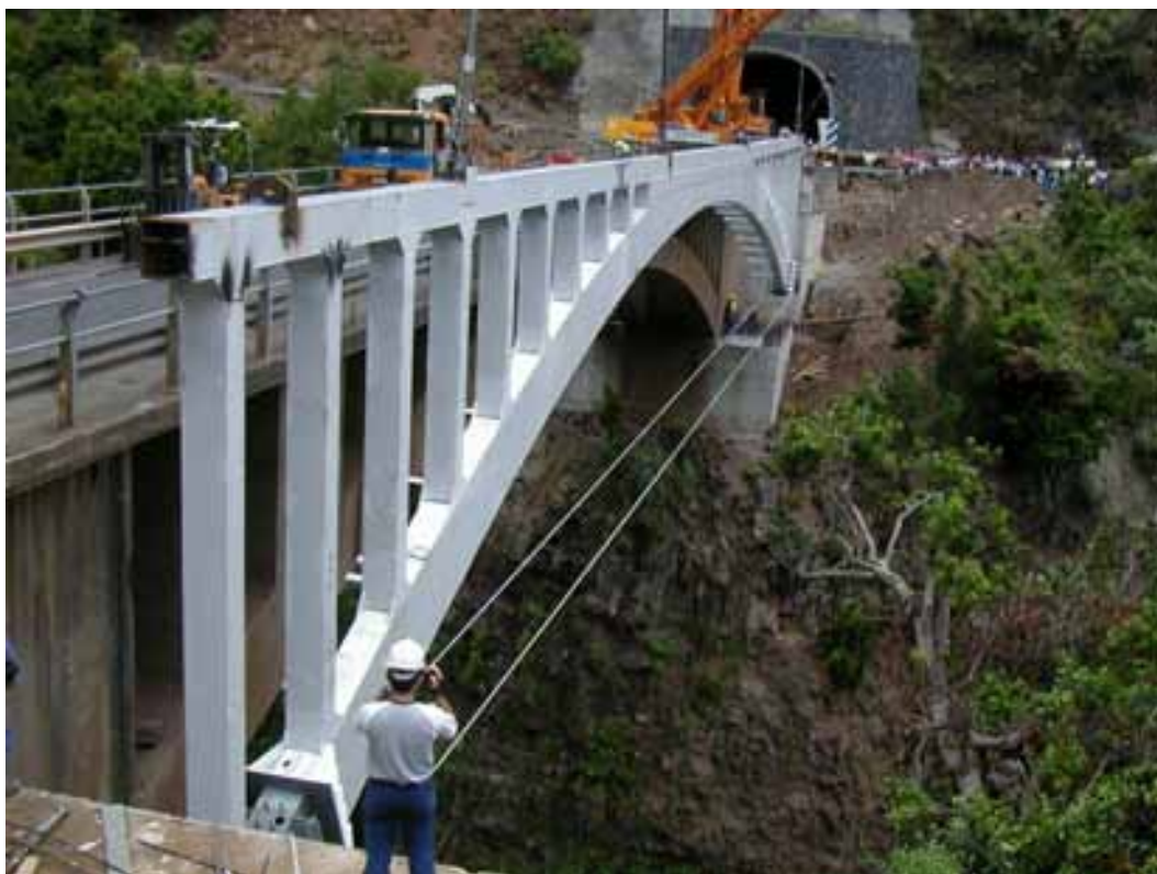
Figura 11. Ajuste final durante el montaje de uno de los arcos.
