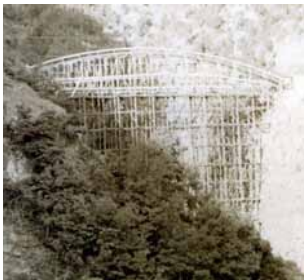
Figura 2. Cimbra utilizada para la construcción del arco de hormigón
