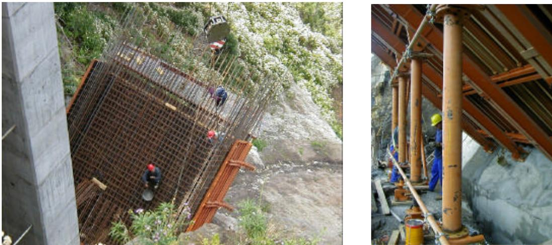
Figura 18 Cimbrado provisional Dovela 0 Sur
