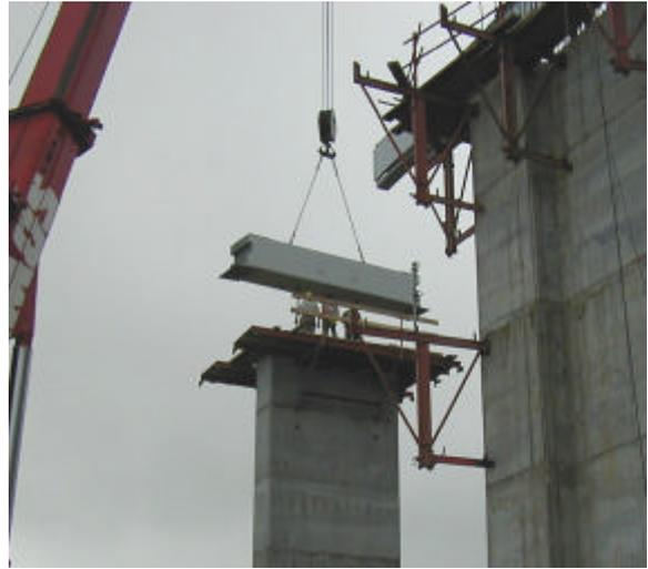
Figura 23. Colocación de traviesa
