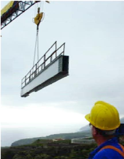
Figura 14. Montaje viga longitudinal.
