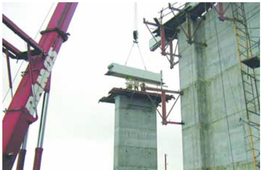
Figura 13. Colocación de traviesa
