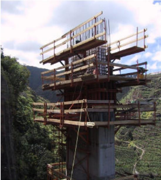
Figura 21. Hormigonado Pila 0 Sur
