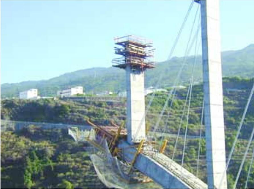
Figura 12. Trepado para hormigonar las pilas.
