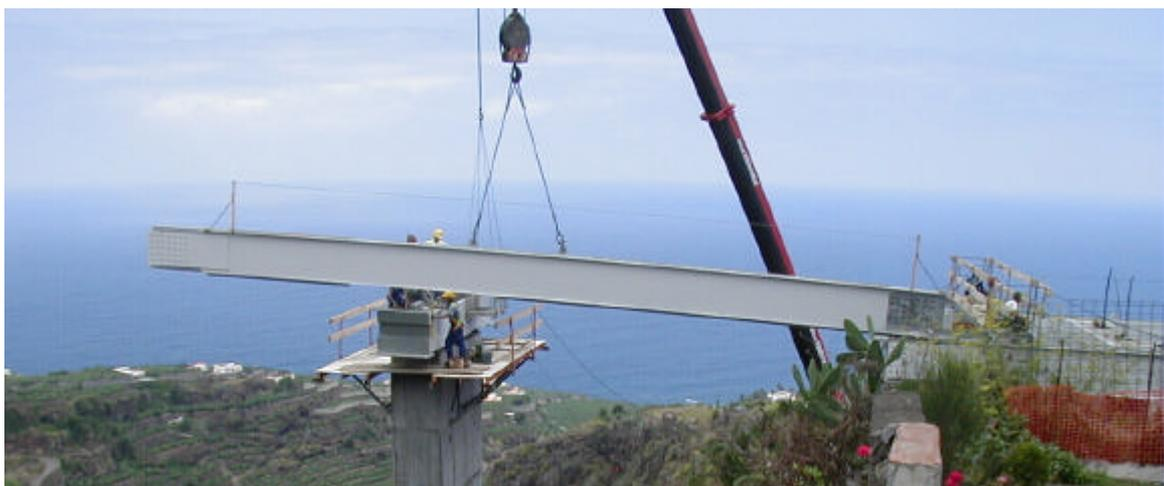
Figura 25. Montaje viga longitudinal
