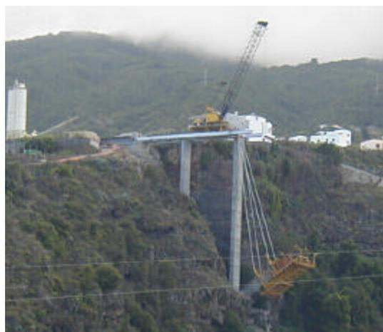
Figura 20. Cables Auxiliares dovela 2.
