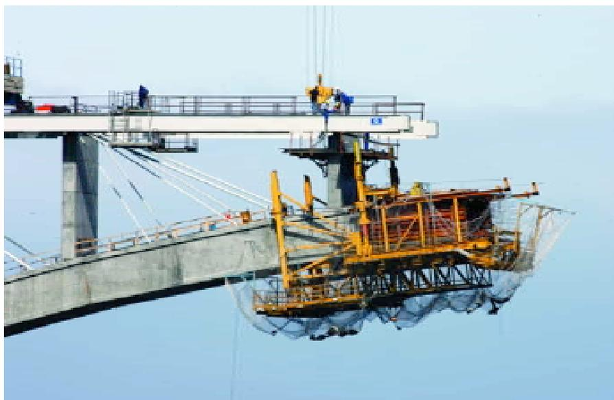
Figura 11. Diagonales auxiliares.
