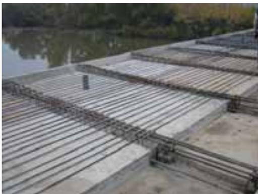
**Foto 11. Hormigonado losa.**
