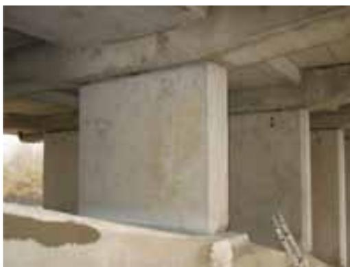
**Foto 9. Placas anclaje unión costilla-losa. Foto 10. Montantes de apoyo costilla-arco.**
