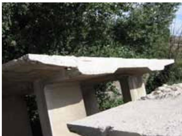
**Foto 4. Proceso de retirada de tablero y montantes tras corte con hilo de diamante.**
