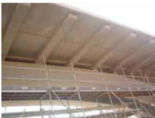
**Foto 13. Vista inferior de tablero del puente.**
