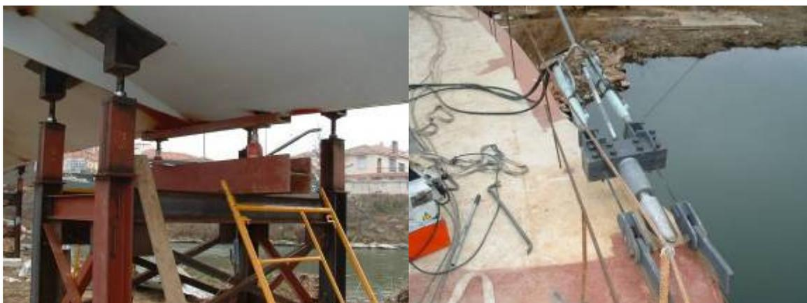
**Figura 12. Gatos bajo castilletes (izda.) y tesado cables extremos (dcha.)**
