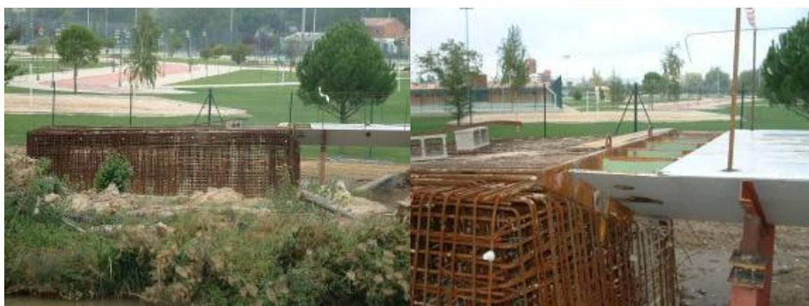
**Figura 9. Armado estribo Isla dos Aguas**
