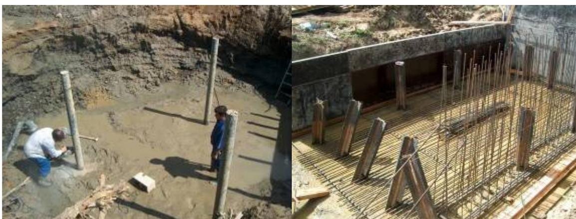
**Figura 8. Ejecución de micropilotes**
