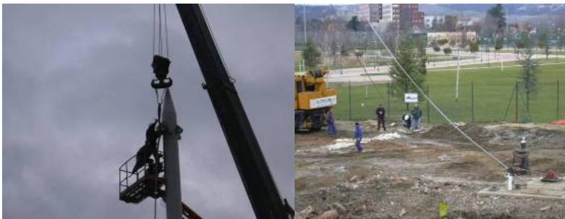
**Figura 11. Tesado de los cables de retenida**
