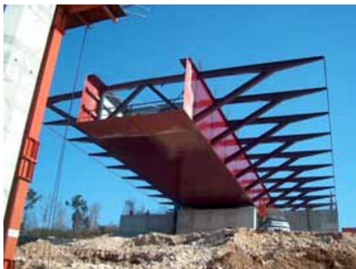
Figura 10. Lanzamiento del cajón desde el estribo E2
