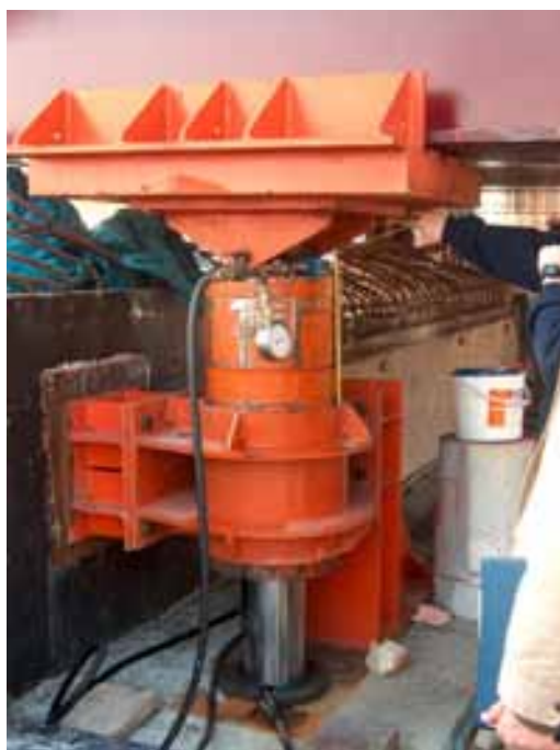
Figura 9. Apoyos de lanzamiento y gatos de regulación
