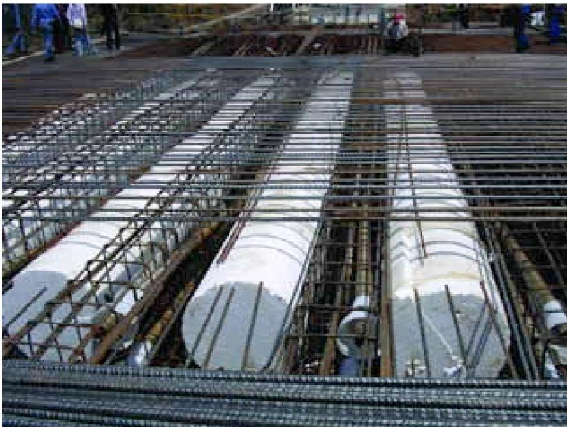
Fig.16. Tablero listo para hormigonar.
