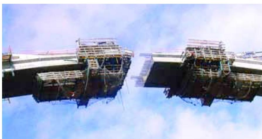
Fig.30. Carros enfrentados para la ejecución de la apertura en clave.
