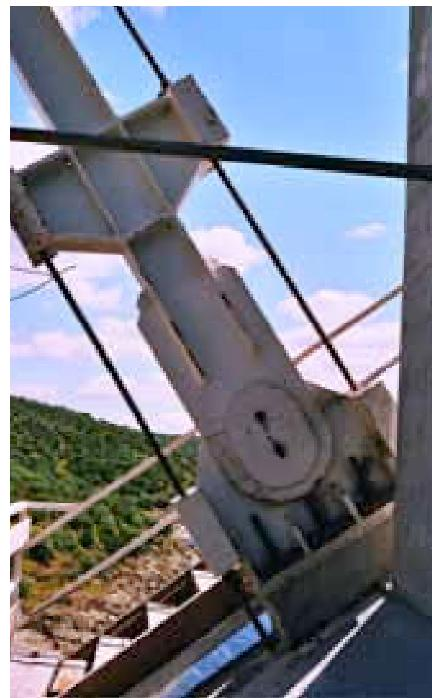
Fig.42. Detalle de tesado de diagonal rígida.
