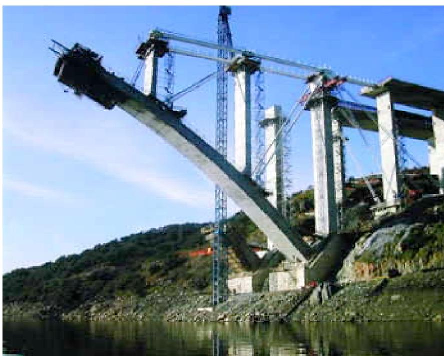
Fig.22. Viaducto de Almonte. Proceso constructivo por triangulación.
