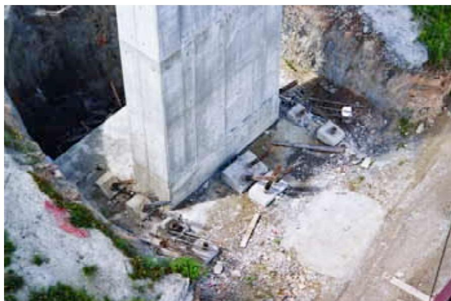
Fig.31. Anclaje de pila 8 al terreno.
