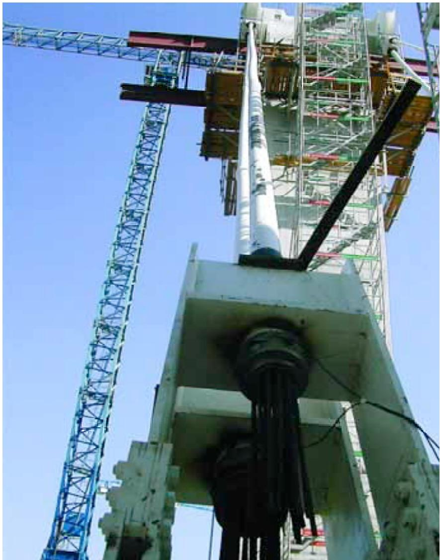
Fig.40. Detalle de tesado de los cables de retenida.
