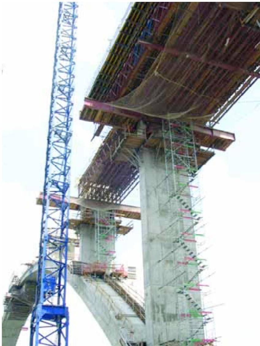
Fig.18. Ejecución del tablero mediante autocimbra.
