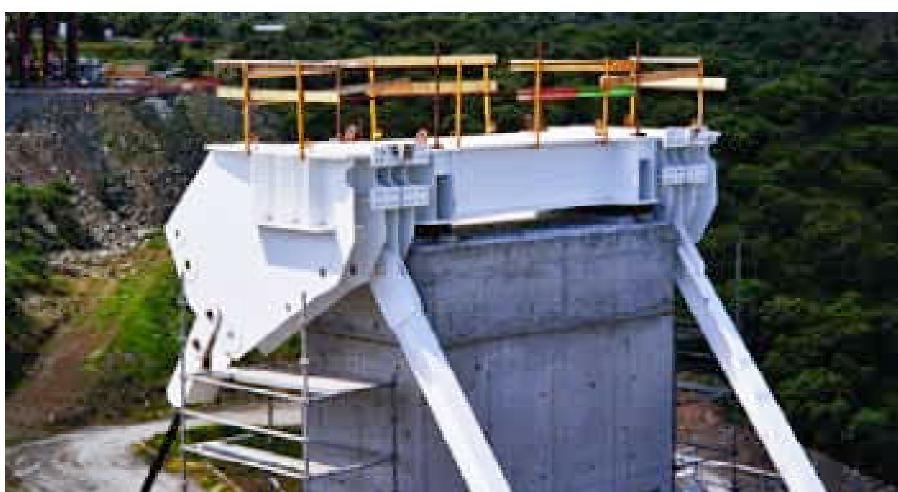
Fig.41. Detalle de nudo en pila sobre el arco.
