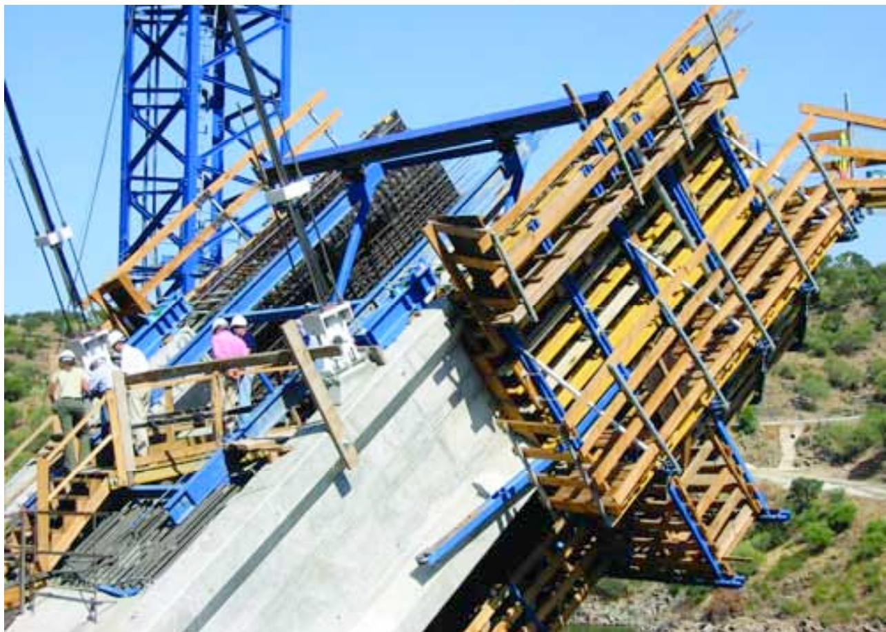
Fig.33. Carro de avance en voladizo para el arco, con tirantes auxiliares.
