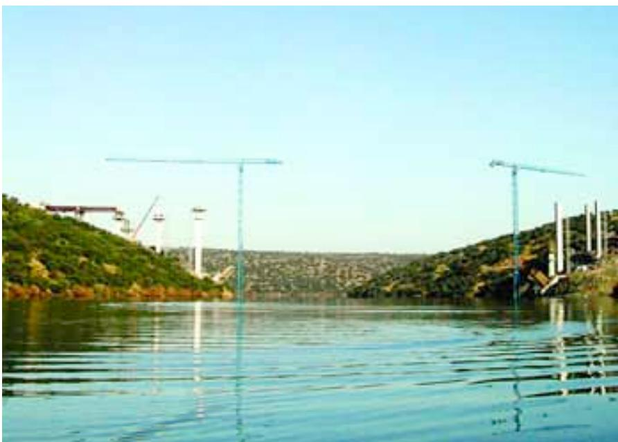
Fig.25. Trabajos simultáneos en pilas, arcos y tablero.
