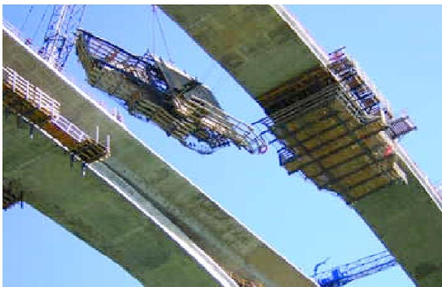
Fig.28. Desmontaje de los carros de avance
