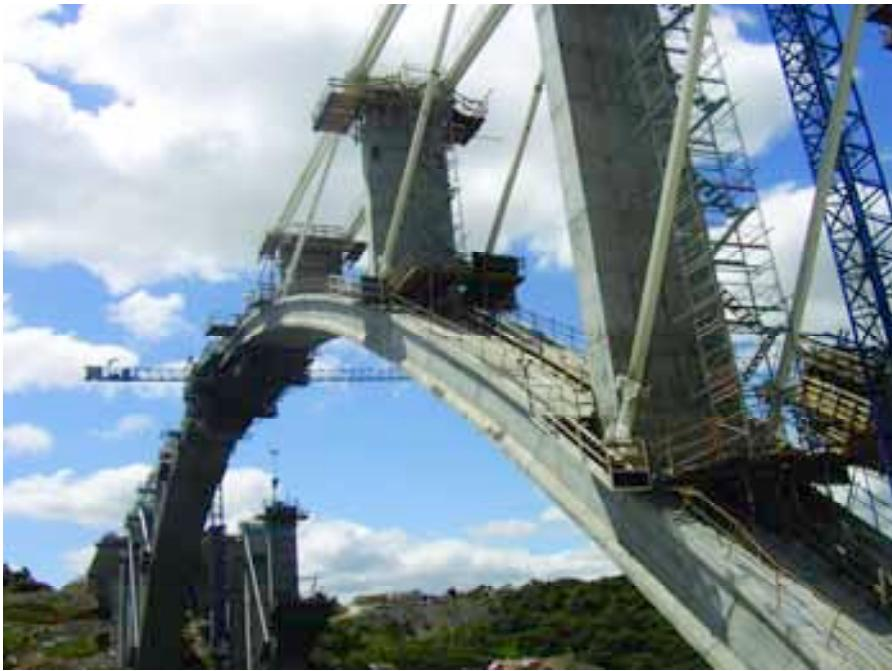
Fig.24. Viaducto de Almonte. Proceso constructivo desarollo llado para ACCIONA Infraestructuras.
