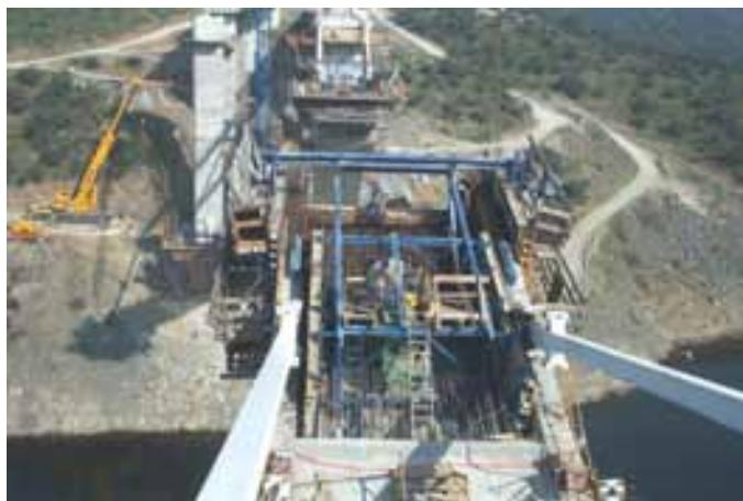
**Figura 11. Dovela en ejecución**
