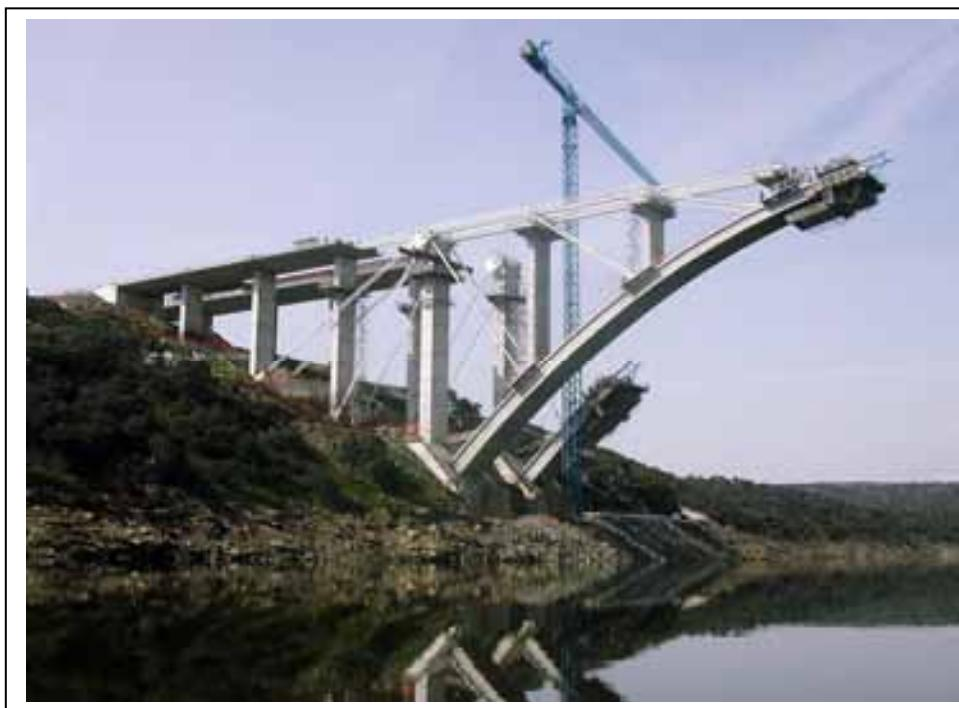
**Figura 7. Arco en construcción**
