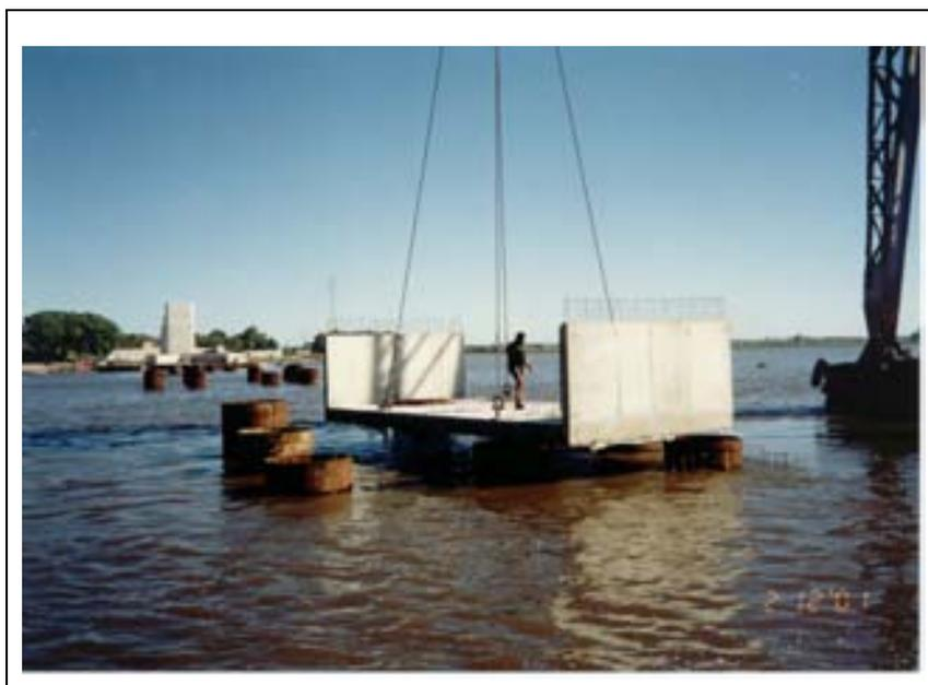
**Fotografía N°1 Colocación “fajas” encofrado perdido**
