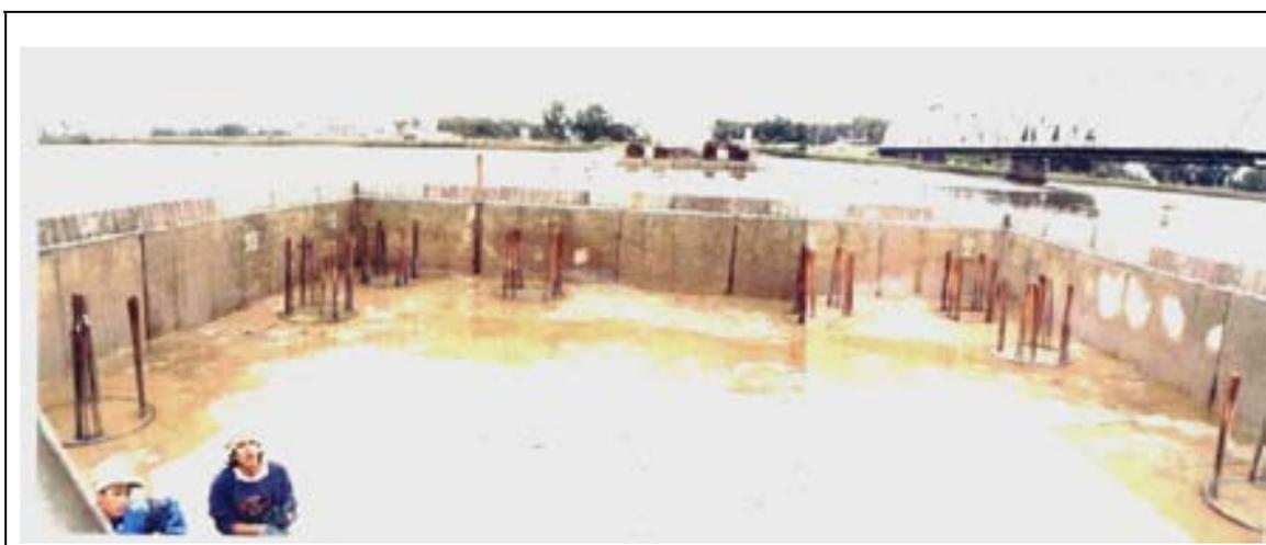
**Fotografía N° 2 Encepado previo a colocación de armadura**
