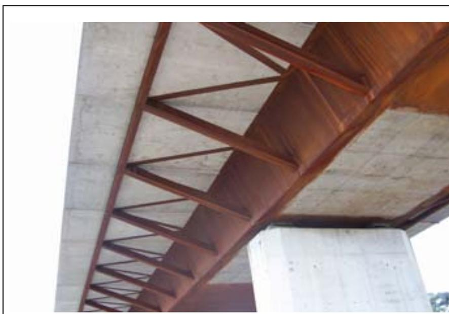
**Foto N° 12 Placas Premoldeadas (Vista Inferior)**
