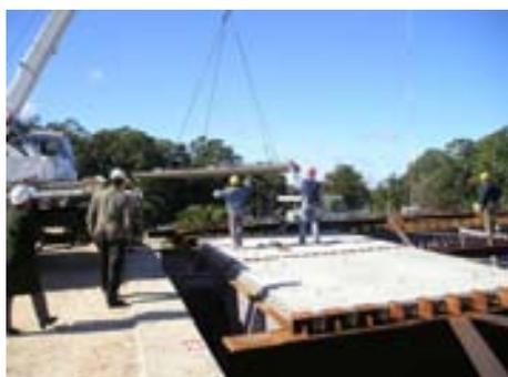
**Foto N° 10 Inicio de la colocación de Placas Prefabricadas**
