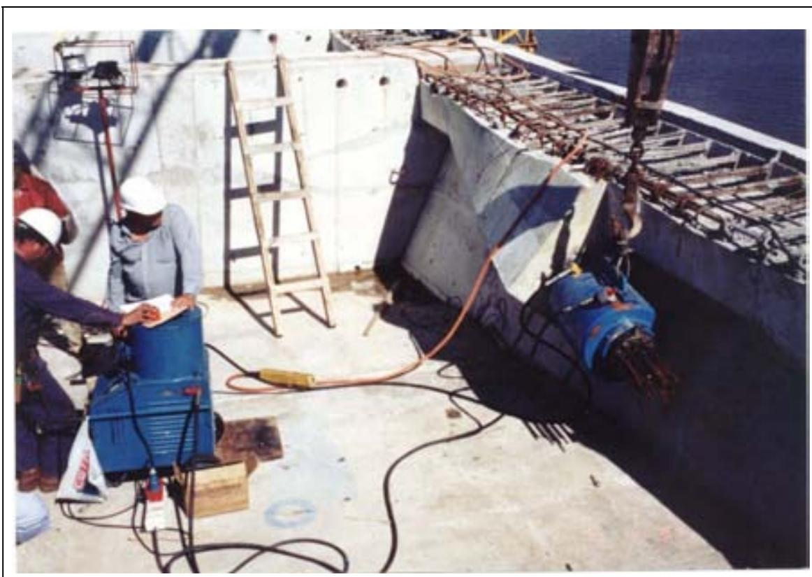
Fotografía N° 7 Pretensado ábacos y canal corrido para conectores
