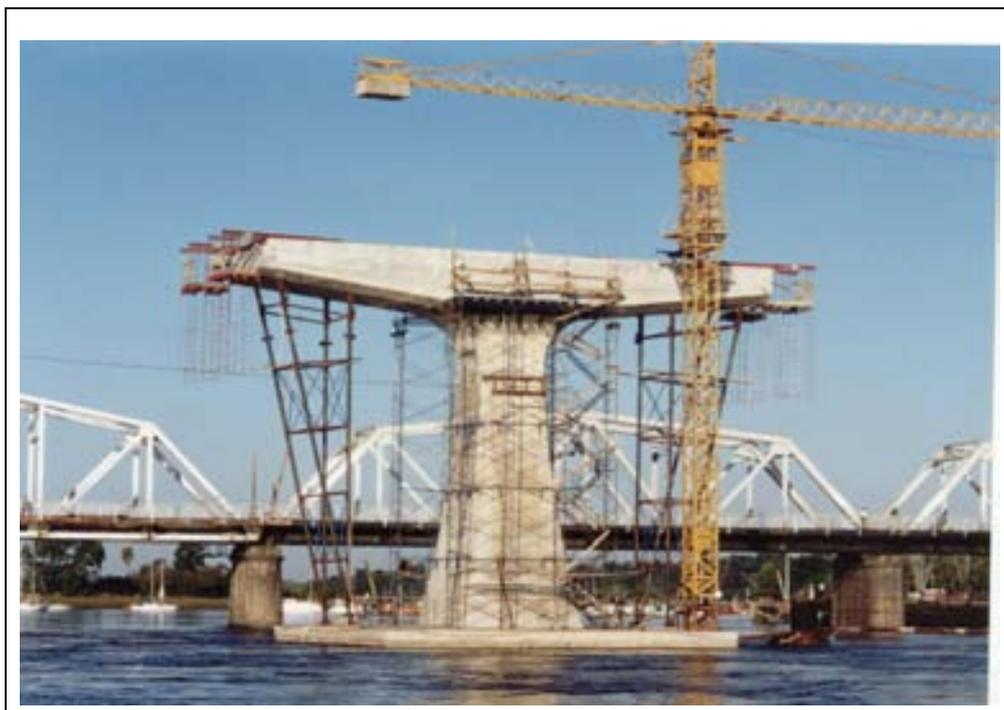
**Foto Nº 5 Pila Principal en Fase de Construcción**
