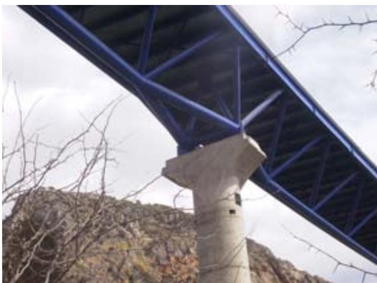
El apoyo del cordón inferior en las pilas y estribos se realiza bifurcando en dos el tubo inferior abriéndose hacia los aparatos de apoyo separados cinco metros entre sí. Con esto se consigue la estabilidad del puente que es curvo en planta.
