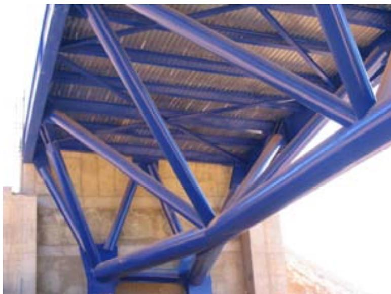
La superficie de deslizamiento era el fondo de los cajones laterales superiores. Como las pilas llegaban al cordón inferior hubo que disponer unos elementos provisionales metálicos que apoyándose en la cabeza de las pilas
