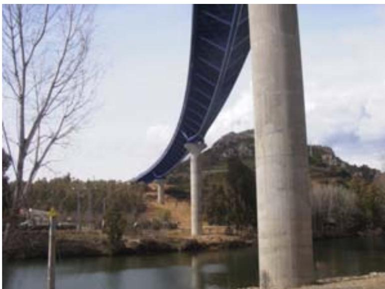
Para el montaje del puente se había pensado en el uso de grúas para los vanos sobre tierra y en izar la parte del tablero que está sobre el río. Sin embargo la empresa adjudicataria de la obra propuso cambiar este proceso por el de empujar el tablero.
