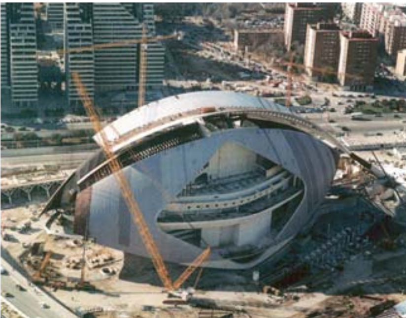
Fig. 16 Vista general de la Cáscara durante su construcción
