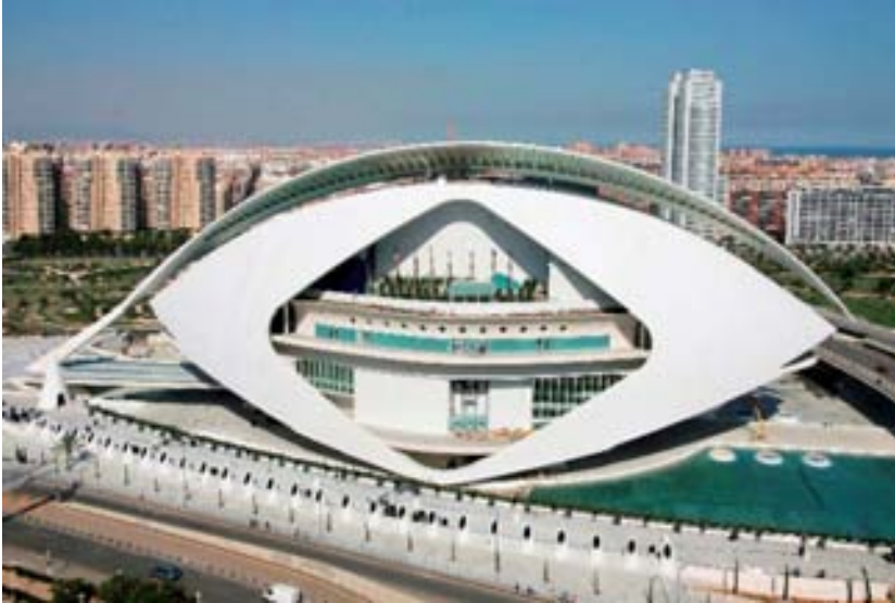
Fig. 2 Vista general del Palacio de las Artes
