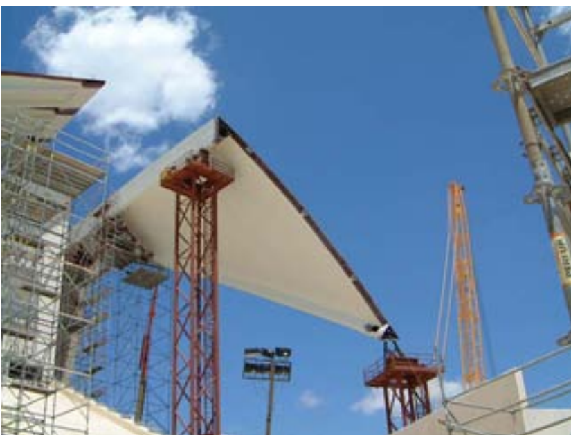
Fig. 11 Perspectiva del montaje de la pieza de clave en obra
