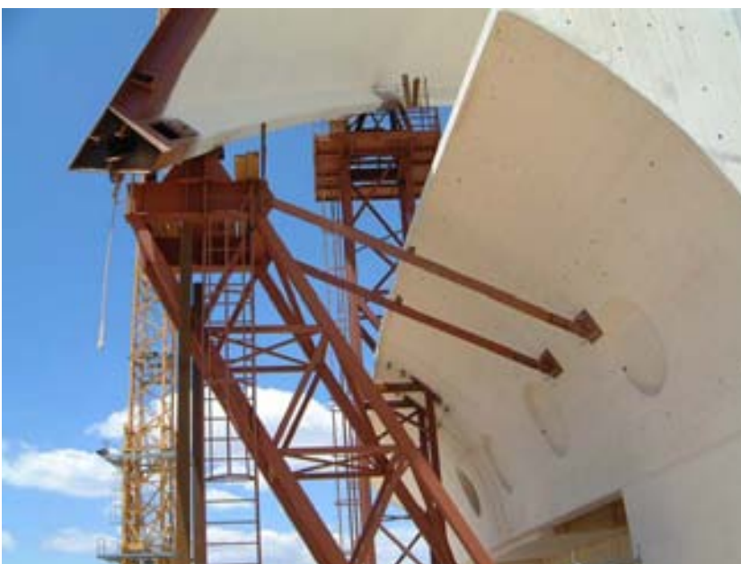
Fig. 14 Detalle del montaje de la Cáscara sobre los castilletes
