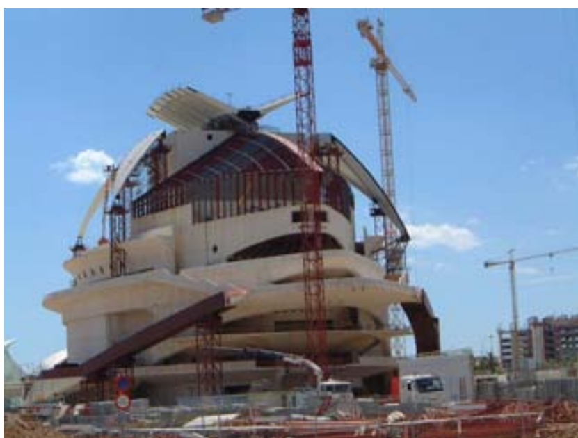
Fig. 12 Vista general del montaje de la Cáscara
