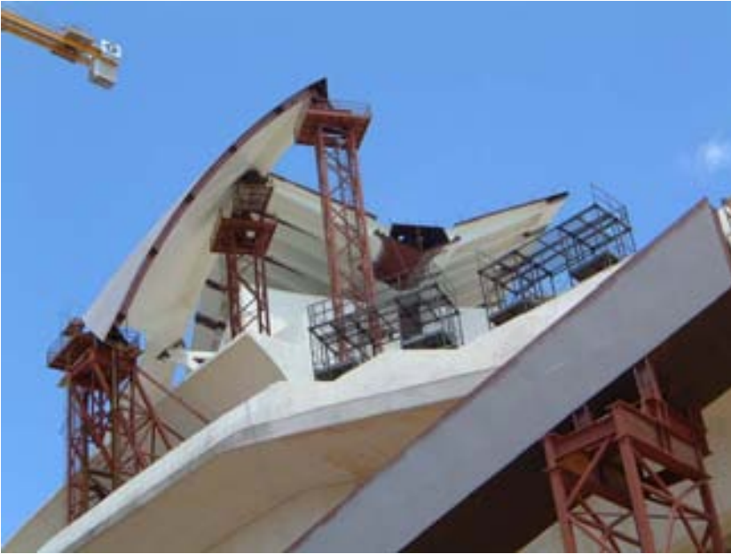
Fig. 15 Vista del montaje de conjuntos de la Cáscara sobre los castilletes
