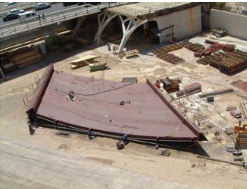
Fig. 3 Vista de conjunto de sándwich y de las vigas de borde superior e inferior antes de ser izada
