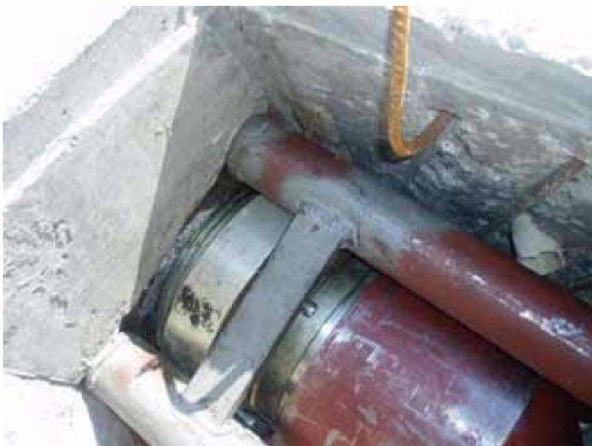
**FOTO 8. Detalle del anclaje DMK con la tuerca de regulación despegada**
