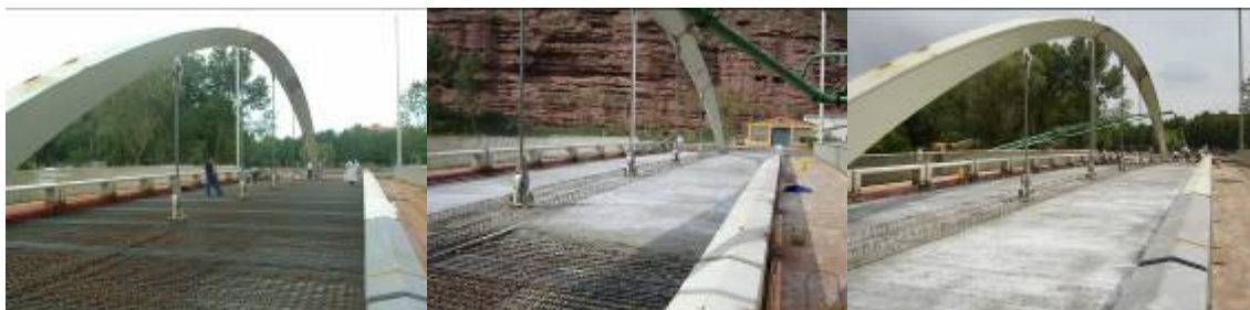
Figura 15. Hormigonado de la losa superior.
