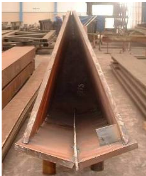
Figura 4. Detalle de la sección del arco en proceso de fabricación en taller.
