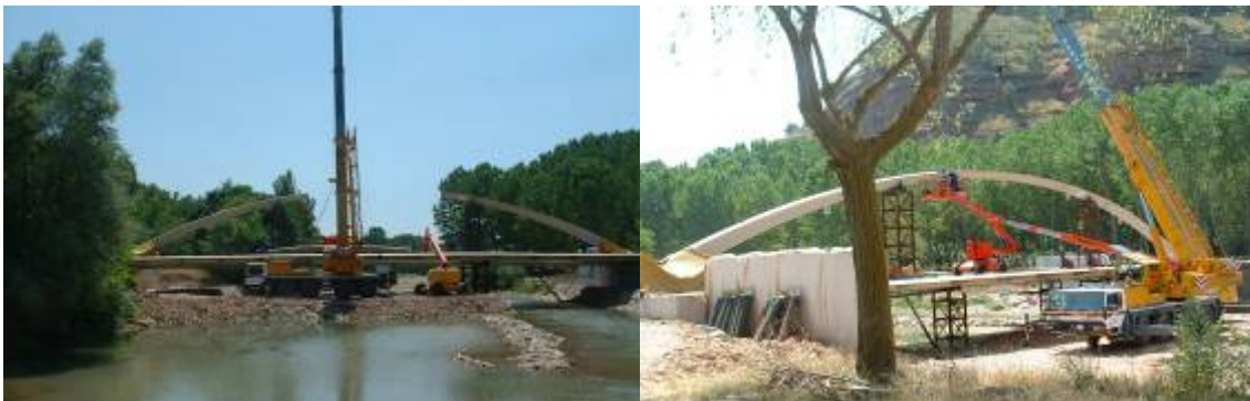
Figura 12. Recrecido de castilletes para montaje del arco.
