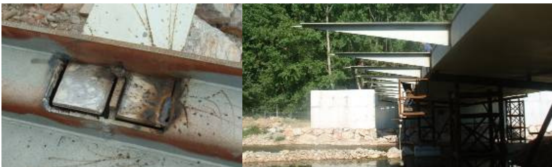
Figura 12. Montaje de costillas laterales.
