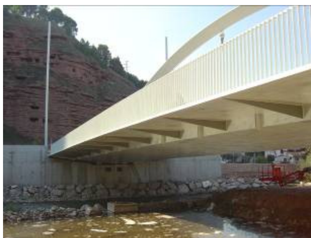
Figura 16. Pintura final, combinando un color claro para el tablero y algo más oscuro para las costillas inferiores.
