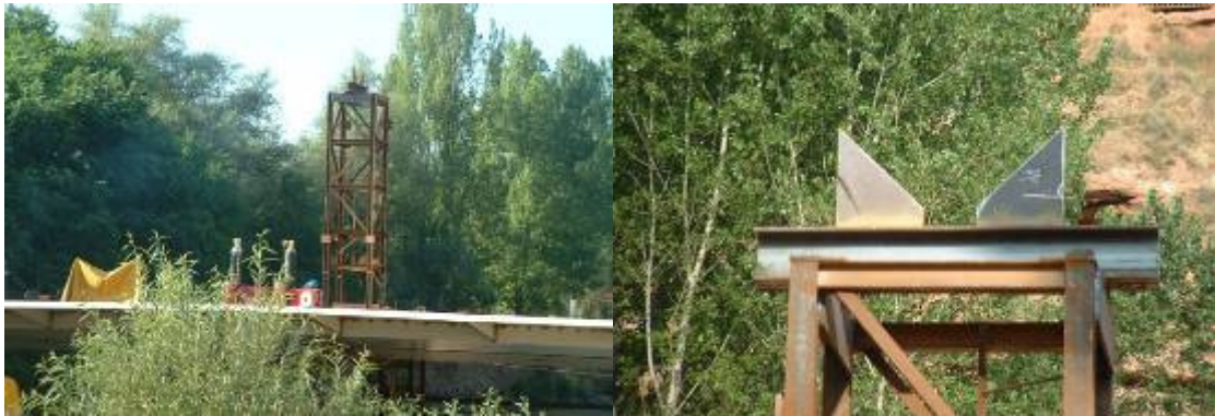
Figura 12. Recrecido de castilletes para montaje del arco.
