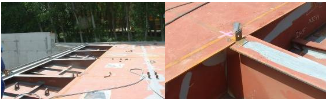
Figura 11. Montaje de piezas laterales del cajón principal.
