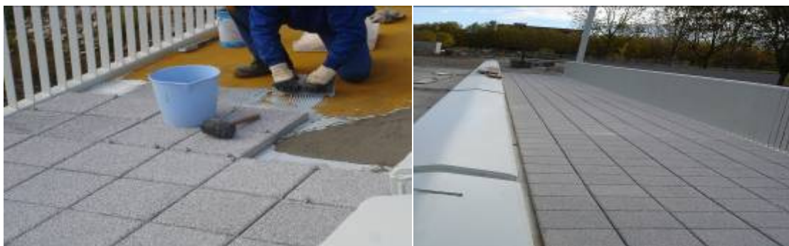
Figura 17. Disposición de acerado de puente y acabado final.
