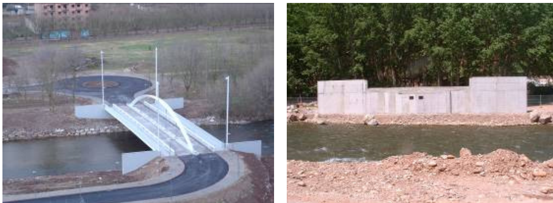
Figura 18. Vista general de puente, en la que se aprecian los cuatro báculos de iluminación principal y alzado frontal del estribo con las cajas previstas para los proyectores del fondo del tablero.
