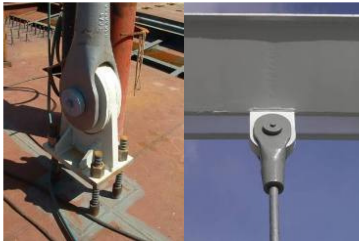
Figura 6. Conexión de las péndolas al tablero y al arco.
