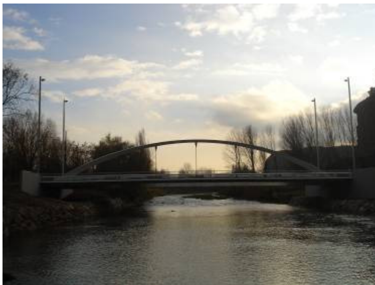
Figura 1. Alzado frontal de la obra terminada.
