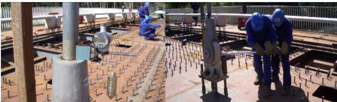
Figura 14. Proceso de tesado de las péndolas. Instrumentación mediante extensómetros.
