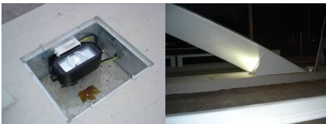
Figura 19. Detalles de iluminación vertical del péndolas e iluminación de arranque de arco.
