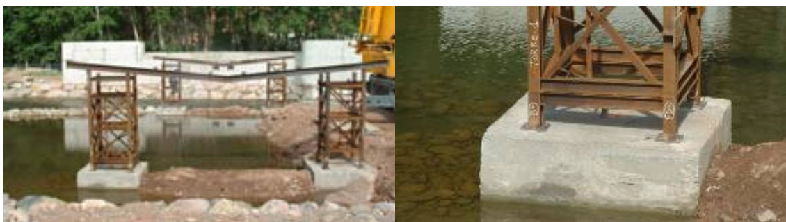
Figura 8. Castilletes intermedios provisionales.
