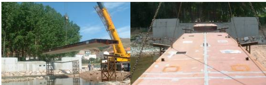
Figura 9. Montaje mediante grúa de las piezas laterales extremas del cajón.
