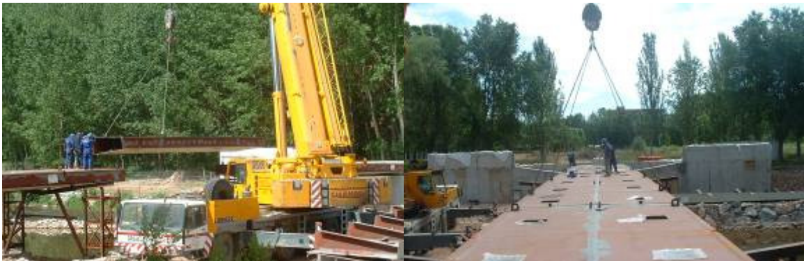
Figura 10. Ensamblaje de la pieza central del cajón.
