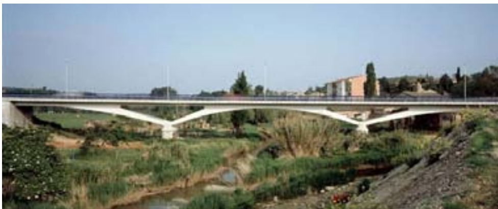
Fotografía 3. Vista del nuevo puente
