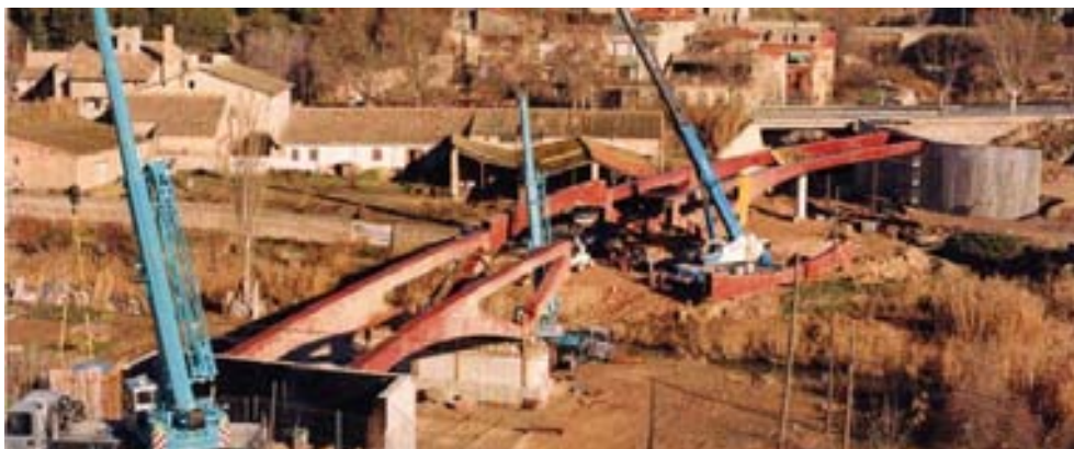
Fotografía 4. El puente durante el montaje metálico.
