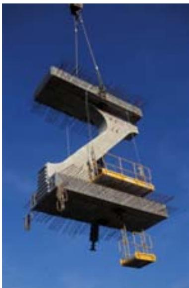
Como ya hemos visto, la construcción del puente se hace por voladizos sucesivos de dovelas prefabricadas, avanzando desde ambas orillas hasta cerrar en el centro.
