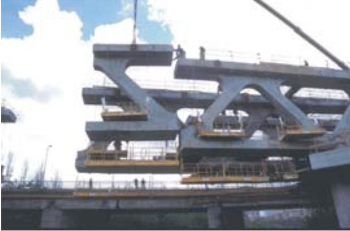
La construcción por voladizos sucesivos se hace únicamente de los cuchillos triangulados, dejando sin construir en este proceso las losas entre cuchillos, que se construyen después de terminar las vigas trianguladas.
