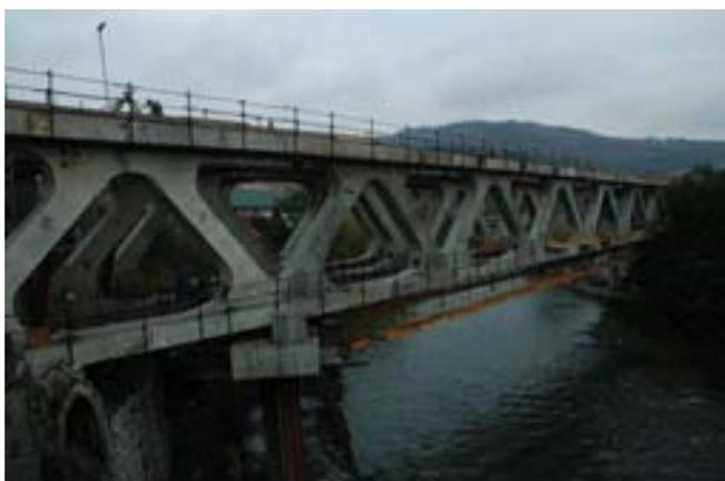
El puente sobre el río se resuelve con una viga triangulada, simplemente apoyada, de 86,16 metros de luz, cuyos cordones superior e inferior están formados por losas sobre las que circulan los dos niveles del metro.
