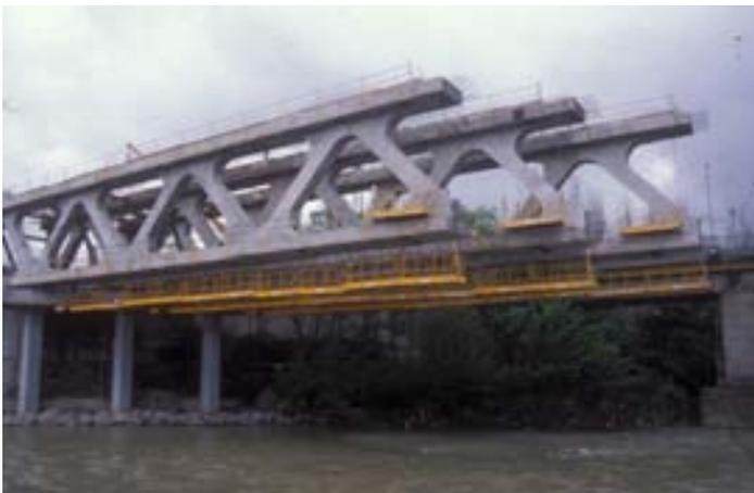
La construcción en voladizo requiere armaduras activas en el cordón superior que se anclarán en las dovelas de avance. Esta armadura se deberá suprimir en la estructura definitiva, sustituyéndola por la armadura activa del cordón inferior.
