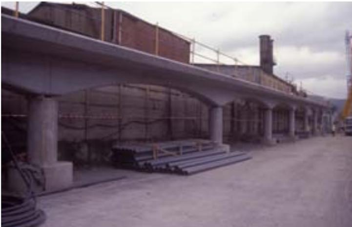
Esta estructura se divide en tres tramos mediante articulaciones. Dos tramos están formados por los viaductos de acceso independientes, y el tercer tramo la zona de las dos vigas unidas por la losa.
