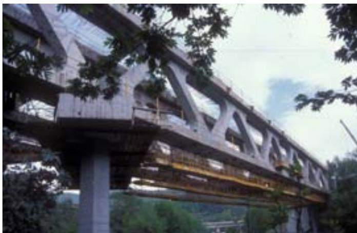
Las diagonales de tracción tienen armadura activa y las de compresión armadura pasiva. La losa inferior tiene también armadura activa longitudinal para resistir la tracción de la viga triangulada.
