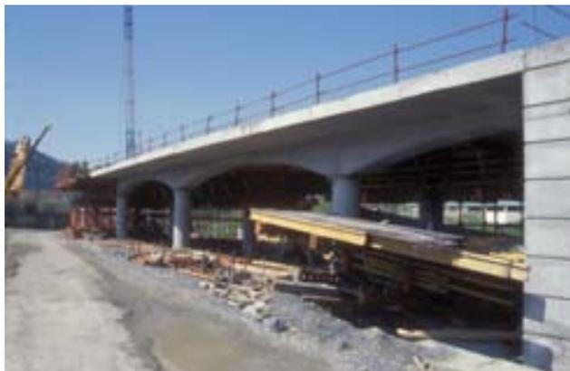
Esta estructura se mantiene hasta que las vías superiores se montan sobre las inferiores; en esta zona, igual que en el acceso opuesto, la estructura está formada por dos vigas laterales, unidas con una losa de 0,60 metros, porque las vías se sitúan sobre la losa y no sobre las vigas.
