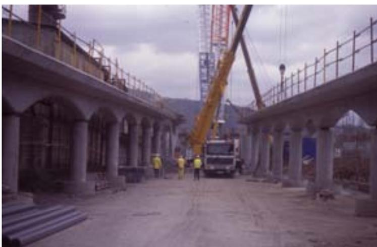
El viaducto de acceso se inicia con dos estribos, uno para cada vía exterior, que consisten en dos muros exteriores con una losa superior, de forma que el interior queda hueco, sin relleno de tierras.
