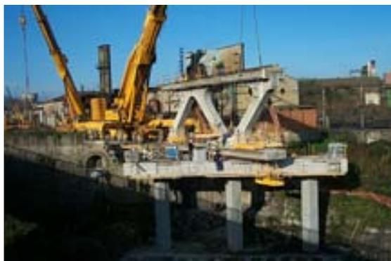
Una vez montadas estas dovelas, se hormigona el montante vertical de final del puente, donde se monta la pieza de anclaje de las barras de pretensado provisionales superiores necesarias por ser la estructura durante la construcción una ménsula apoyada en los apoyos provisionales y ancladas en los apoyos definitivos. Una vez colocada una dovela la siguiente se fija ella, dando una resina epoxi sobre las juntas, y tesando las barras de pretensado de proceso.
