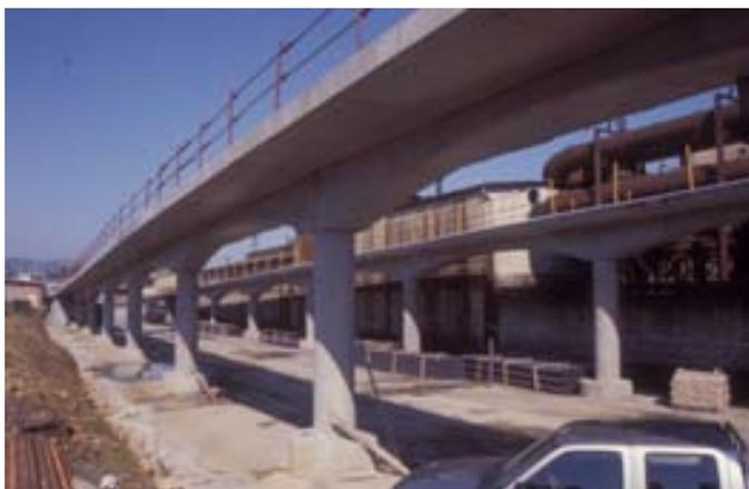
Las estructuras de los accesos se inician cuando las dos vías exteriores se elevan para situarse sobre las vías principales. En la primera parte, el viaducto se desdobra en dos estructuras independientes, cada una de ellas formada por una viga con una losa superior; estas
