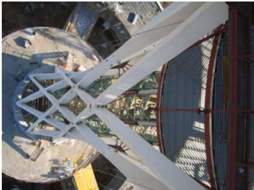
En un principio se planteo la ejecución de las generatrices mediante perfiles tubulares de acero, pero por motivos de mantenimiento y dada su proximidad al mar se excluyó la solución metálica, decidiéndose entonces la utilización de elementos de hormigón prefabricado que si bien hacían más compleja la ejecución de la estructura no requerían mantenimiento.
