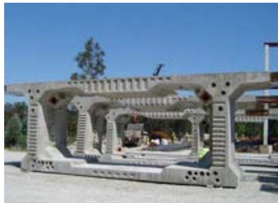
Figura 7 Dovela en vanos en arco
