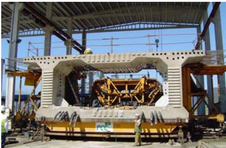
**Figura 2 Fabricación de dovelas**
