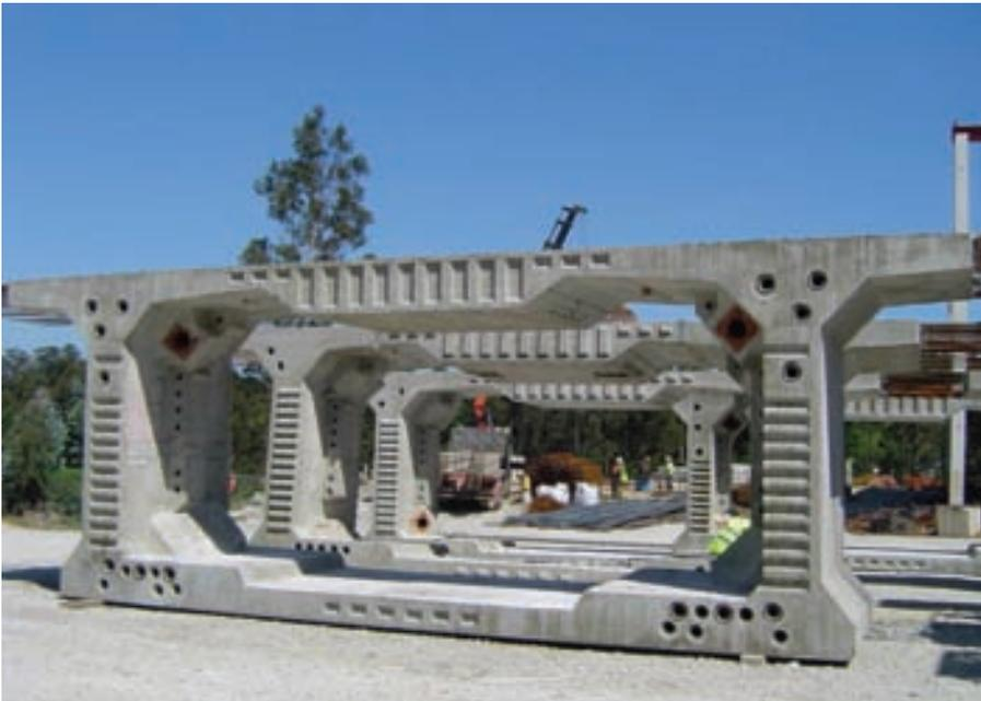
Figura 9. Dovela vanos en arco.
