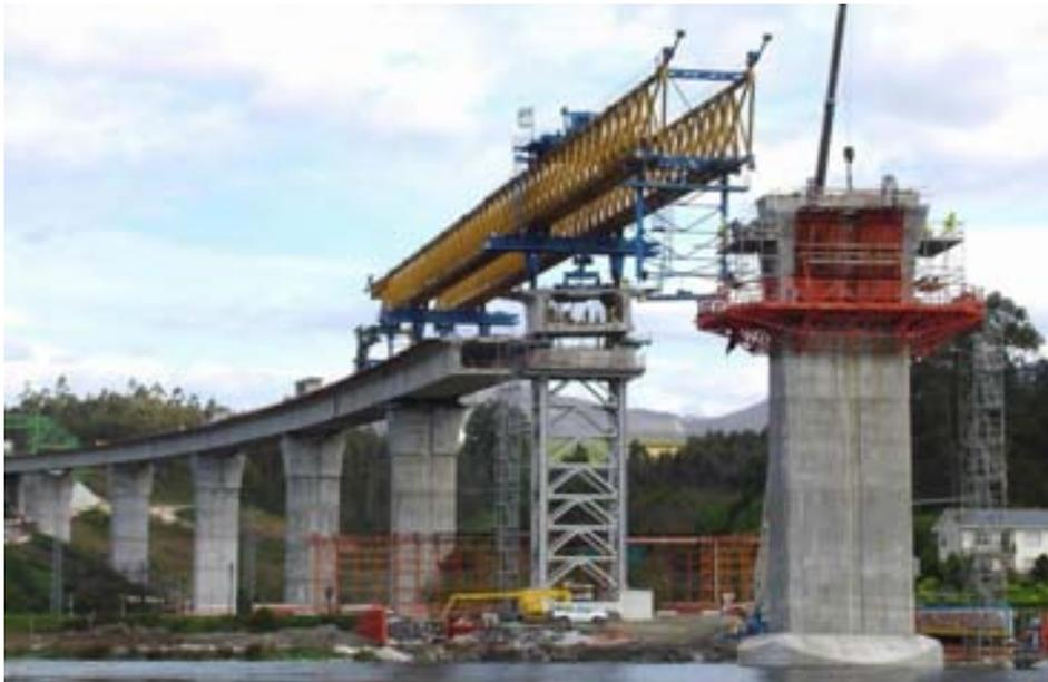
**Figura 3 Montaje de dovelas**
