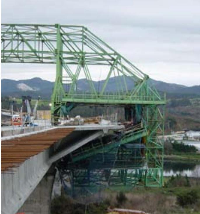
**Figura 4 Carro de hormigonado de voladizos**
