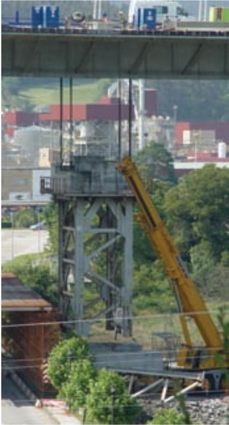
Figura 22. Retirada de pilas provisionales.
