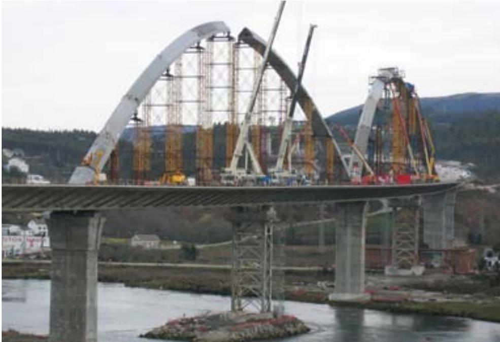
Figura 5 Montaje de los arcos
