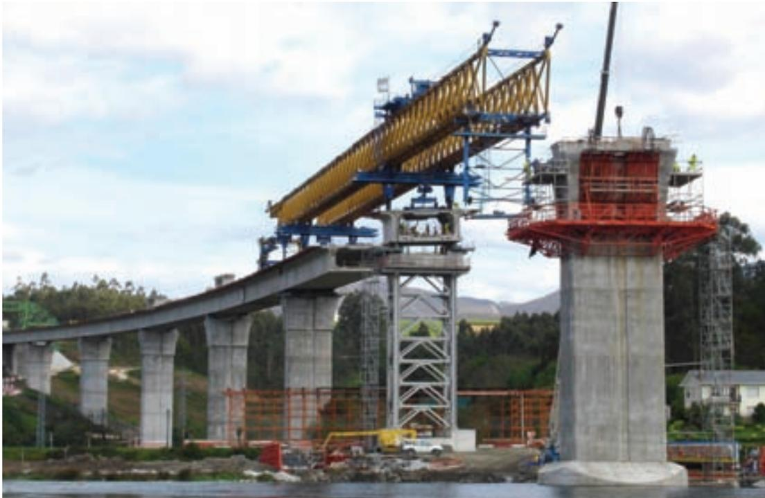
Figura 17. Montaje de dovelas.
