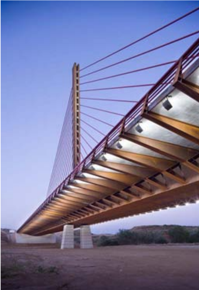
Fig. 1 Vista inferior tablero y plano de tirantes.
