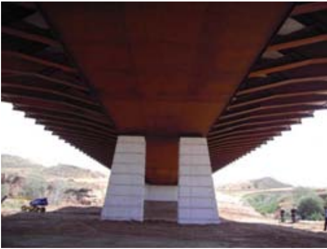
Fig. 4 Cajón metálico y costillas laterales del tablero.
