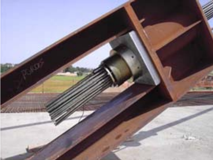
Fig. 2 Piezas especiales de anclaje de tirantes "cañones".
