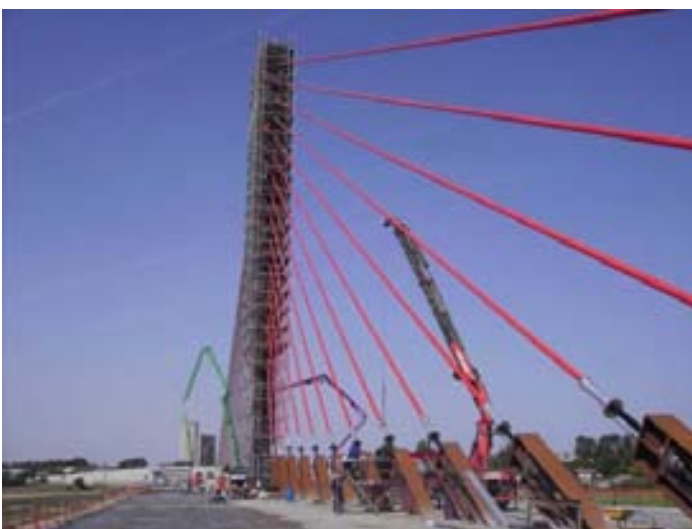
Fig. 5 Pilono central durante el tesado de tirantes.
