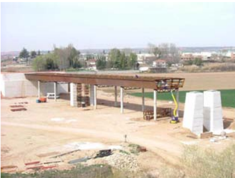
Fig. 6 Construcción del tablero metálico sobre pilas-pilote provisionales.
