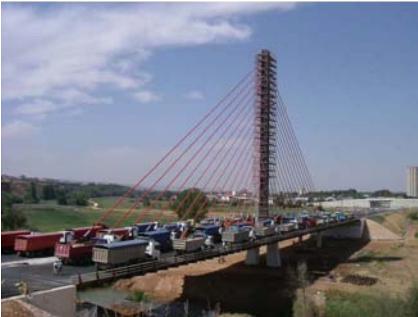
Fig. 8 Realización de la prueba de carga.
