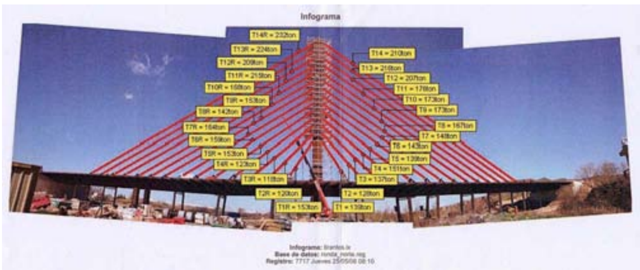
Fig. 9 Datos de la instrumentación de tirantes.
