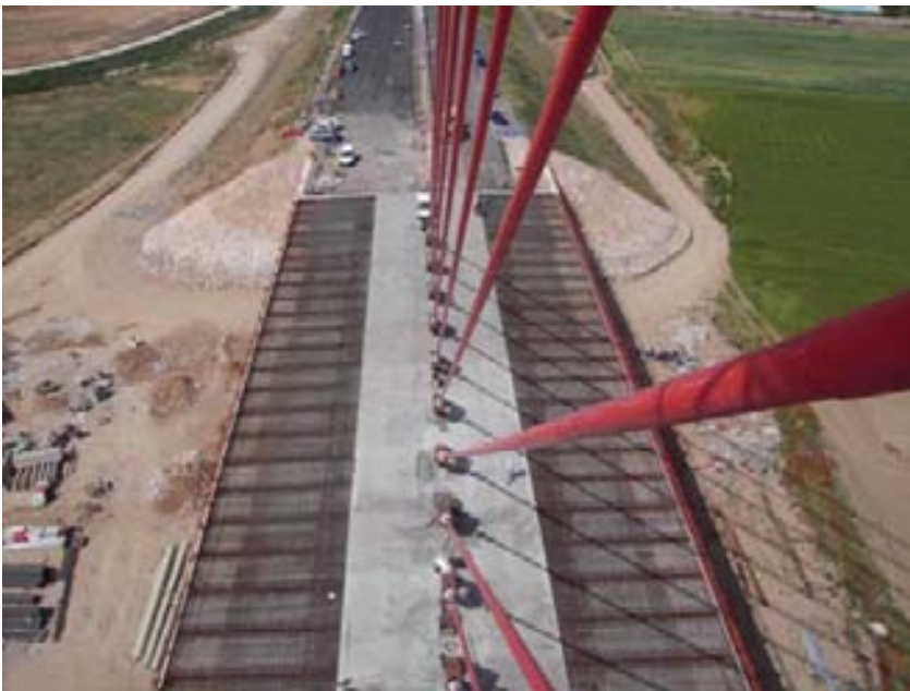
Fig. 7 Vista del tablero desde pilono con el tramo central de losa hormigonada.
