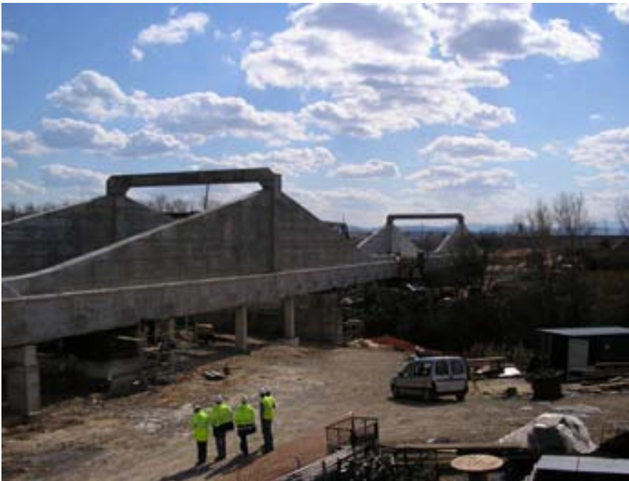
Fig. 4 Empuje (2ª fase). Apoyos provisionales para ejecución de tablero
