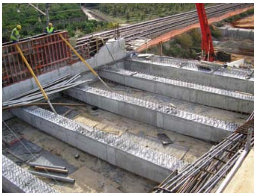
Fig. 9 Nervios transversales y encofrado de velas
