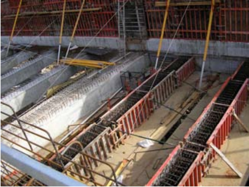
Fig. 5 Ejecución nervios transversales
