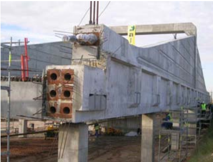
Fig. 6 Media madera del anclaje del tablero al estribo
