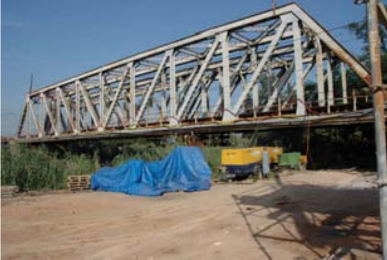
Fig. 2 Puente existente de Renfe
