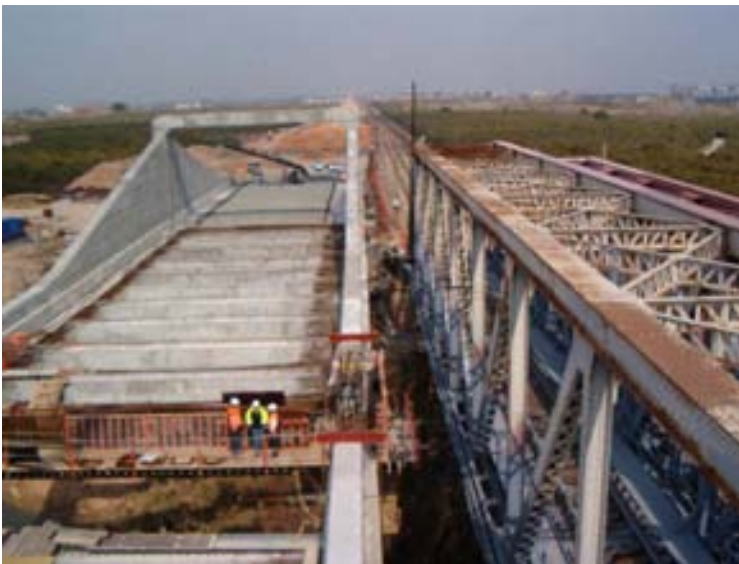
Fig. 12 Encofrado de dovela de cierre
