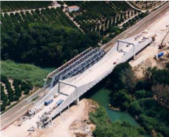
Fig. 1 Vista general del viaducto
