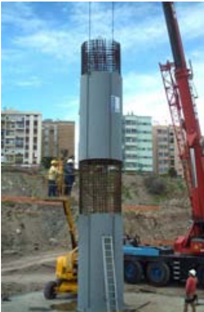
Fig.10 Colocación del encofrado de una pila
