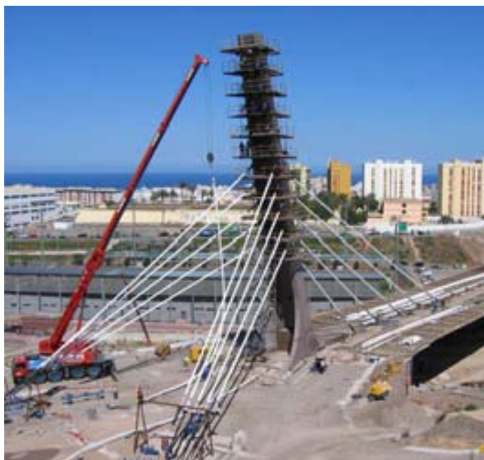
Fig.17 Colocación de tirantes y tesado de primera fase
