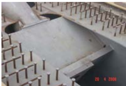
Fig.18 Detalle del anclaje de los tirantes en el tablero
