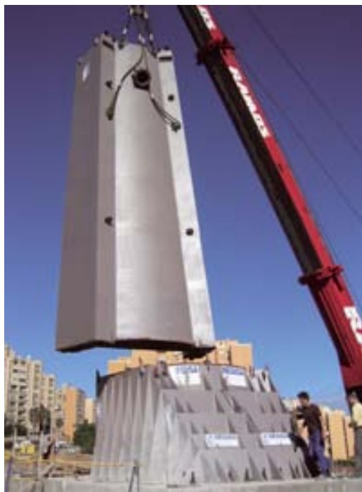
Figura 34. Izado de las 2 primeras dovelas del mástil. Figure 34. Hoisting of the first two segments of the pylon.
