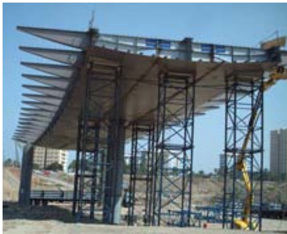
Fig.12 Apeo del tablero
