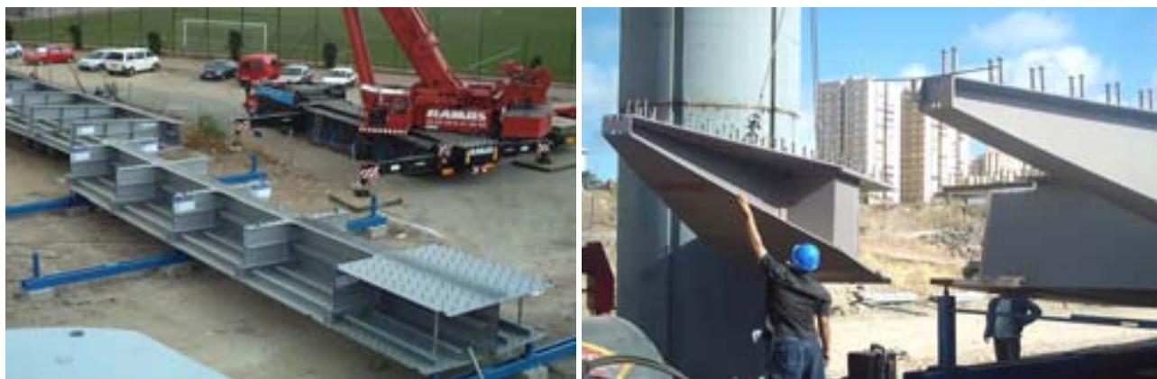
Fig.11 Unión en obra de las piezas metálicas del tablero
