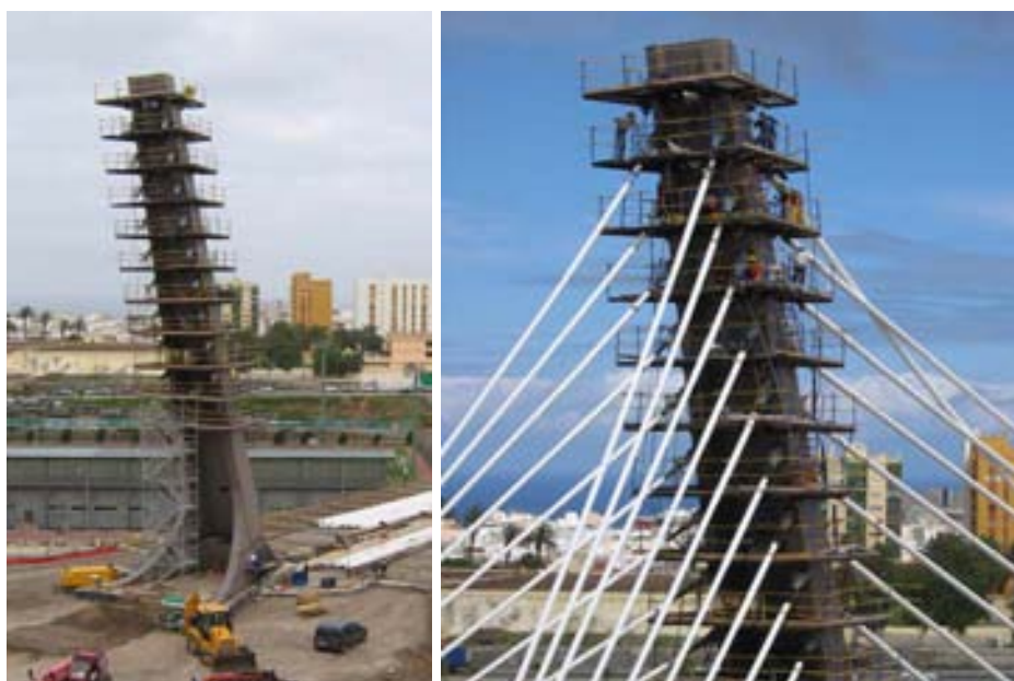
Fig.20 Andamio para el montaje y tesado de los tirantes
