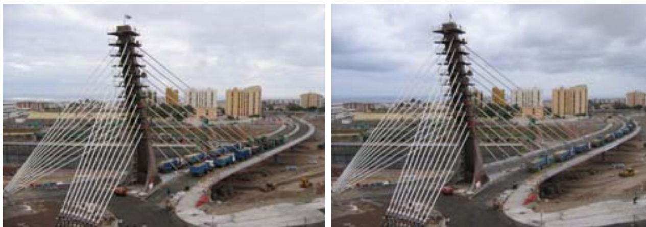
Fig.21 Distintas fases de la prueba de carga estática
