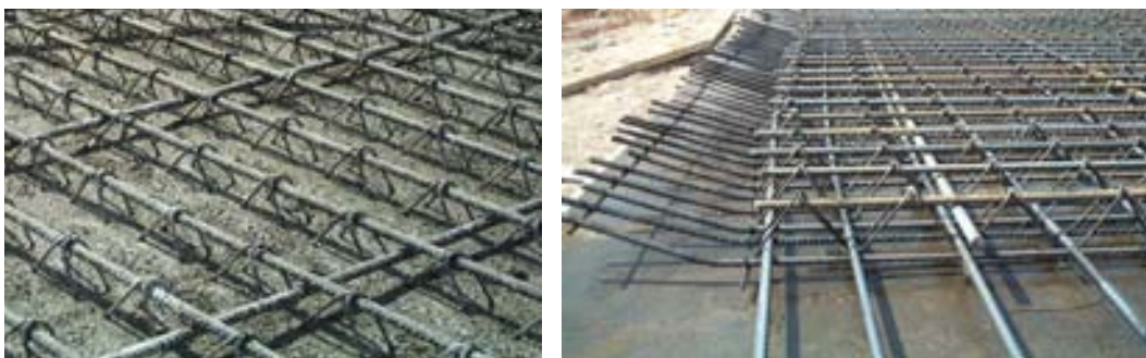
Fig.15 Prelasas colaborantes de celosía prefabricadas en obra
