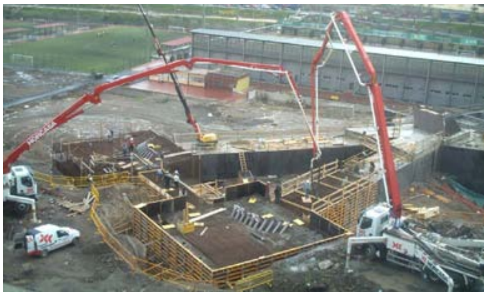
Fig. 8 Hormigonado del estribo 1
