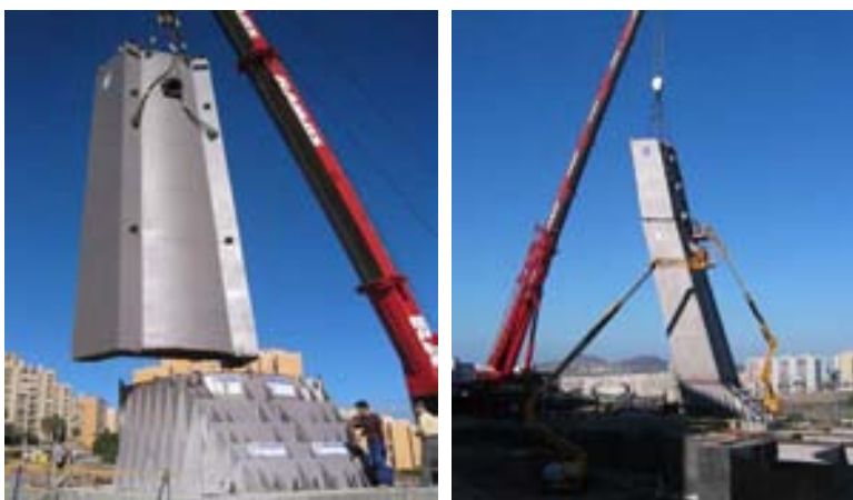
Fig.16 Montaje de dovelas del mástil
