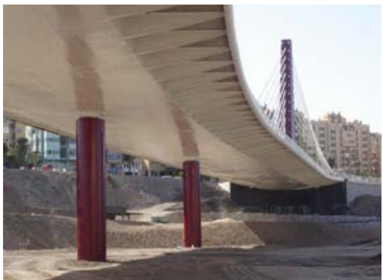
Fig. 4 Vista inferior del viaducto
