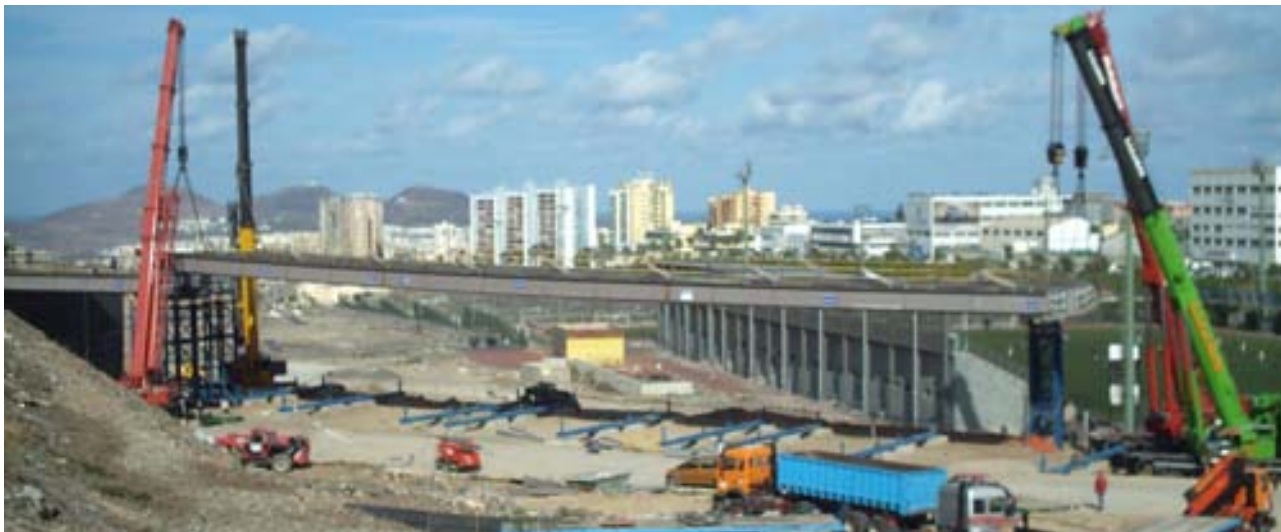
Fig.14 Izado de las dovelas 2, 3 y 4 del tablero.
