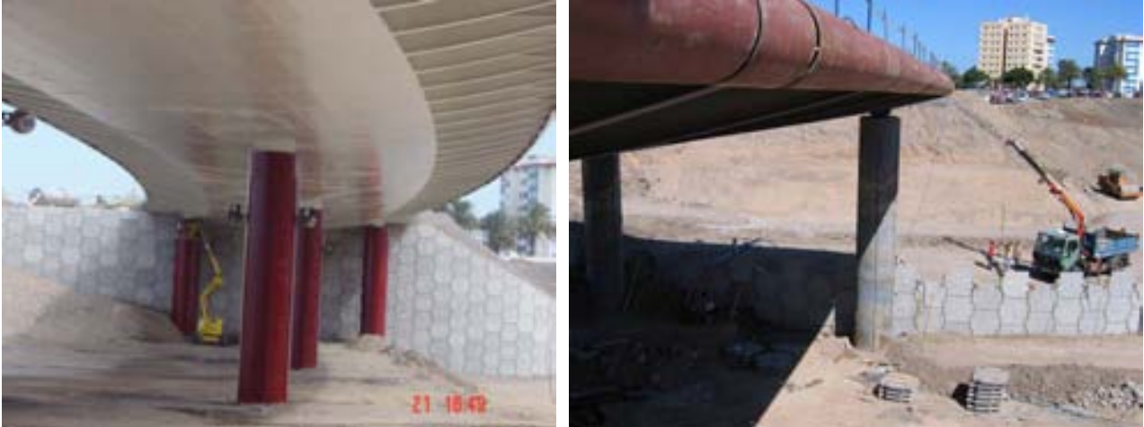
Fig.9 Vistas del estribo 2 en construcción
