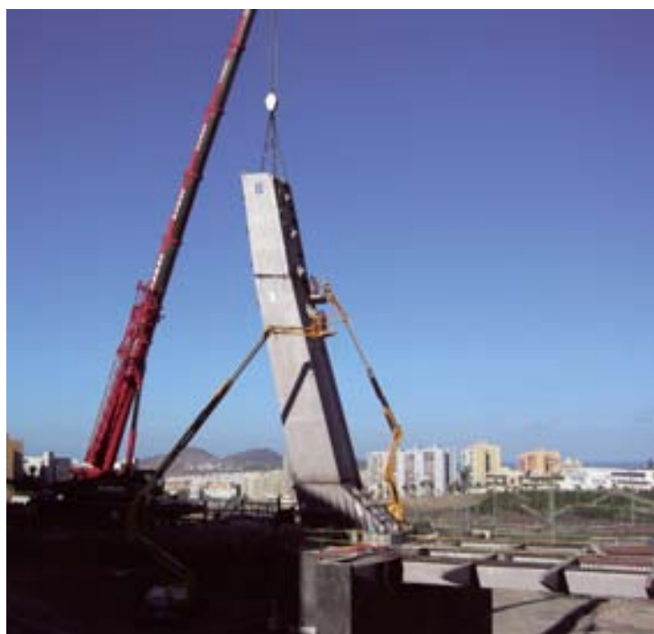
Figura 34. Izado de las 2 primeras dovelas del mástil. Figure 34. Hoisting of the first two segments of the pylon.
