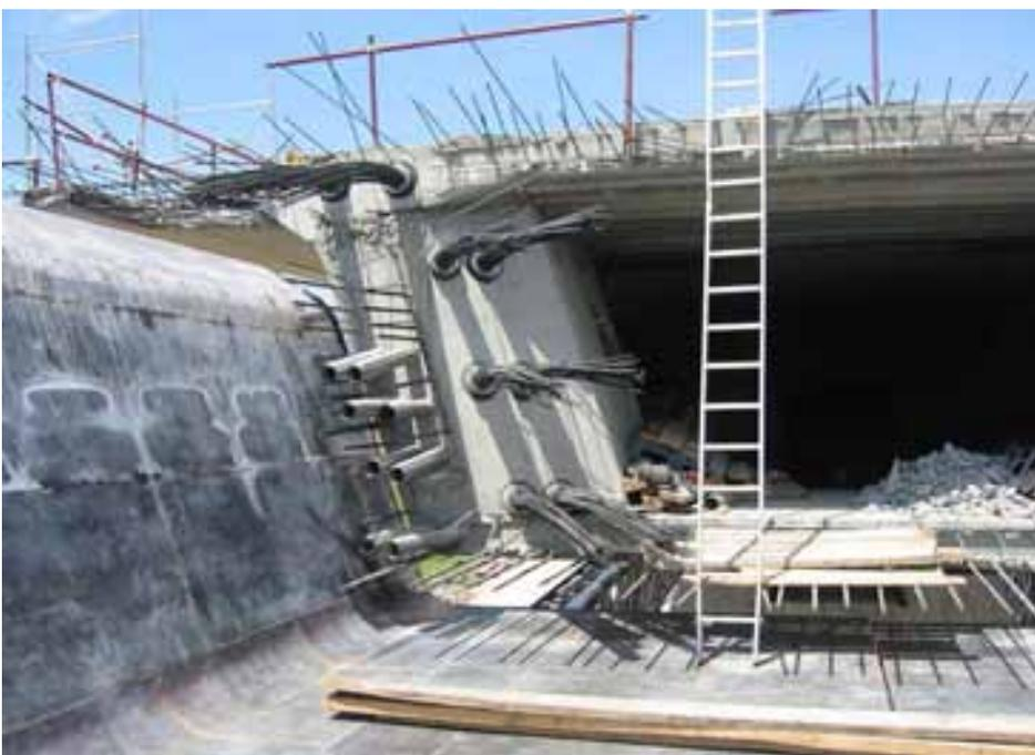
La familia 2 discurre por la tabla inferior del cajón, tiene una longitud de 28 m (excepto en las fases extremas, donde los cables miden 22.50 m) y se ancla en cuñas triangulares adosadas a la losa inferior. En definitiva, es un refuerzo a positivos que consta de entre 4 y 8 cables de 17 a 19 T 15, según las necesidades tensionales de cada fase.
