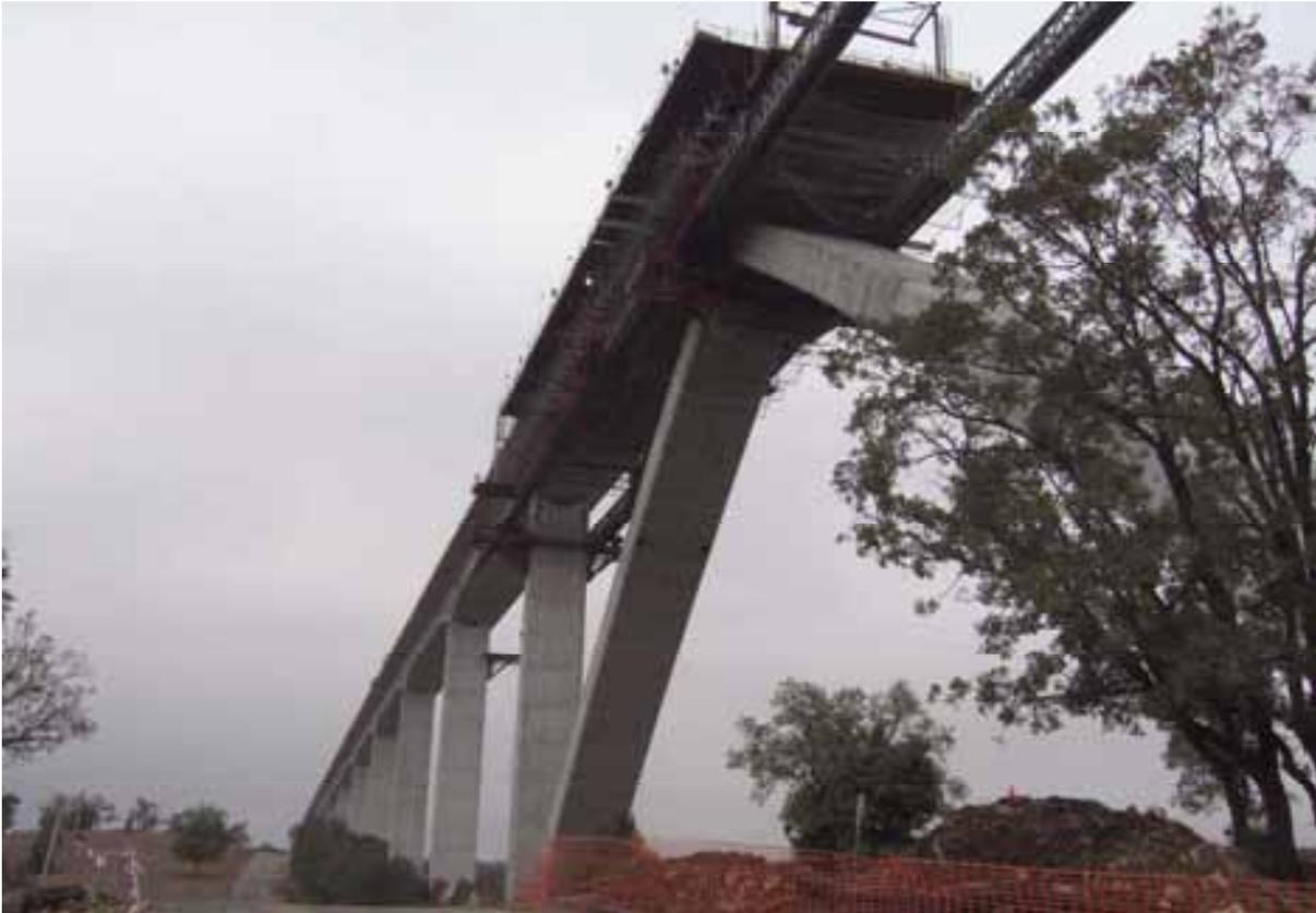
Una vez que la autocimbra llega al estribo 1 y se da por finalizada la ejecución del tablero, puede procederse al desmontaje de la estructura metálica y se termina de construir el estribo con su correspondiente junta. Queda todavía pendiente la labor de remate de los diferentes tajos, restitución del terreno y limpieza.
