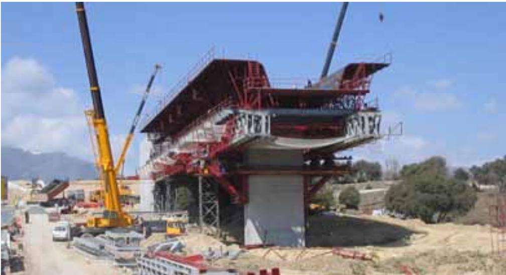
*Fig. 2 Encofrado sección del tablero.*
