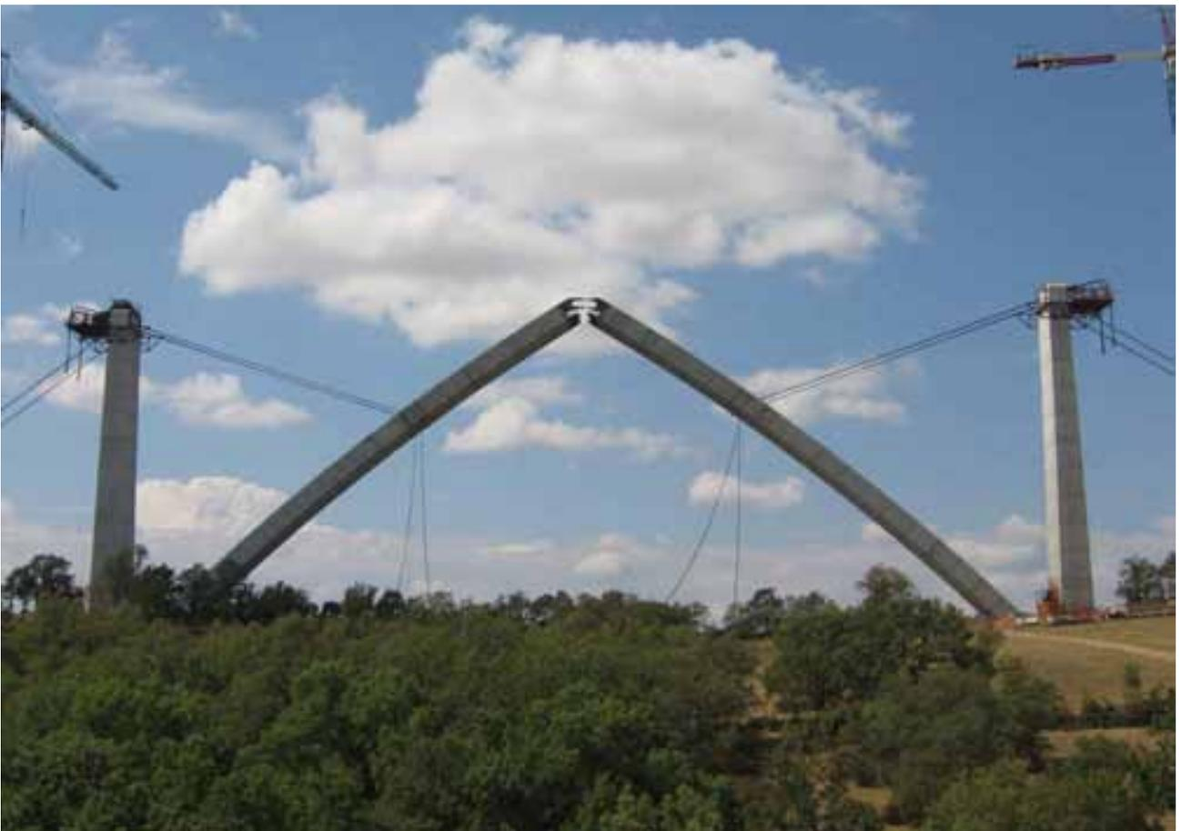
Cuando ambos están en posición, se dispone un encofrado en clave y se hormigonan esta zona y el tetón que unirá el arco con el tablero.
