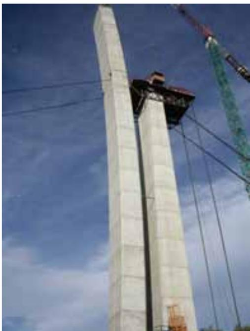
*Fig. 6 Ejecución de semiarcos con encofrado trepante*
