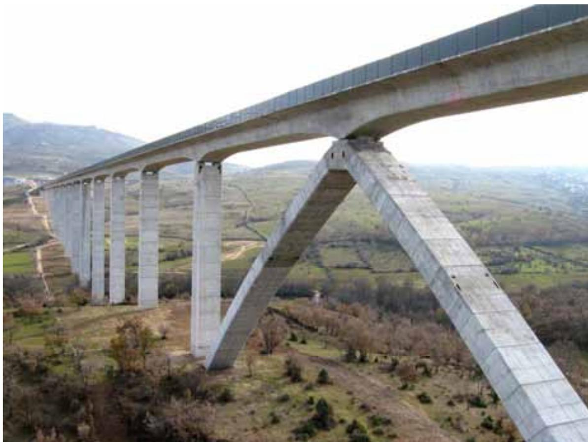
*Fig.3 Conexión tablero-arco.*
