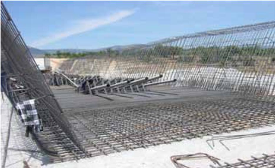
A pesar de que la cimbra se fabricó expresamente para este viaducto, no tenía capacidad suficiente para sustentar la sección transversal completa en vanos tan largos como los que nos ocupan. Se indicó anteriormente que la sección se hormigonaba en dos etapas: primero una U (tabla inferior y almas) que posteriormente, tras la colocación de las prelasas, se completaba con la tabla superior y los voladizos.
