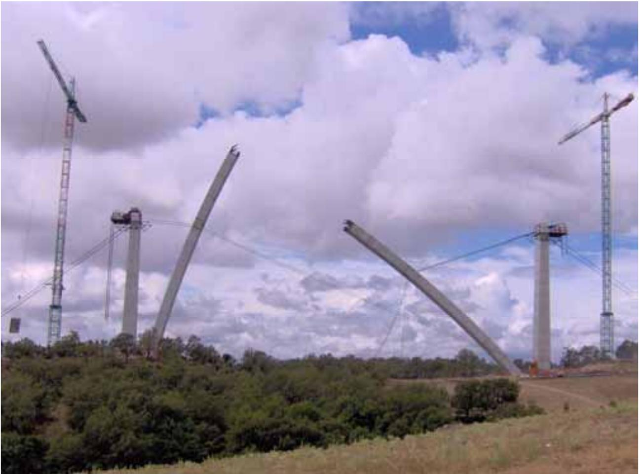
*Fig. 7 Construcción de semiarcos por abatimiento*
