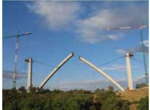
Se actúa alternativamente sobre los gatos de abatimiento (situados en la coronación de la pila puntal) y los de retenida (en la zapata de la siguiente pila), controlando los esfuerzos en la pila puntal por medio del control de los movimientos en cabeza hasta situar el semiarco en su posición final. A continuación se procede de forma similar con el otro semiarco.
