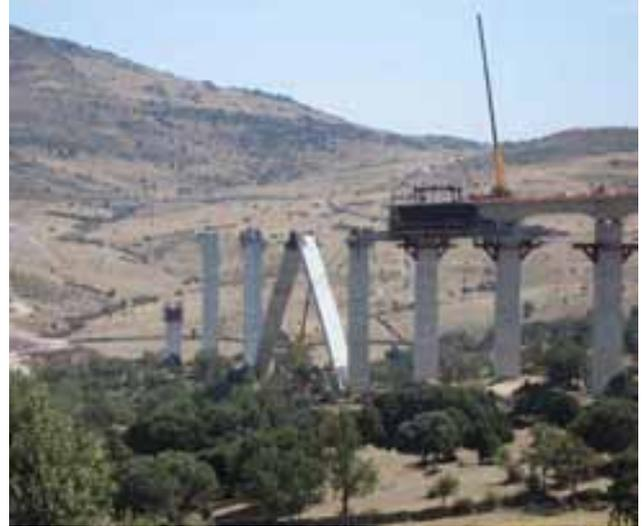
A continuación se bloquean las rótulas y se hormigonan los arranques, configurando un arco biempotrado.
