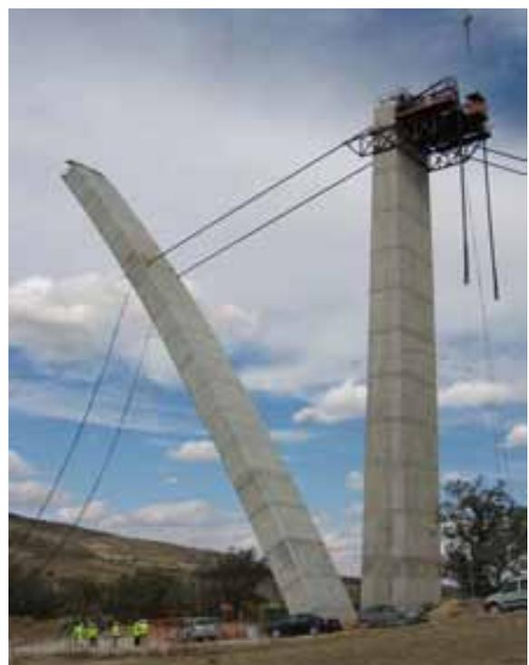
A continuación comienza el abatimiento del primer semiarco utilizando la pila vecina como puntal, disponiéndose dos familias de tirantes: los de retenida, dispuestos desde la cabeza de la pila puntal hasta la zapata de la siguiente pila y los de abatimiento, dispuestos desde la pila puntal a una traviesa-macizado prevista en la sección hueca del semiarco a 53.11 m de la base.
