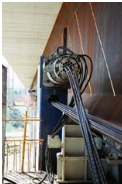
Figs. 16a y 16b. Cables de empuje (inferiores) y de retenida (superiores) del Estribo 1. Figs. 16a and 16b. Launching cables (bottom) and guy cables (top) of Abutment 1.
