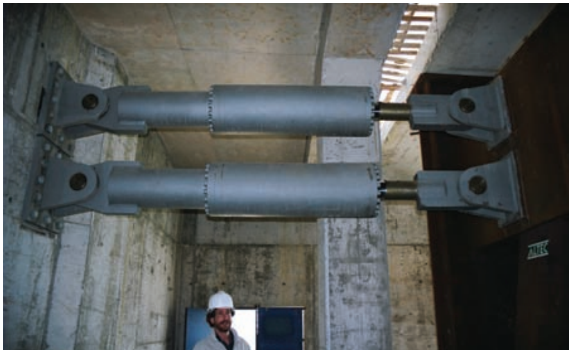
Fig. 36. Amortiguadores-Transmisores de Impacto Viscosos Longitudinales. Fig 36. Longitudinal Viscous Impact Shock Absorbers-Transmitters.
