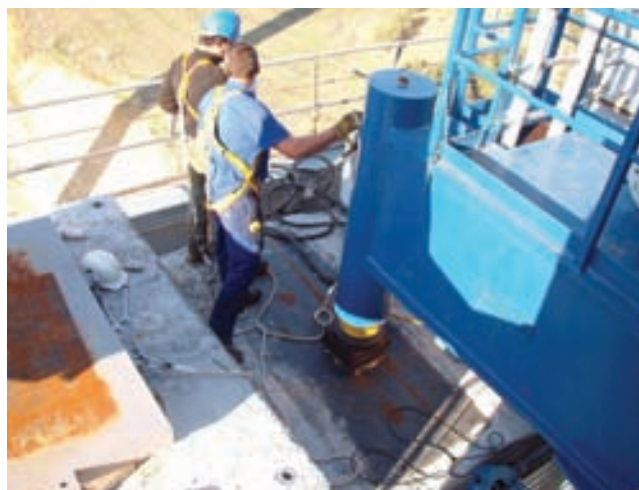
Fig. 20. Detalle del gato frontal y el gato en la nariz Fig. 20. Detail of the front jack and the nose jack.
