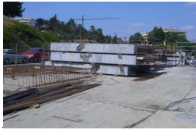
Figuras 13 y 14. Enhebrado del pilono en cimentación. Parque de fabricación del tablero.
