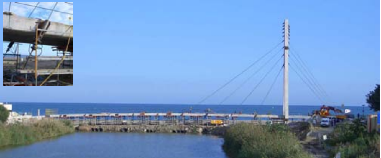
Figura 15. Proceso de enhebrado de los cables y detalle del puente de tesado.
