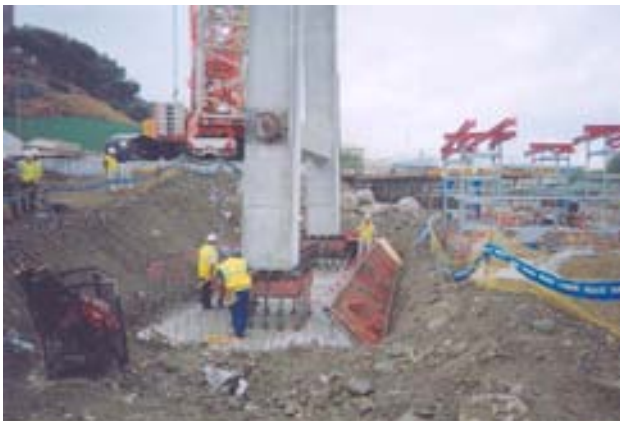
Figuras 13 y 14. Enhebrado del pilono en cimentación. Parque de fabricación del tablero.
