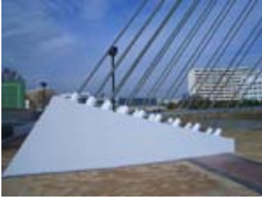
Figuras 4, 5 y 6. Detalles de anclaje en contrapeso, cabeza de pilono y tablero.
