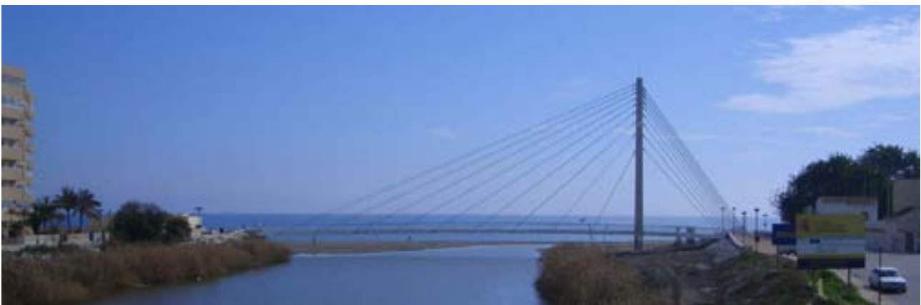
Figura 1. Vista general de la estructura
