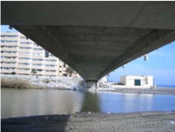
Figura 2. Vista inferior del tablero
