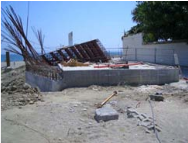
Figuras 7 y 8. Detalles de ejecución contrapeso y encepado de pilono.
