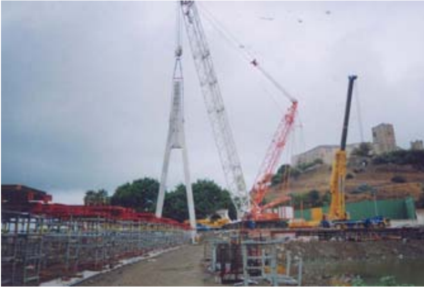
Figuras 11 y 12. Izado y colocación del pilono
