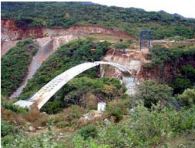
Fig. 5 Montaje del arco de la cimbra mediante voladizos atirantados
