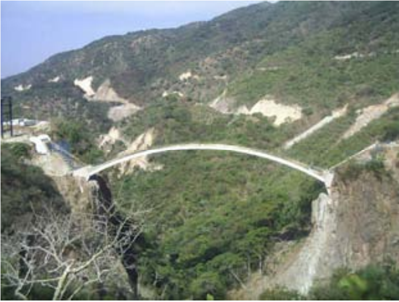
Fig. Hormigonado del arco
