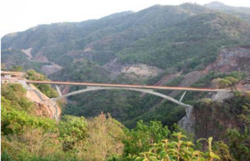
Fig. 4 Puente San Sebastián
