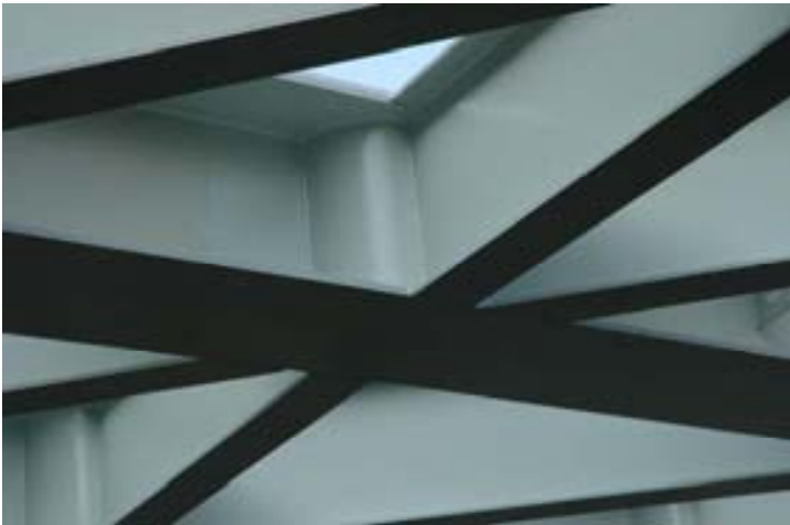
Fig. 8 Nudos del tablero
