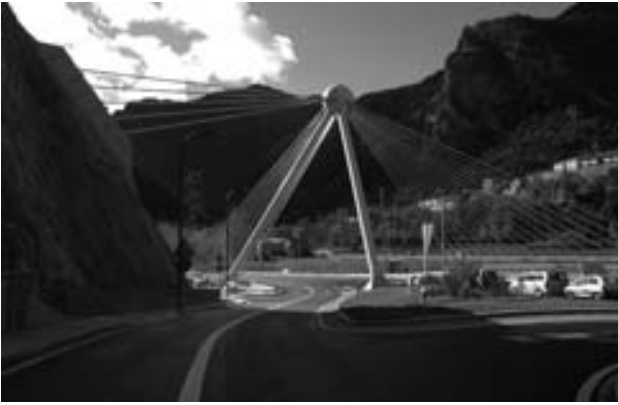
Figura 13. Puente de Madrid.
