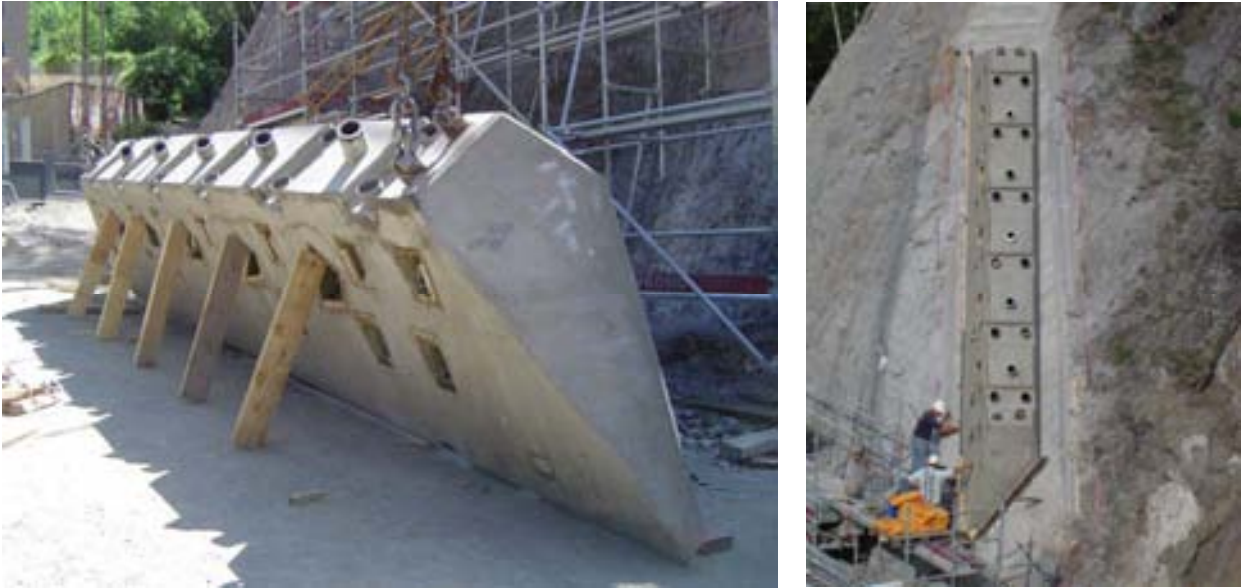
Fig. 11 La pieza prefabricada de anclaje de los tirantes de compensación y de los anclajes a la roca
