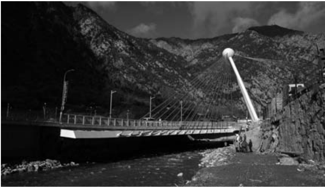
Figura 24. El puente de Madrid terminado.
