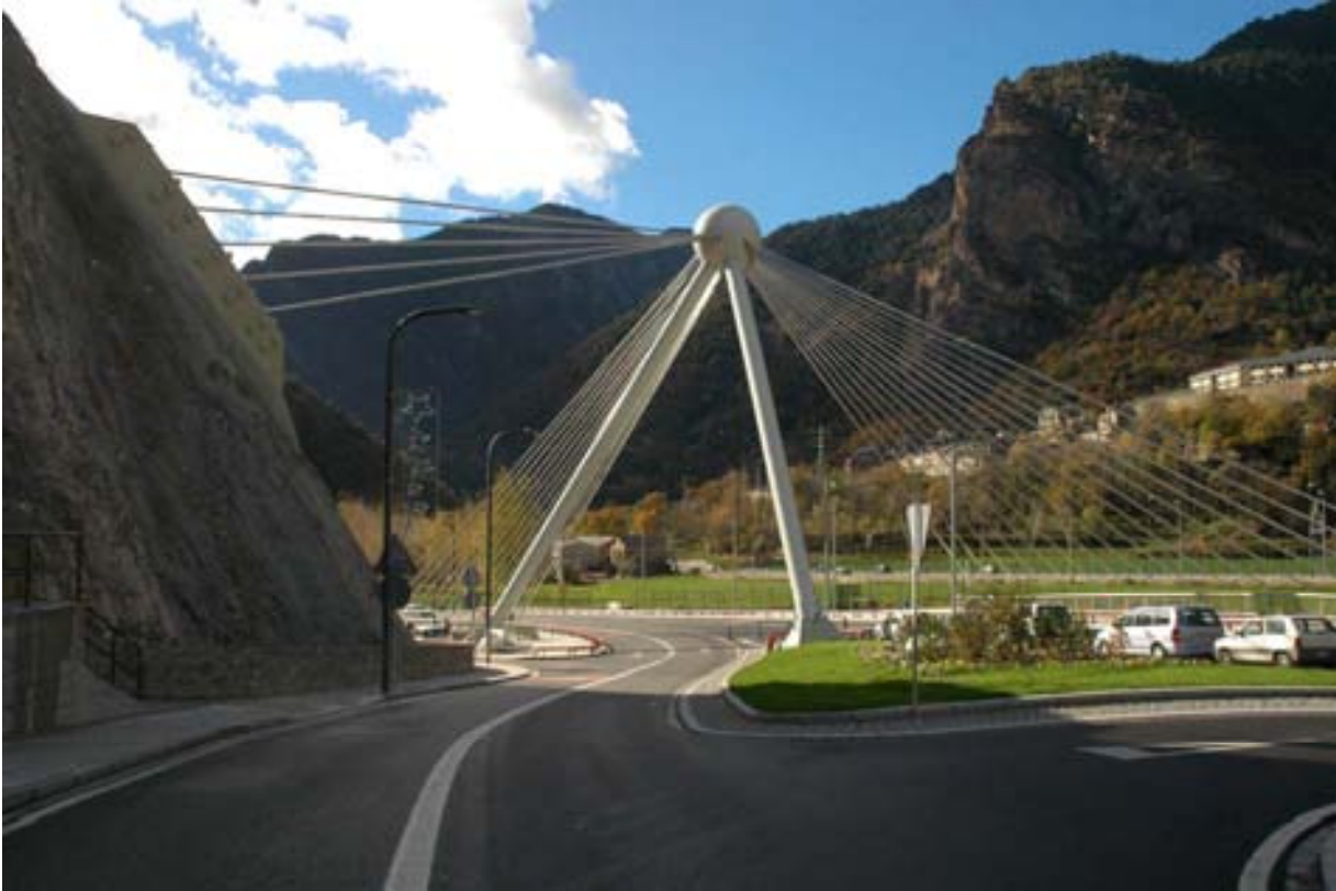
Fig. 15 El puente terminado
