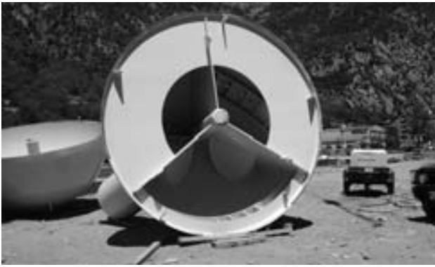
Figuras 19a y 19b. Las semiesferas del puente de Madrid antes del montaje.
