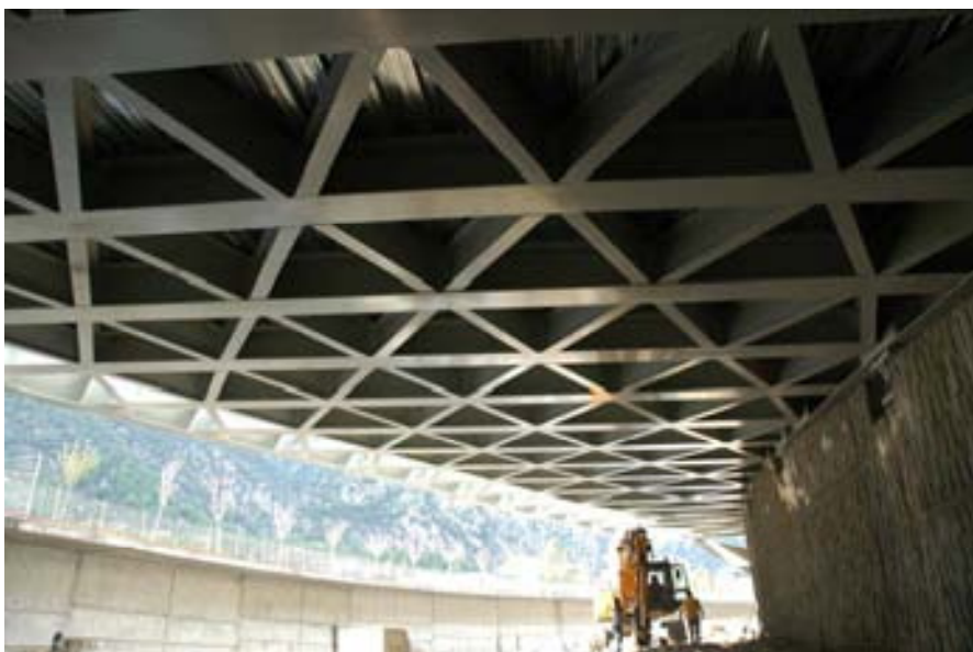
Fig. 7 Vista inferior del tablero
