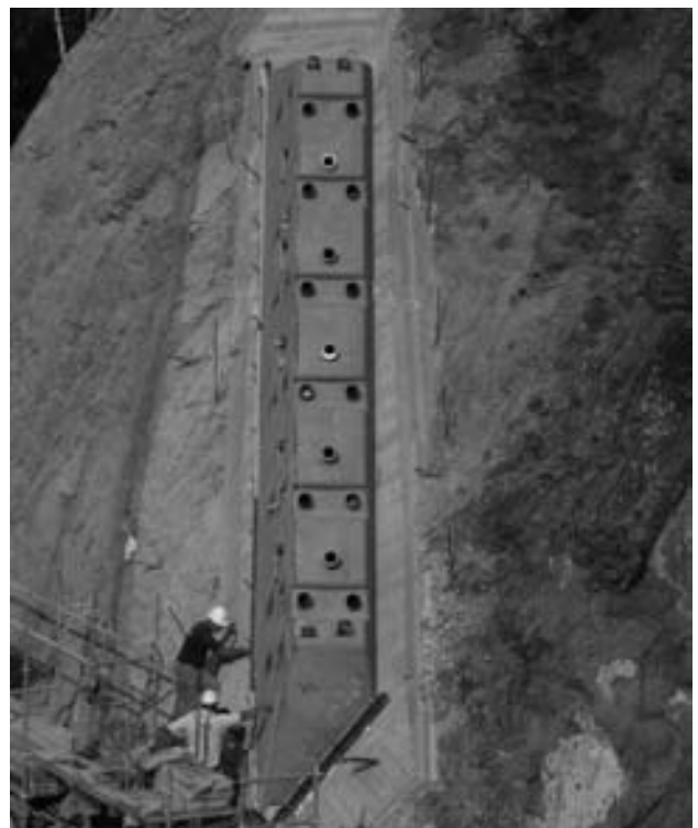
Figuras 21a y 21b. Macizo de anclaje de los tirantes de compensación. a) El anclaje en el suelo. b) El anclaje en su posición definitiva.
