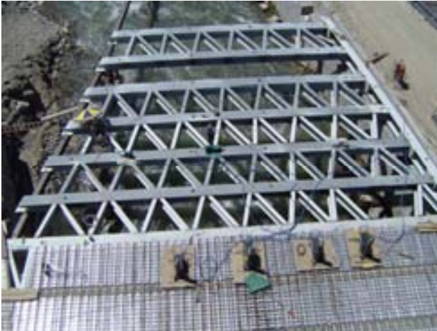
Fig. 13 Construcción del tablero con apoyos provisionales
