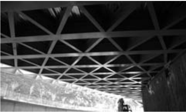
Figura 16. Vista inferior del tablero.
