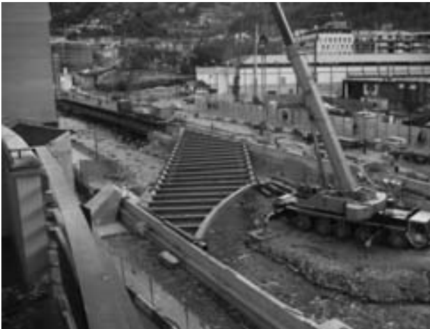
Figura 10. Montaje de la primera fase del tablero.
