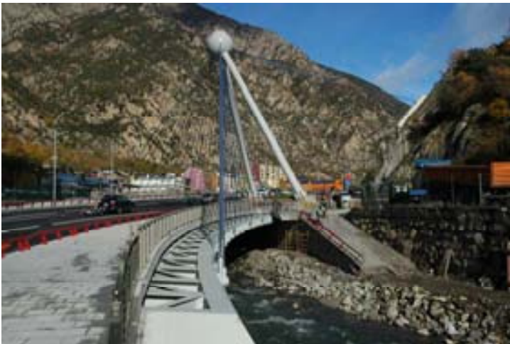
Fig. 9 Viga de borde y anclajes de los tirantes
