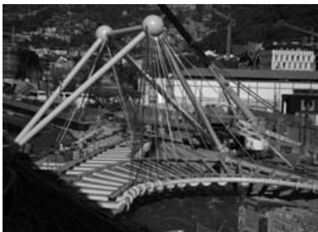
Figura 9. Estructura del tablero del puente de París.
