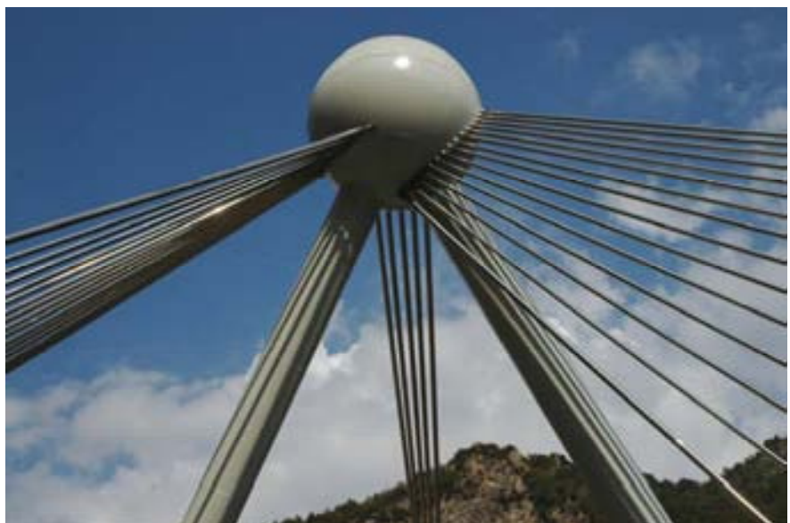
Fig. 3 Esfera de anclaje de los tirantes del puente de Madrid
