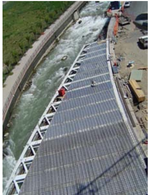
Fig. 14 El tablero desde la esfera antes de hormigonar la losa
