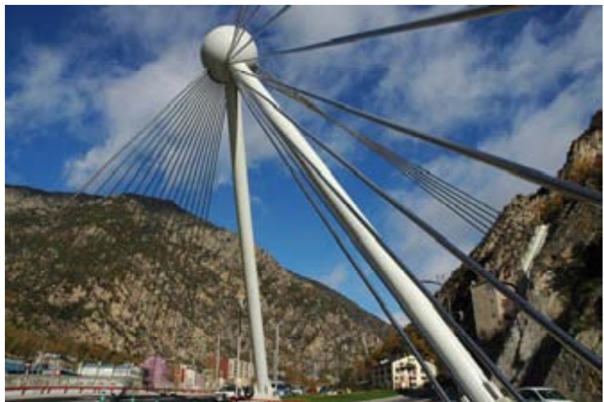
Fig. 6 El bípode, la esfera y el anclaje a la roca
