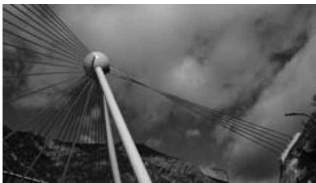
Figura 15. Tirantes anclados en la roca.
