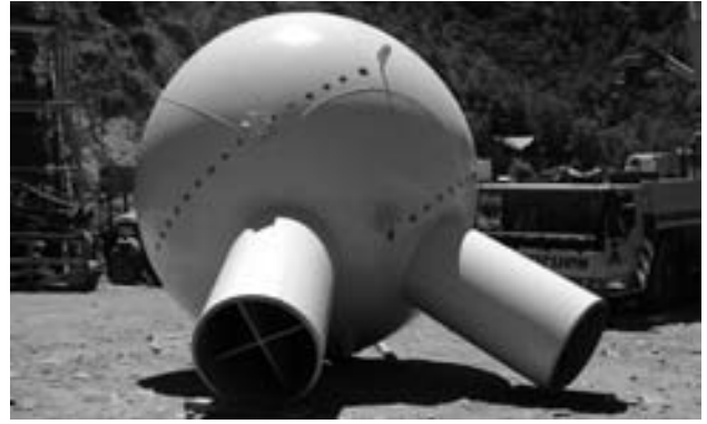
Figuras 19a y 19b. Las semiesferas del puente de Madrid antes del montaje.
