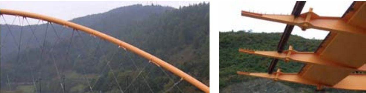
Figs. 11a y 11b Detalles de anclajes superiores e inferiores de las péndolas
