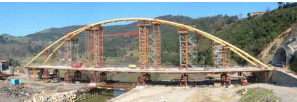
Fig. 14 Vista del arco y tablero apeados
