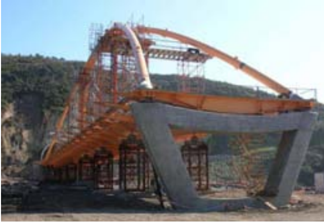
Fig. 15 Vista del arco y tablero apeados
