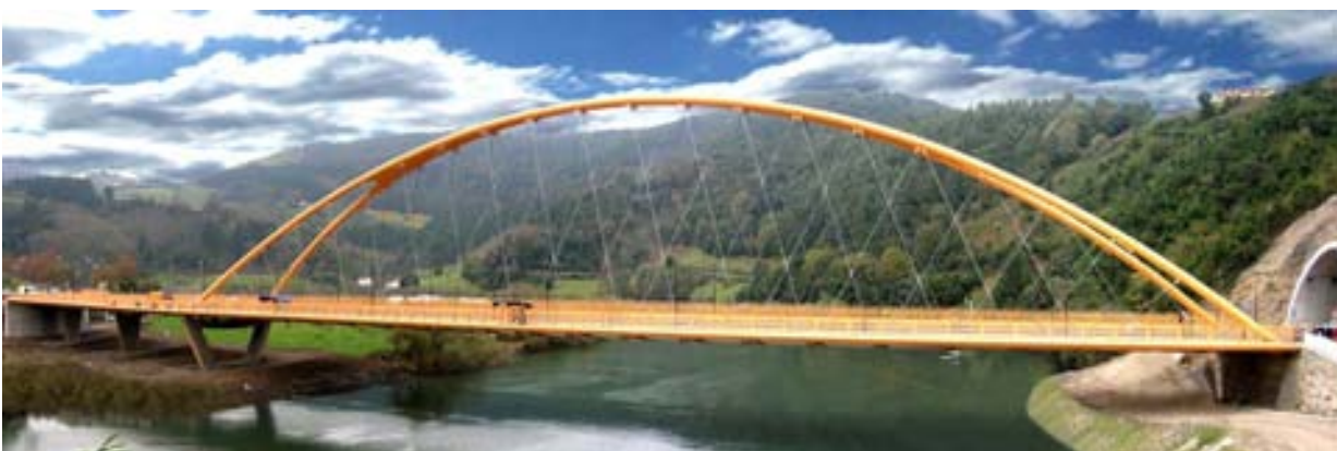
Fig. 5 Vista desde aguas abajo
