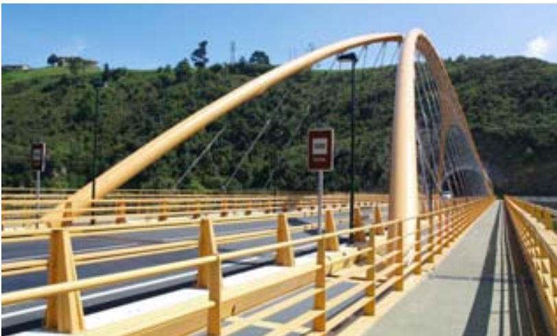
Fig. 4 Vista de las aceras voladas laterales
