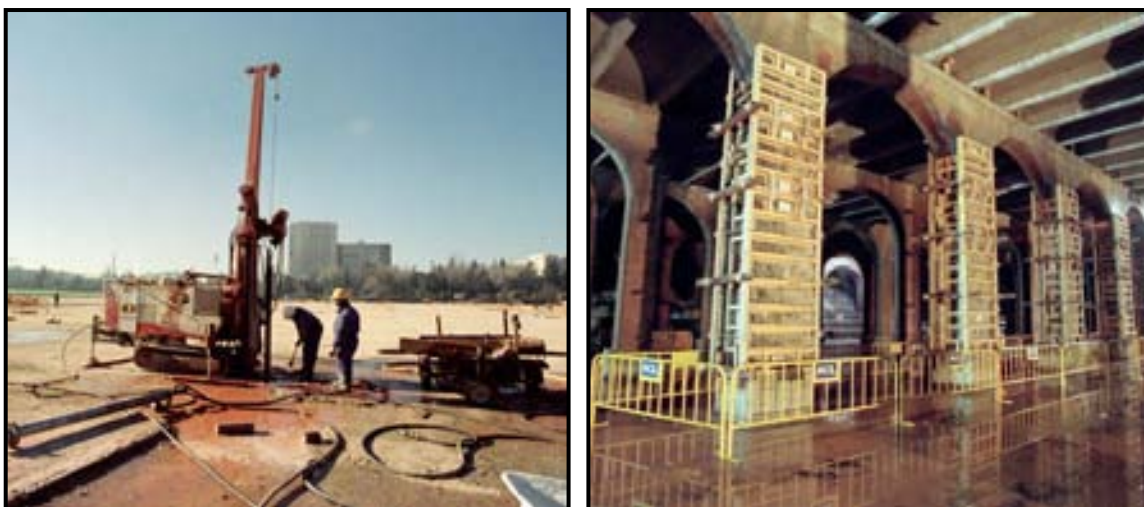
Figura 10. Ejecución de taladros y zunchado de pilares durante la perforación
