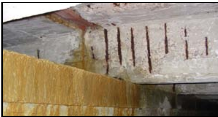
Figura 3. Situación de la cubierta existente
