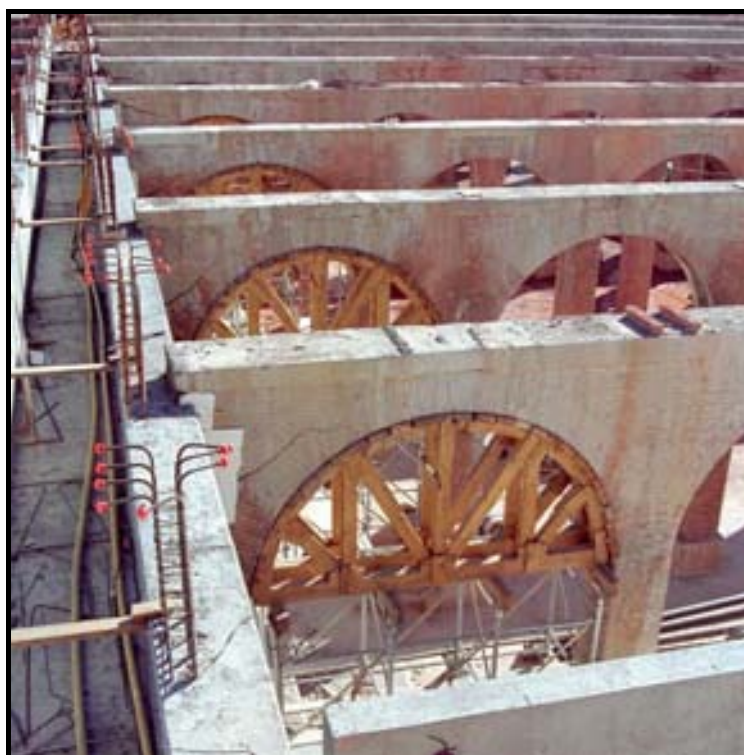
Figura 5. Cimbrado de arcos extremos
