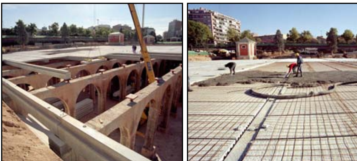
Figura 15. Ejecución de la nueva cubierta
