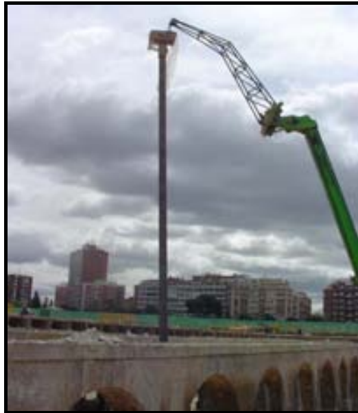
Figura 13. Colocación de refuerzo en pilastras
