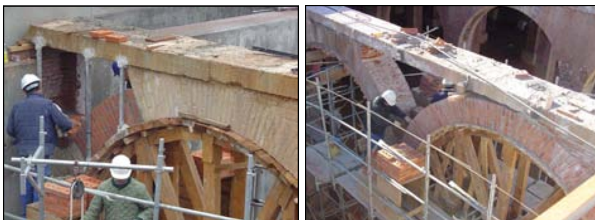
Figura 6. Reparación de arcos extremos
