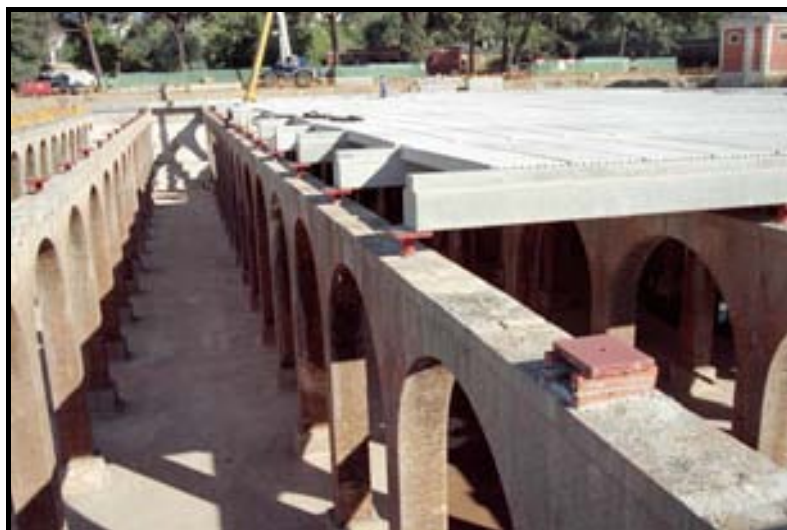
Figura 14. Colocación de refuerzo en pilastras
