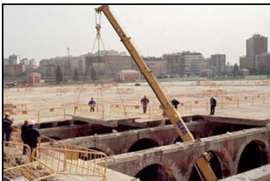
Figura 12. Izado de piezas desde el interior
