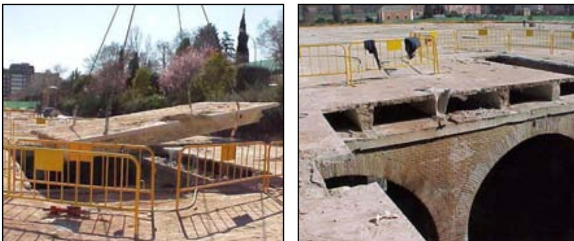
Figura 11. Demolición cubierta existente
