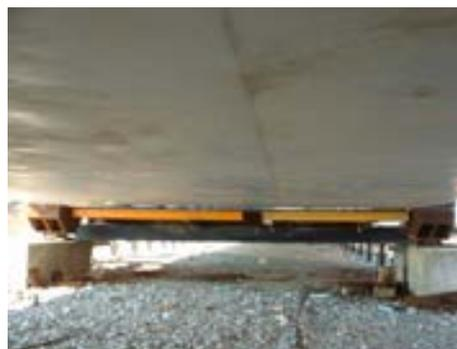
Los extremos de la plataforma de encofrado se aprovecharon para situar en ellos sendos patines de deslizamiento, con lo cual el desplazamiento en la zona de montaje se efectuó con un máximo de tres apoyos, los dos fijos de los extremos del encofrado y el patín rodante trasero.
