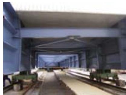
La necesidad de losa de hormigón en la zona inferior sobre pilas, para disponer la doble acción mixta, al ser la estructura bixácena sin chapa de fondo, se estudió con varias alternativas: la disposición en esa zona de un encofrado perdido, o una prelosa de hormigón, o bien el hormigonado de la losa antes de salir del área de montaje. Se optó por esta última solución, disponiendo en un tramo de la zona de montaje situado a una distancia entre 24 y 48 metros del
