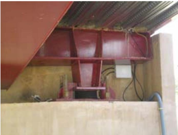
*Fig. 4 Apoyo de neopreno con dispositivo anti-levantamiento.*
