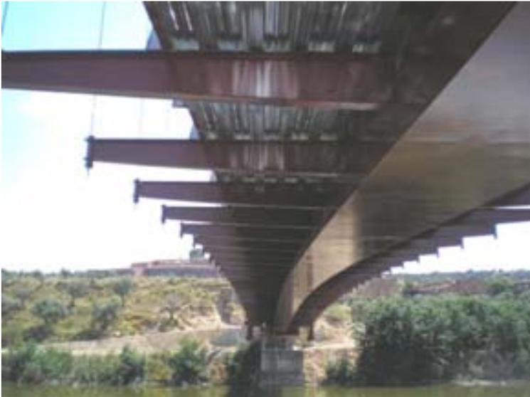
*Fig. 2 Cajón metálico y costillas laterales del tablero.*
