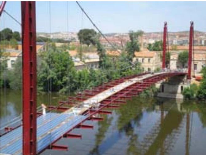
*Fig. 6 Montaje de chapa colaborante para ejecutar la losa de hormigón.*
