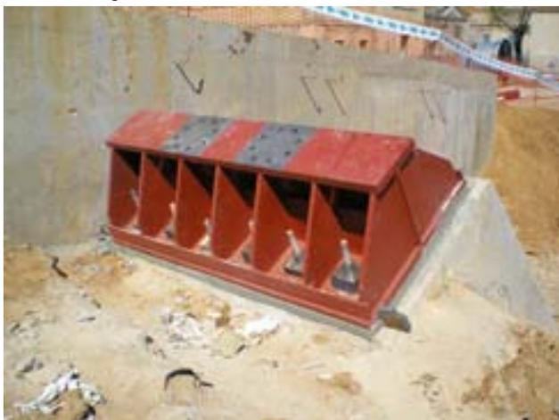
Fig. 3 Pieza especial de unión tubos retenida y anclajes al terreno.
