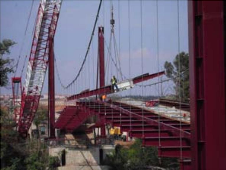
*Fig. 5 Colocación del tramo central del tablero.*
