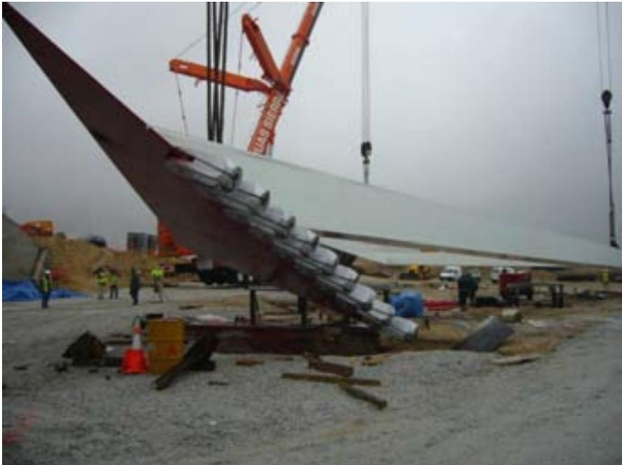
*Fig. 10 Izado con grúa de cada uno de los pórticos metálicos triangulares del mástil*
