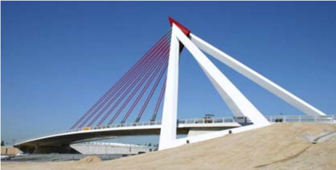
*Fig. 7 Vista posterior de los pórticos triangulares del mástil con el puente terminado.*
