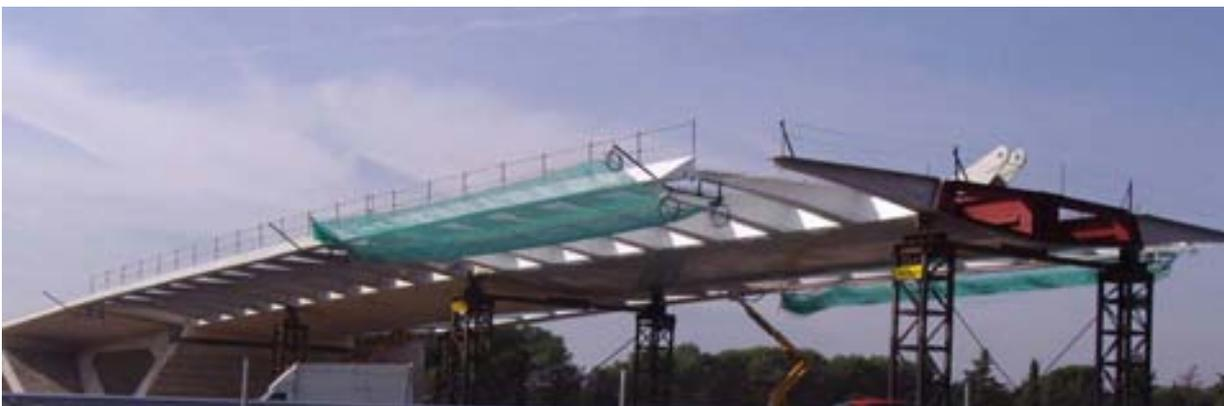
Fig. 9 Montaje de la estructura metálica de tablero sobre apeos provisionales
