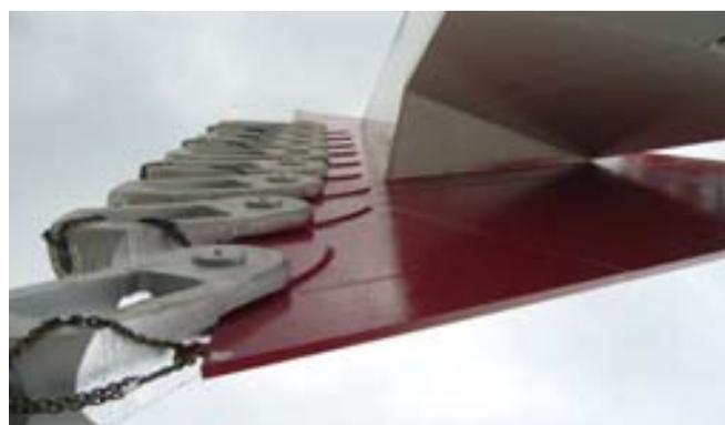
Fig. 6 Anclajes inferiores activos y superiores pasivos de tirantes.
