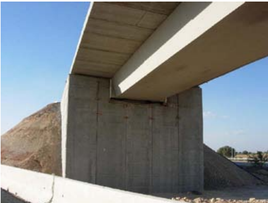
Fig. 12: Vista del tablero apoyando en uno de los estribos.
