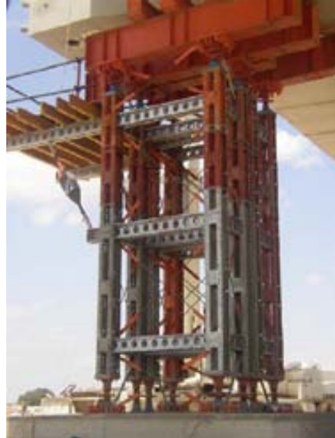
Fig 20. Detalle de torreta de apoyo provisional de riostra
