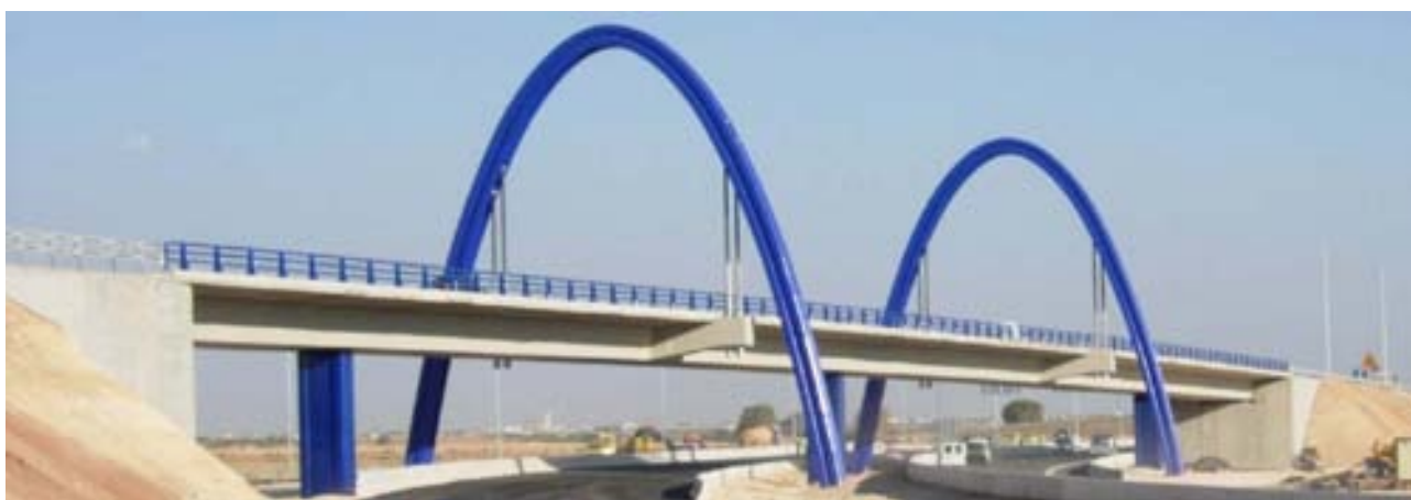
Fig. 1: Vista general de la estructura
