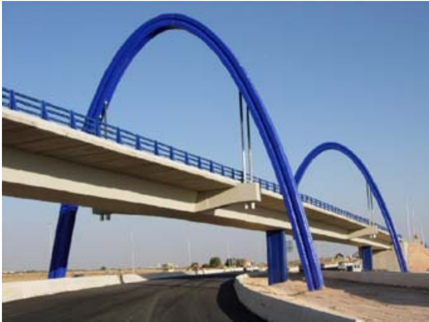
Fig 33. Vista general de la estructura E-163 en el enlace de La Roda
