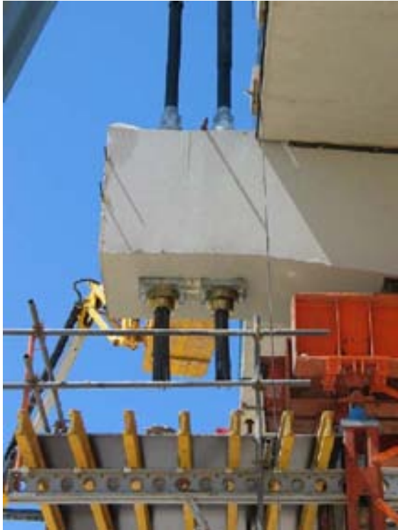
Fig 16. Detalle de anclaje activo de péndolas
