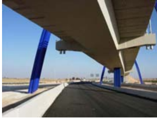
Fig. 3: Vista de la estructura desde el tronco de la AP36
