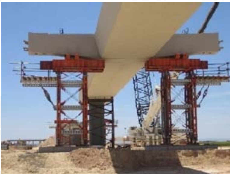
Fig 21. Riostra y vigas artesa durante su colocación
