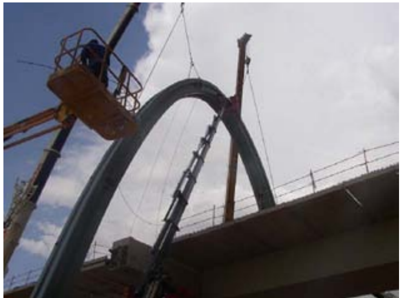
Fig 26. Unión en clave
