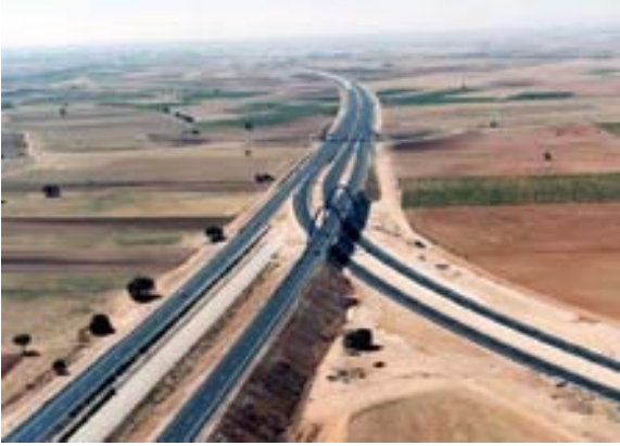
Fig. 2: Vista general del enlace
