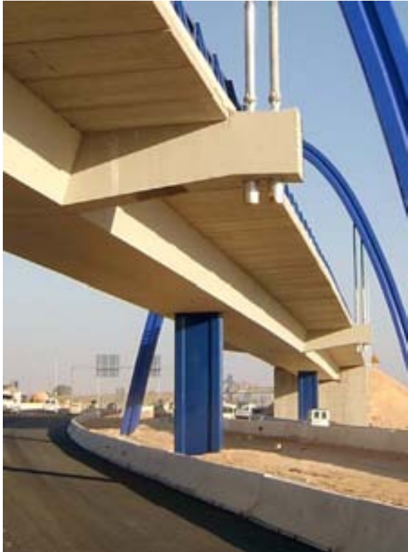
Fig. 10: Aspecto final de las pilas en el conjunto.
