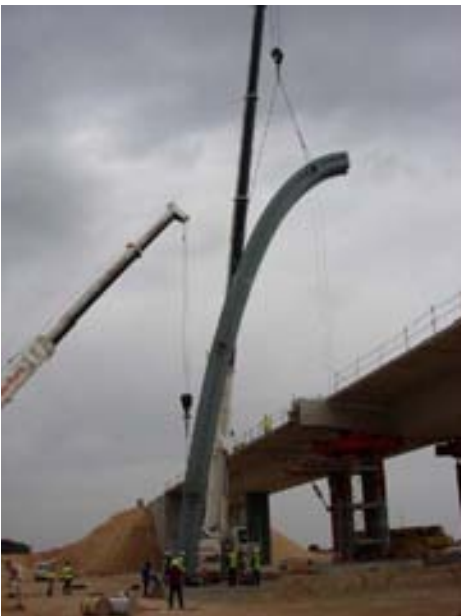
Fig 25. Izado de semiarco
