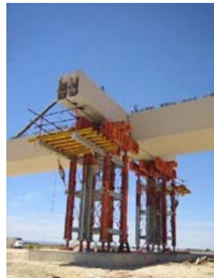
Fig 22. Unión de riostra y vigas artesa
