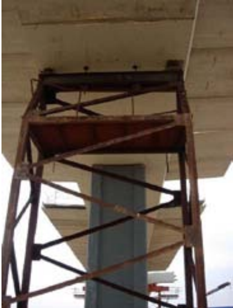
Fig 19. Vista de apoyo de vigas en torreta provisional
