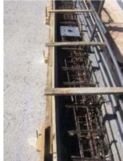
Fig 24. Hormigonado de capa de compresión
