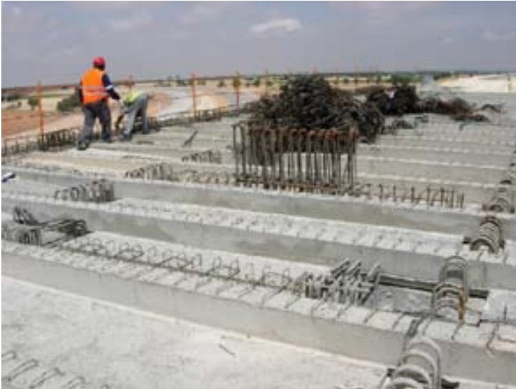
Fig 23. Colocación de prelosas
