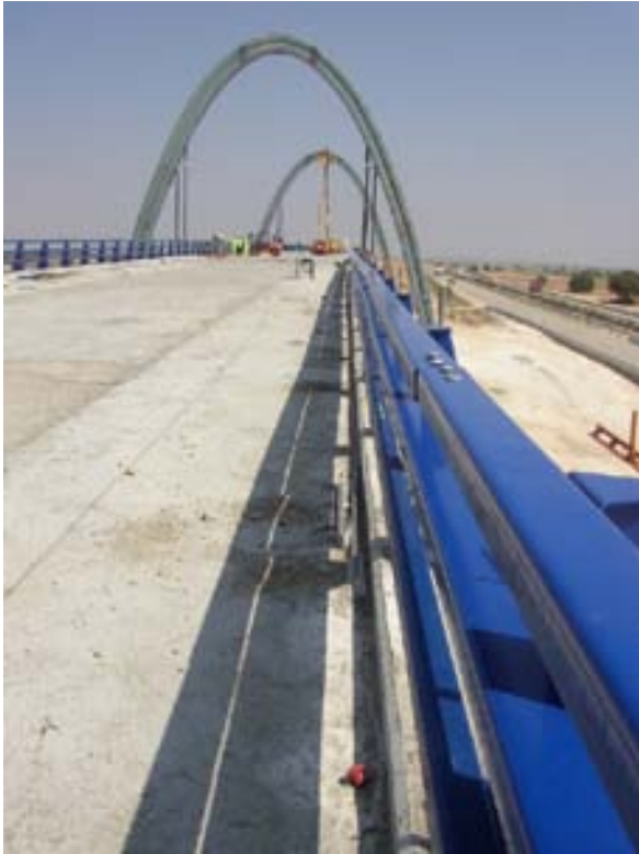
Fig 29. Colocación de barrera metálica
