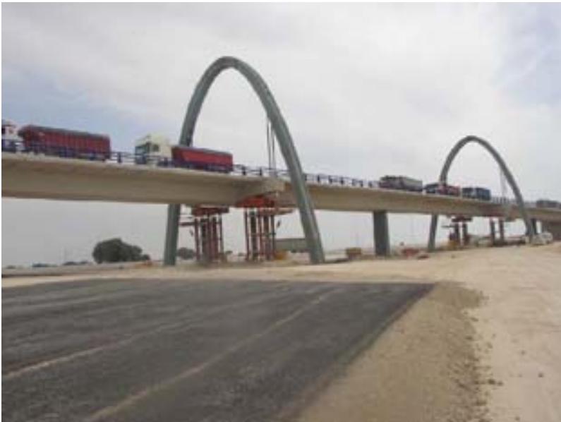
Fig 31. Estado de la prueba de carga
