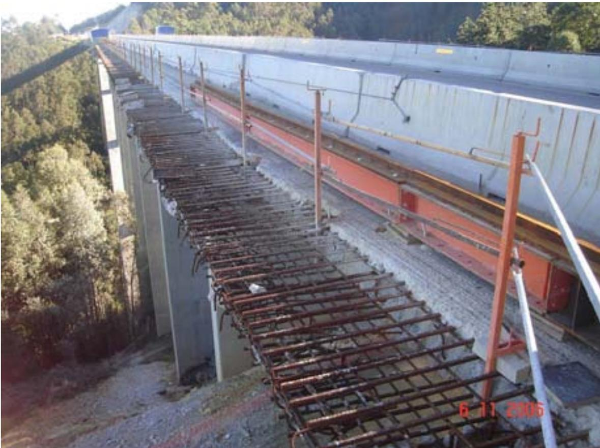
Fig. 8 Aspecto de la ferralla tras la hidrodemolición
