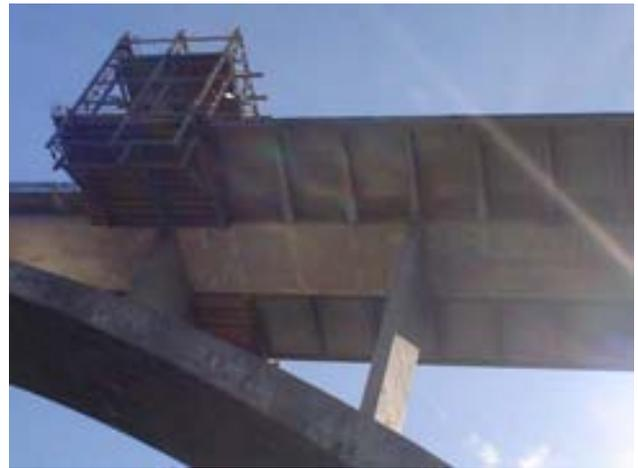
*Fig. 12 y 13 Vista inferior del tablero ampliado*
