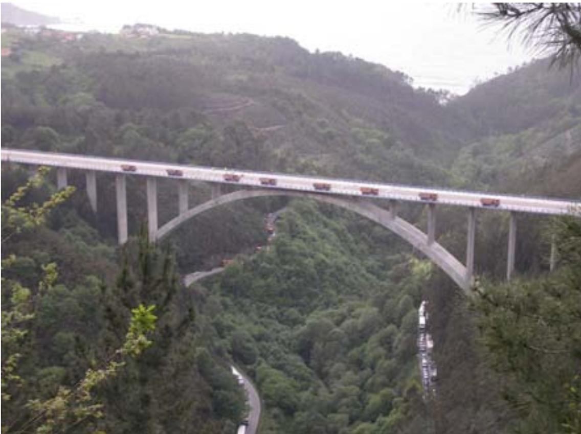
*Fig. 14 Prueba de carga del viaducto*
