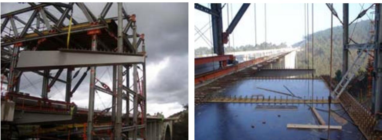
*Fig. 10 y 11 Colocación de voladizos metálicos y encofrado de la losa*
