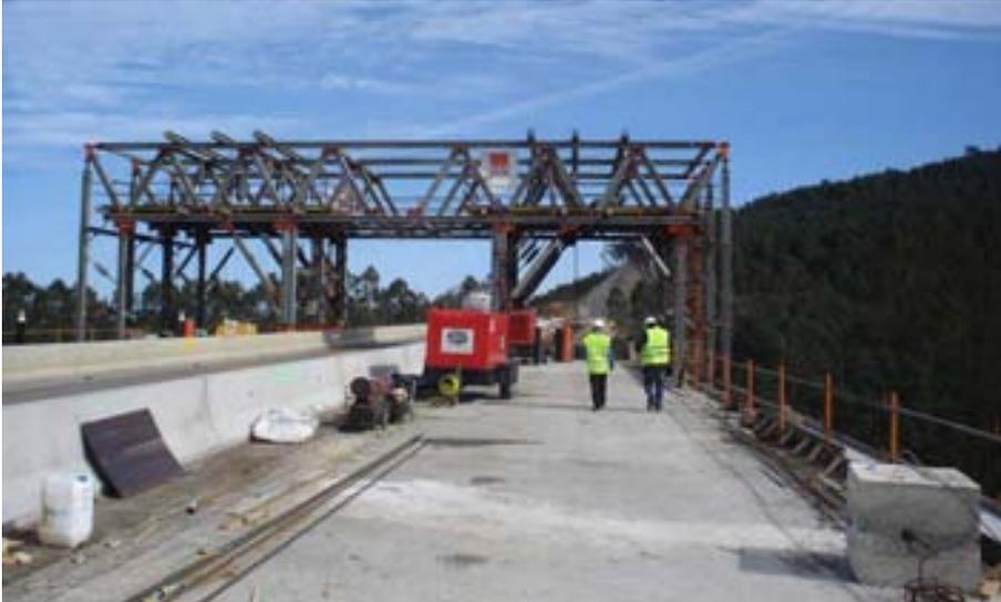
*Fig. 9 Carro para colocación de estructura metálica y hormigonado*
