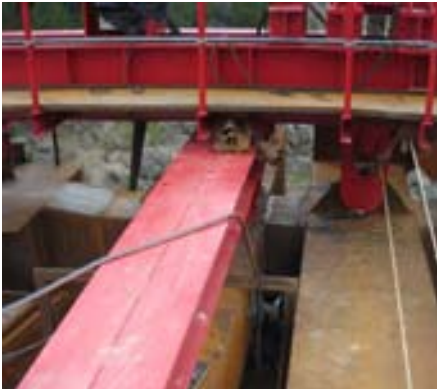
Fig 17. Unión de tableros después del izado.
