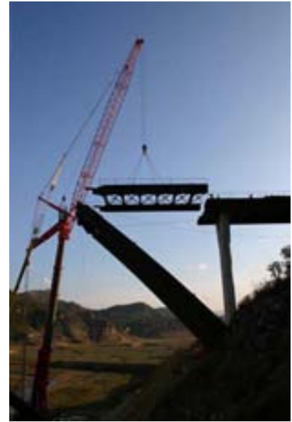
Fig 13. Voladizo (III). Tablero del voladizo.
