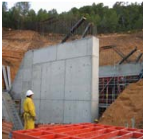
Fig. 6. Estribo 2. Vainas de retenida.
