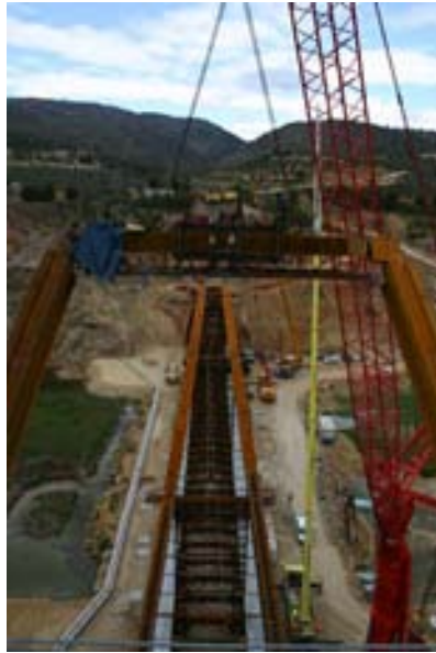
Fig 12. Voladizo (II). Riostra de voladizo.
