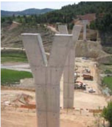
Fig. 5. Pilas y plataforma del bowstring.
