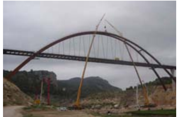
Fig 19. Hormigonado de una fase del arco.
