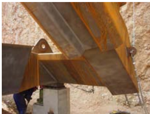
Fig 24. Bowstring: Muñon, riostra, gato desapeo, orejeta izado.
