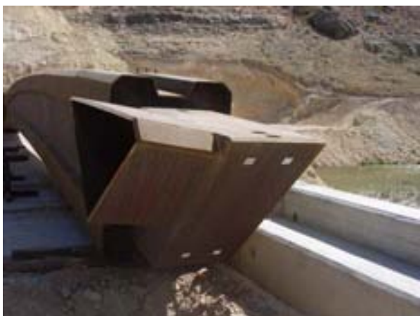
Fig 23. Muñon de voladizo con dianas de replanteo.
