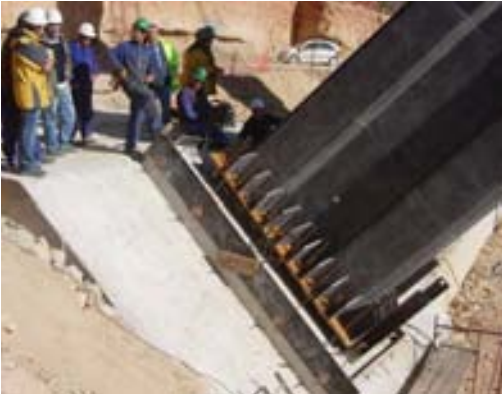
Fig 25. Enhebrado a las barras con contratuercas.
