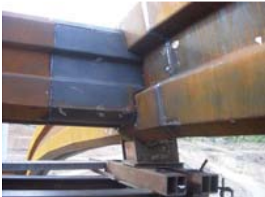
Fig 21. Unión de riostras arcos, anclaje péndolas y apoyo cimbra.
