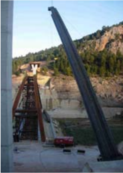
Fig 11. Voladizo (I). Arranques de arco.
