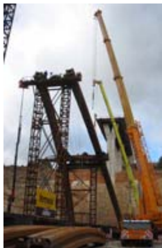
Fig 9. Bowstring (II). Montaje de arco.
