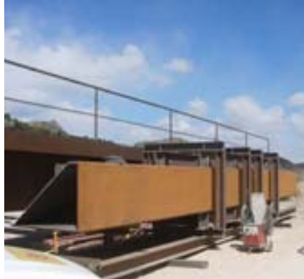
Fig 26. Riostra de voladizo.
