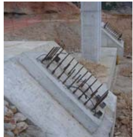
Fig. 7. Zócalo de cimentación de arcos.
