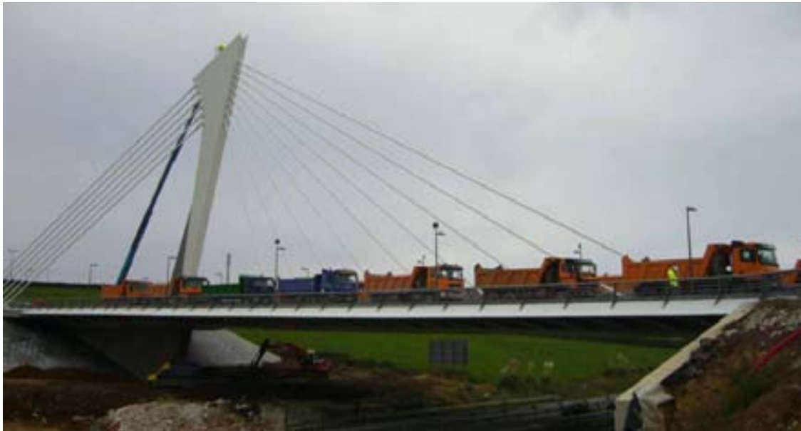
Fig. 11 Imagen de la prueba de carga estática de la estructura terminada
