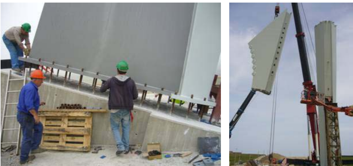
Fig. 9 Izado y montaje del mástil metálico con apeo único
