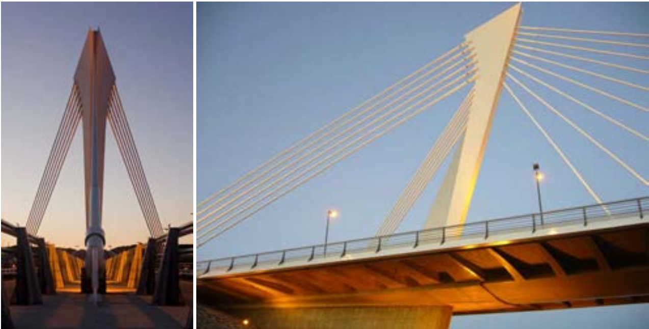
Fig. 4 Mástil metálico inclinado
