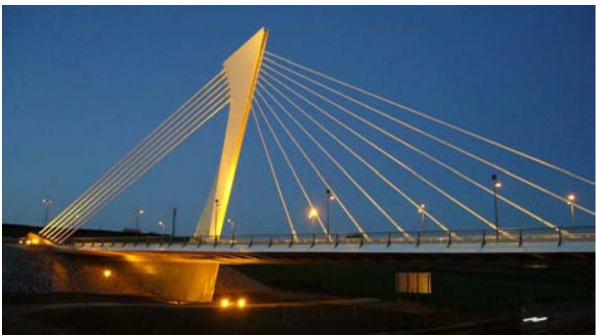
Fig. 14 Vista nocturna del puente acabado
