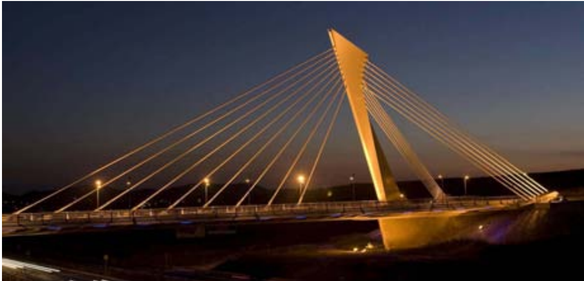
Fig. 2 Vista nocturna del puente construido
