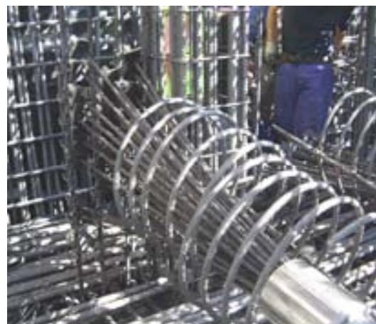
Figura 3. Anclaje pasivo de un cable de pretensado de la losa de cimentación
