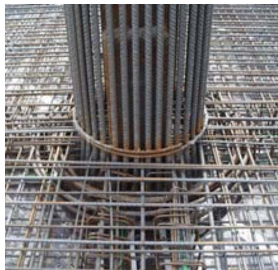
**Figura 9.a (izda.) Armadura circular en arranque de pilares circulares realizados con HAR en la losa de cimentación HA-30; 9.b (dcha.) Cercos de confinamiento del hormigón del forjado HA-30 en la zona atravesada por el pilar realizado con HAR**
