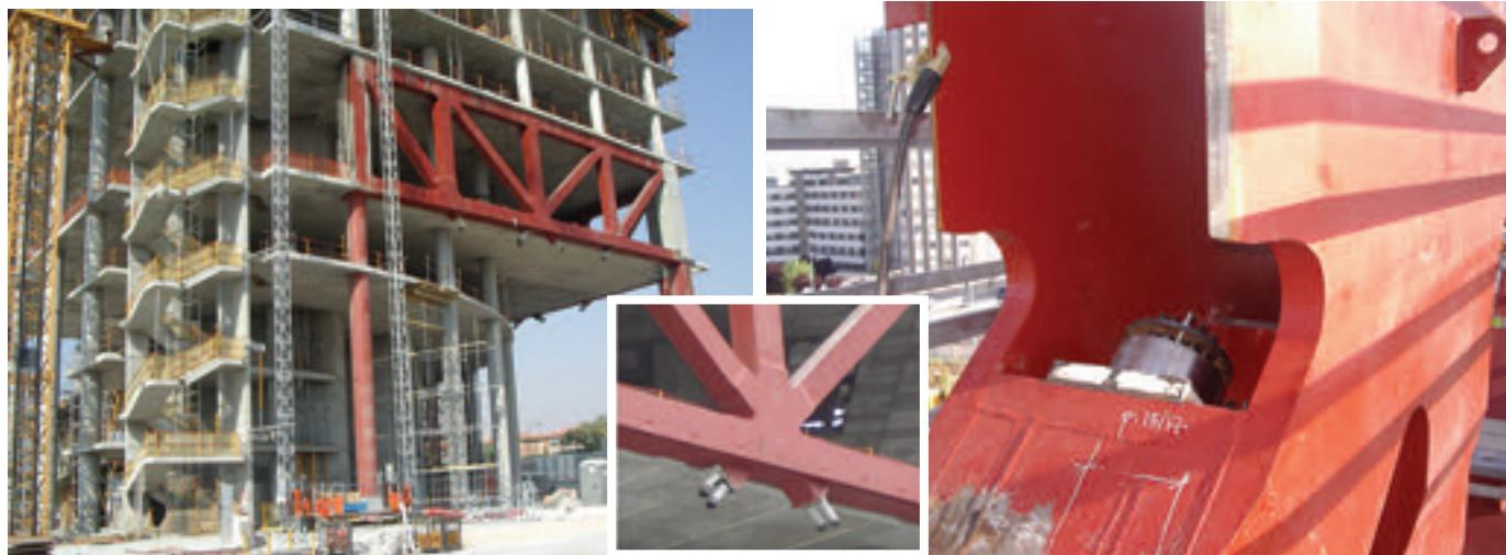
Figura 19. Vigas cargaderos en la zona de accesos al edificio (en el sentido de las agujas del reloj): vista general antes de la instalación de la fachada; detalle con los anclajes inferiores; detalle con los anclajes superiores durante el montaje.
