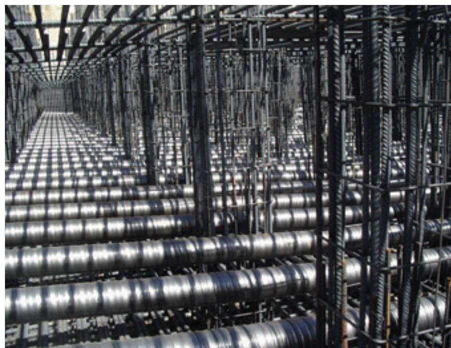
Figura 2. Tendones de postensado en losa de cimentación de Torre Espacio.
