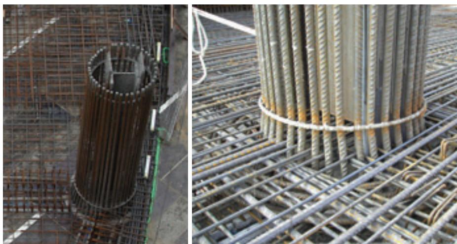
Figura 18. Soportes principales en la zona de acceso a la torre (en el sentido de las agujas del reloj): vista general; perfil metálico interior reforzado con alveolo para el paso de armaduras en la intersección con el forjado; sección mixta con armadura 40 φ 32 y perfil metálico HEM 500 reforzado con chapas; detalle de intersección con el forjado.
