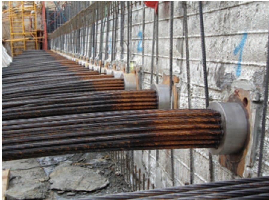
Figura 3. Anclajes activos después del tesado en losa de cimentación de Torre Espacio.
