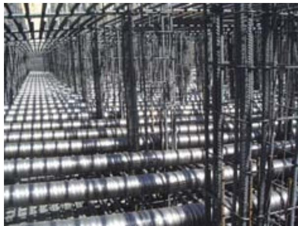
**Figura 2. Coexistencia de armadura activa y armadura pasiva en la primera tongada de la losa de cimentación**
