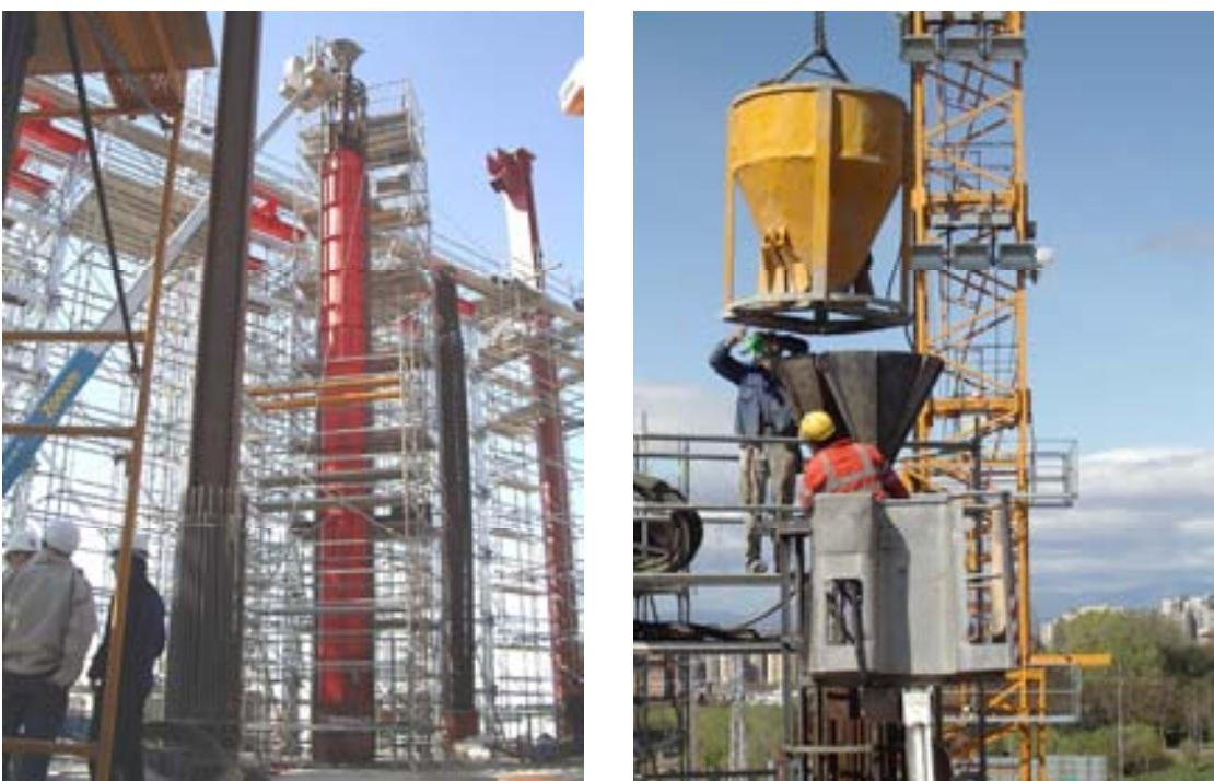
**Figura 8 Hormigonado de 16m de altura de un soporte con sección  $\phi=1\text{m} + 40 \phi 32 + \text{HEM500}$ , mediante tubos buzo.**
