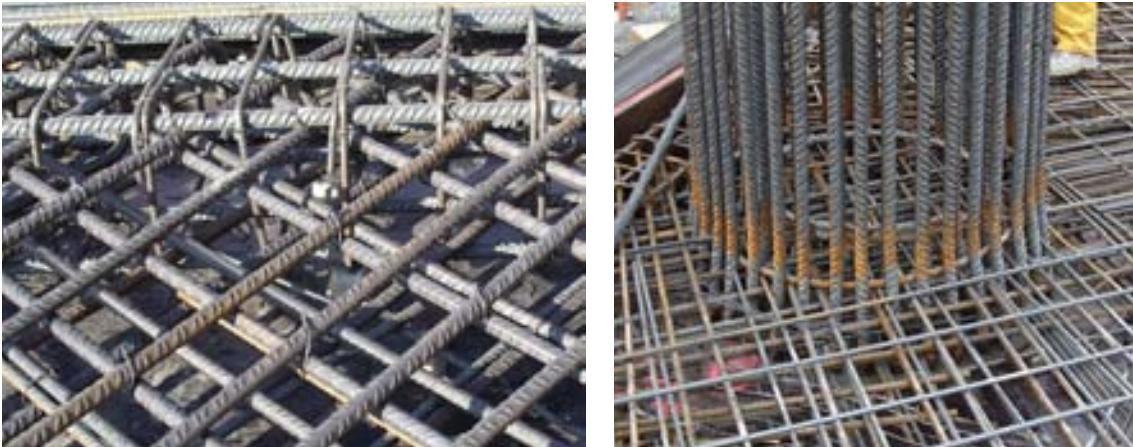
**Figura 10.a (izda) Anclaje de las dos direcciones de armado del forjado en el zuncho de borde a 45º; 10.b (dcha) Cruce de las dos direcciones de armado del forjado a través del pilar.**
