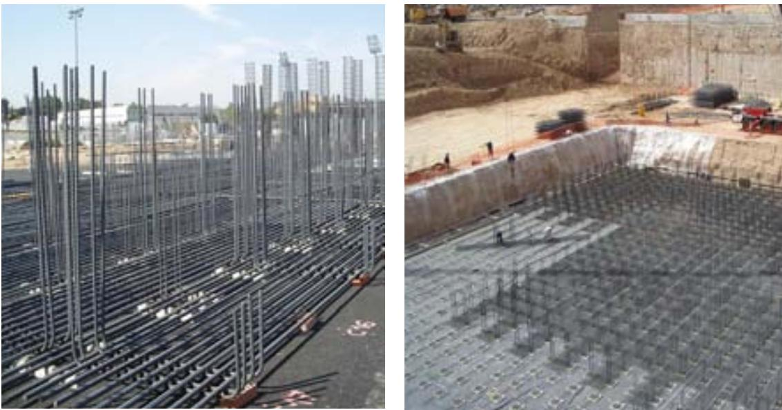
**Figura 1.a (izda) Prefabricación de la armadura en el parque de armado previo al montaje; 1.b (dcha) Montaje real de la armadura prefabricada de la primera tongada de la losa de cimentación**
