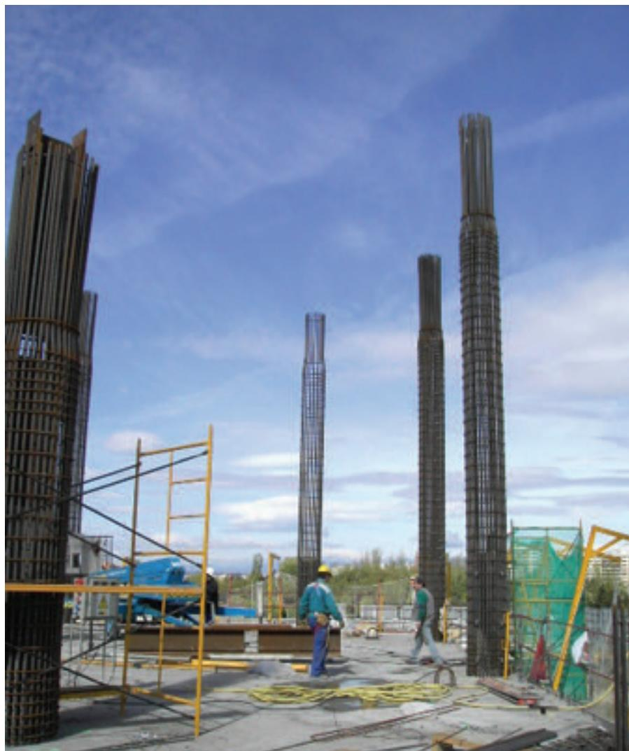
Figura 4. Montaje de armadura de pilares en entreplanta 2, Torre Espacio.
