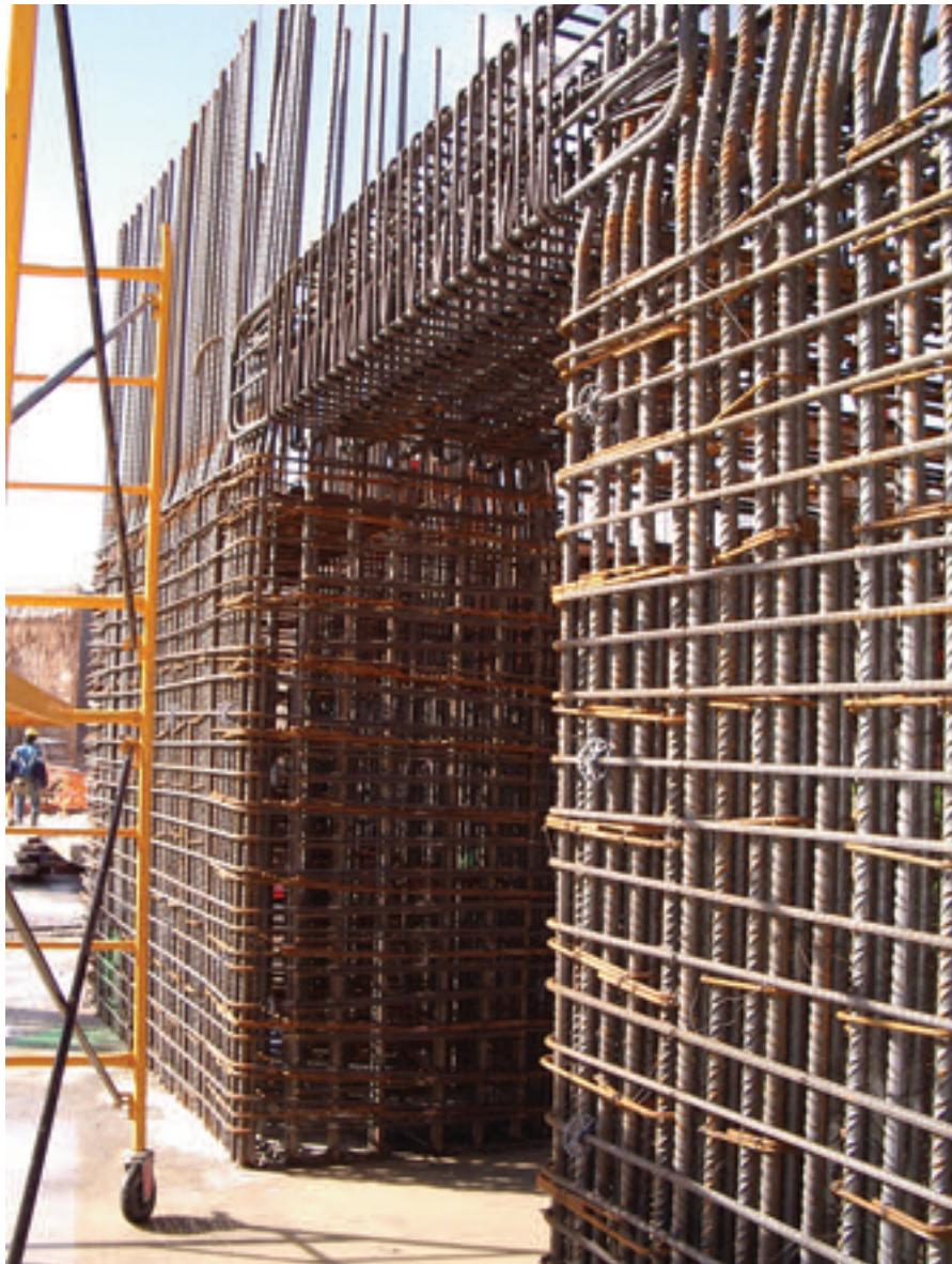
Figura 5. Armadura del núcleo central en sótano 6 de Torre Espacio.
