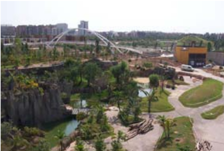
Fig. 2 Vista general del nuevo Bioparc de Valencia. Al fondo la pasarela
