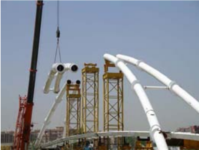
Fig. 7: Colocación de la pieza de clave
