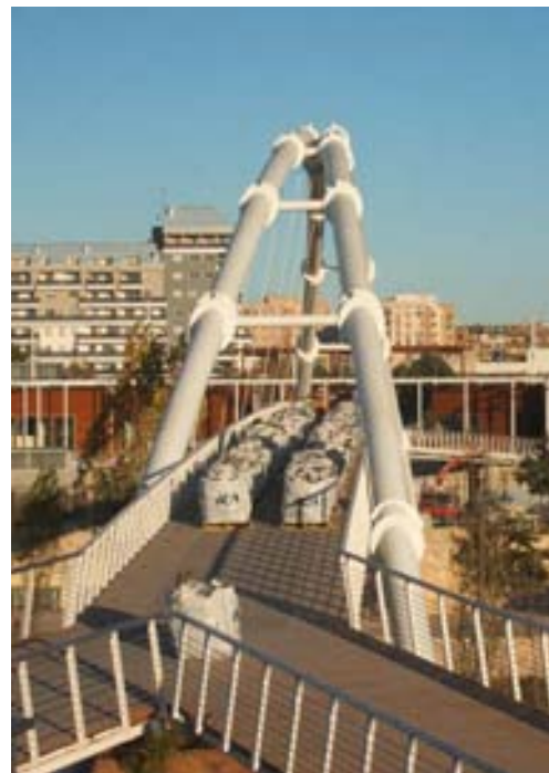
Fig. 9: Prueba de Carga
