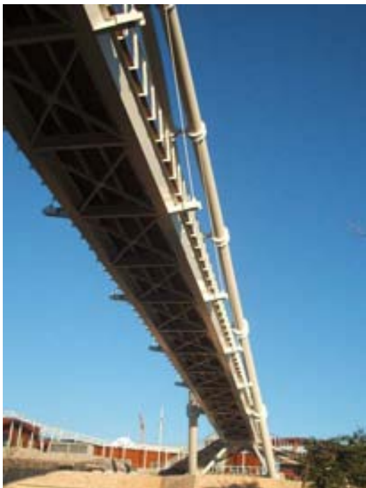
Fig. 8: Vista inferior de la pasarela acabada
