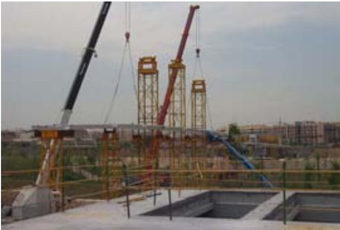
Fig. 5: Maniobra de incurvación del tablero metálico mediante la elevación sucesiva por grúas móviles.
