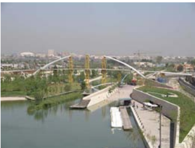
Fig. 6: Montaje de los tramos de arco
