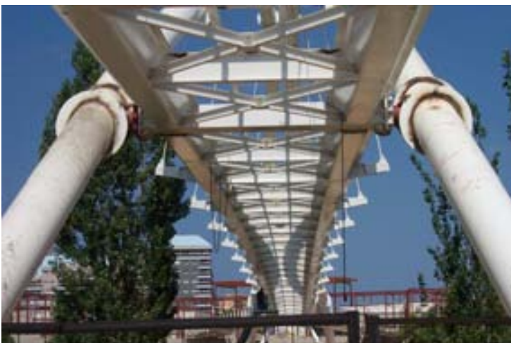
Fig. 4: Esquema estructural inferior y vinculación entre arco y tablero mediante rótulas cilíndricas.
