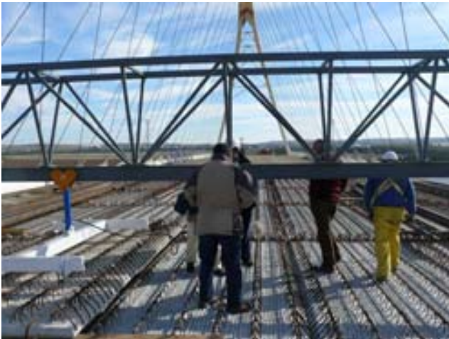
Figs. 11a y 11b: Vista durante las operaciones de colocación de prelasas en el tablero y con el tablero ferrallado.
