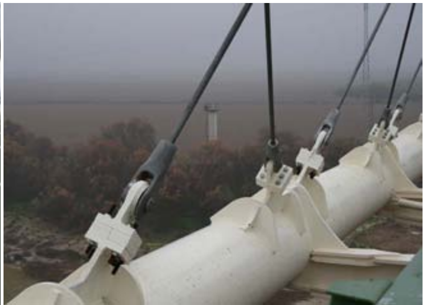
Figs. 5a y 5b: Detalles de anclajes de péndolas inferiores y arranques de vigas trasnversales dispuestas cada 5 m en el tablero
