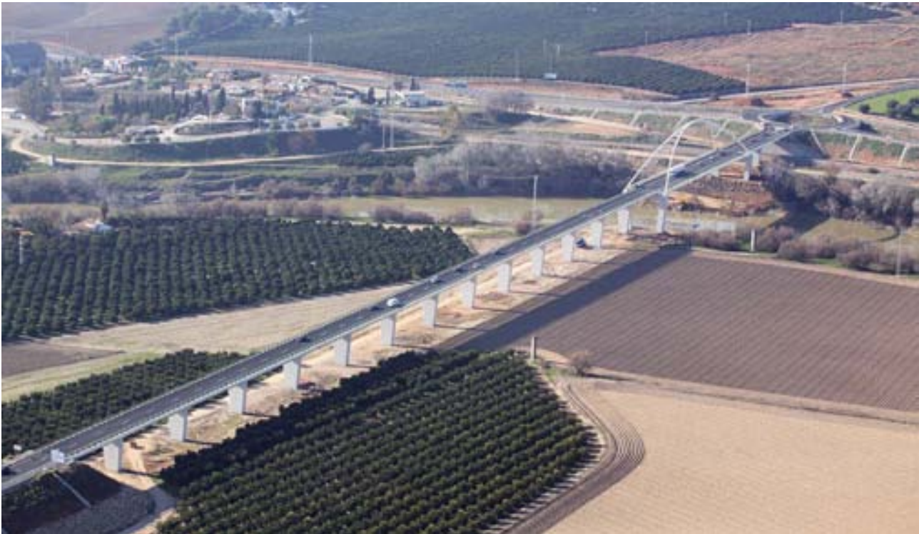
Fig. 1: Vista aérea en primer plano del Viaducto de acceso Sur, del Puente arco, del Viaducto de acceso Norte y de la glorieta.
