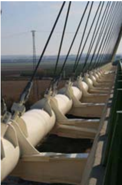
Figs. 5a y 5b: Detalles de anclajes de péndolas inferiores y arranques de vigas trasnversales dispuestas cada 5 m en el tablero
