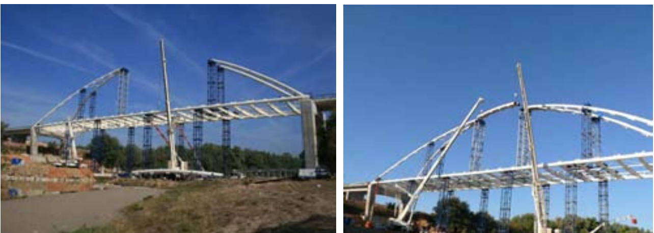
Figs. 10a y 10b: Vista durante las operaciones de izado de los arcos, y fase de cierre en clave de los arcos
