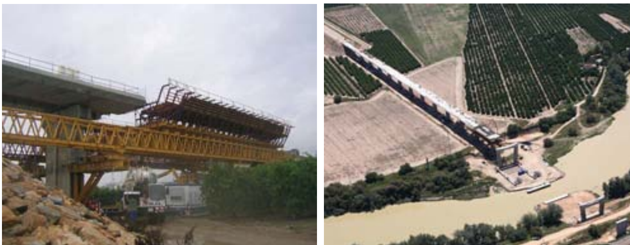
Fig. 2a y 2b: Vistas durante la ejecución del viaducto de acceso sur con autocimbra
