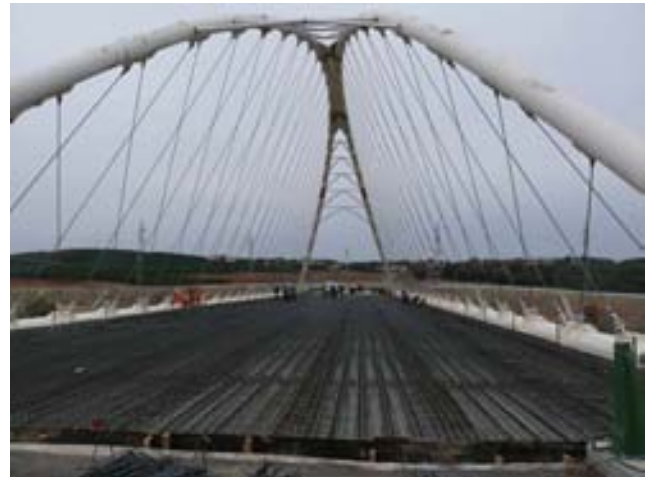
Figs. 11a y 11b: Vista durante las operaciones de colocación de prelasas en el tablero y con el tablero ferrallado.
