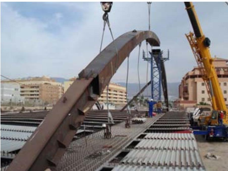
*Fig. 8. Montaje de semiarcos sobre castilletes.*
