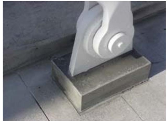
*Fig. 5. Conexión de las péndolas al tablero. Durante la construcción (izquierda) y terminado (derecha).*
