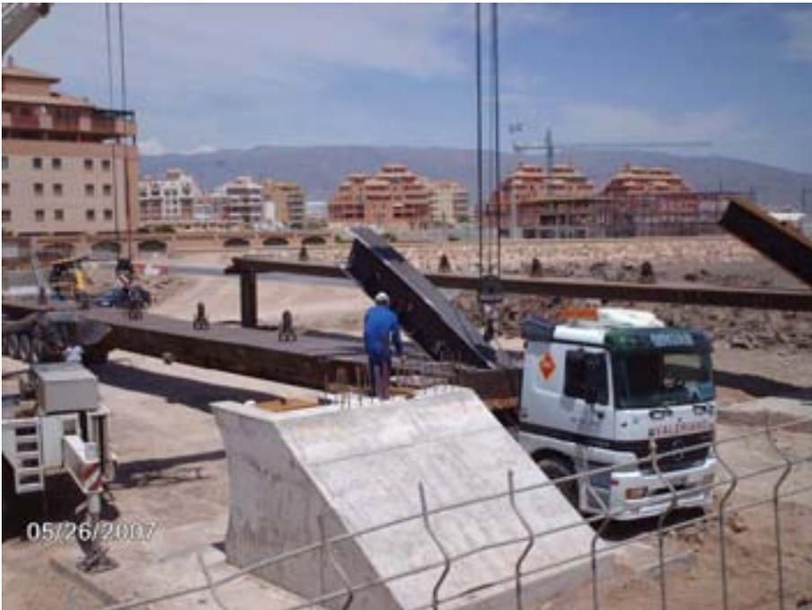
*Fig. 7. Montaje de vigas longitudinales. En primer término, una pila terminada.*
