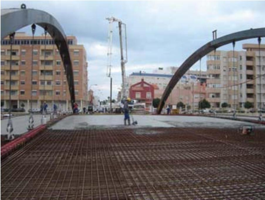
*Fig. 9. Hormigonado del tablero.*
