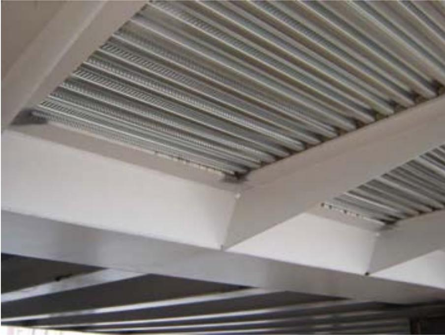
*Fig. 4. Vista inferior de vigas longitudinales, costillas y encofrado perdido de chapa grecada.*
