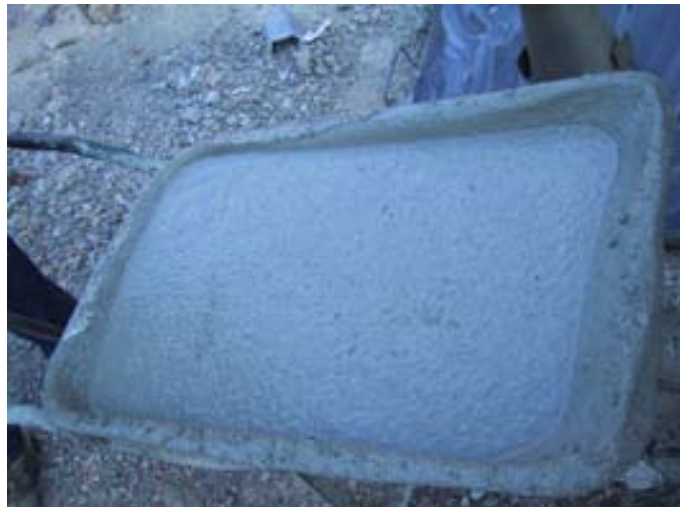
Figura 15. Prueba de hormigonado ( RioMayor)
