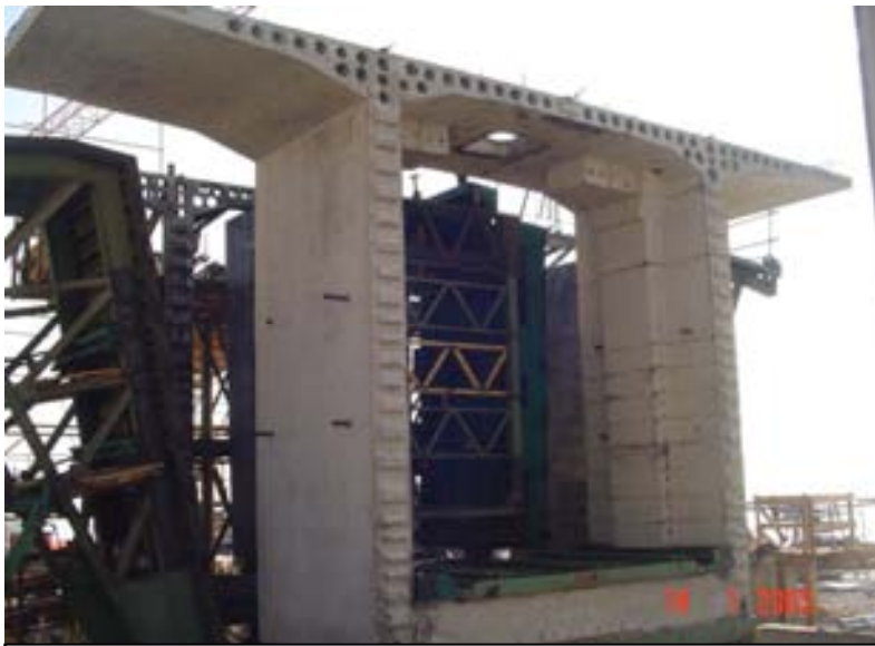
Figura 4 Dovelas prefabricadas de Vto. Huarea
