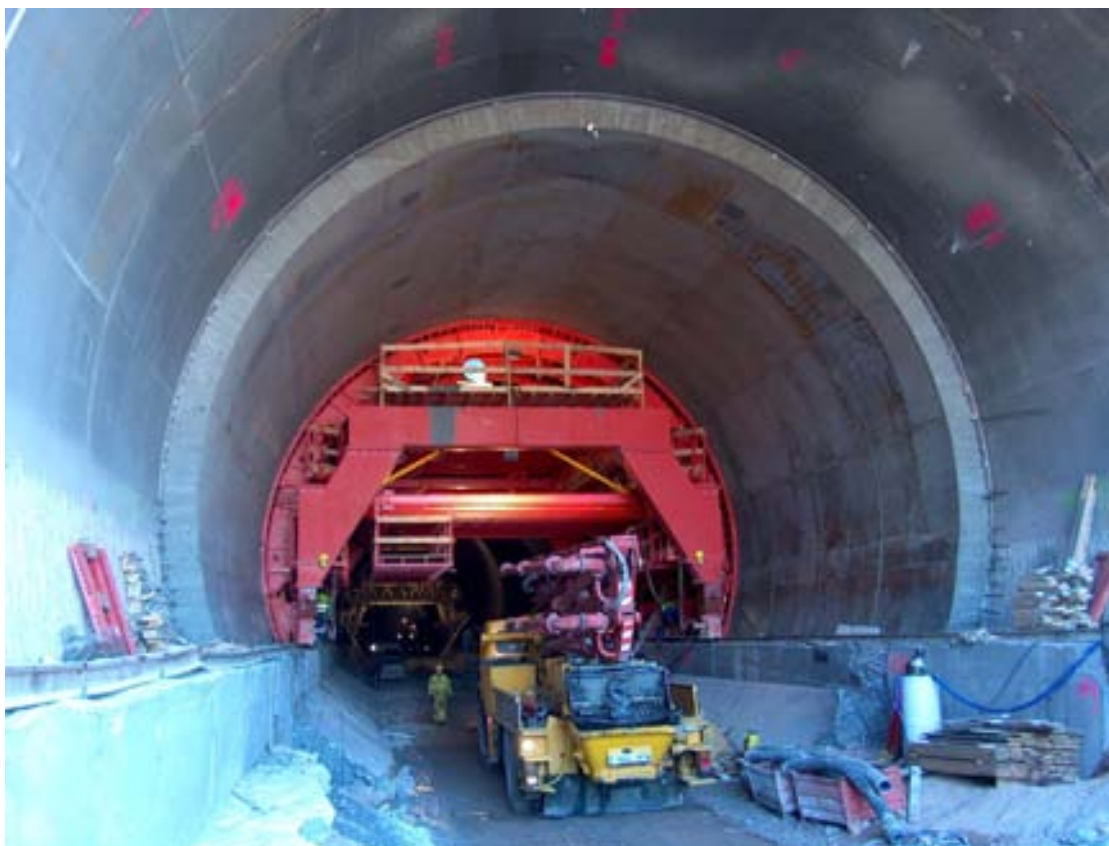
Figura 6 Túnel de Lilla HA-80 autocompactable
