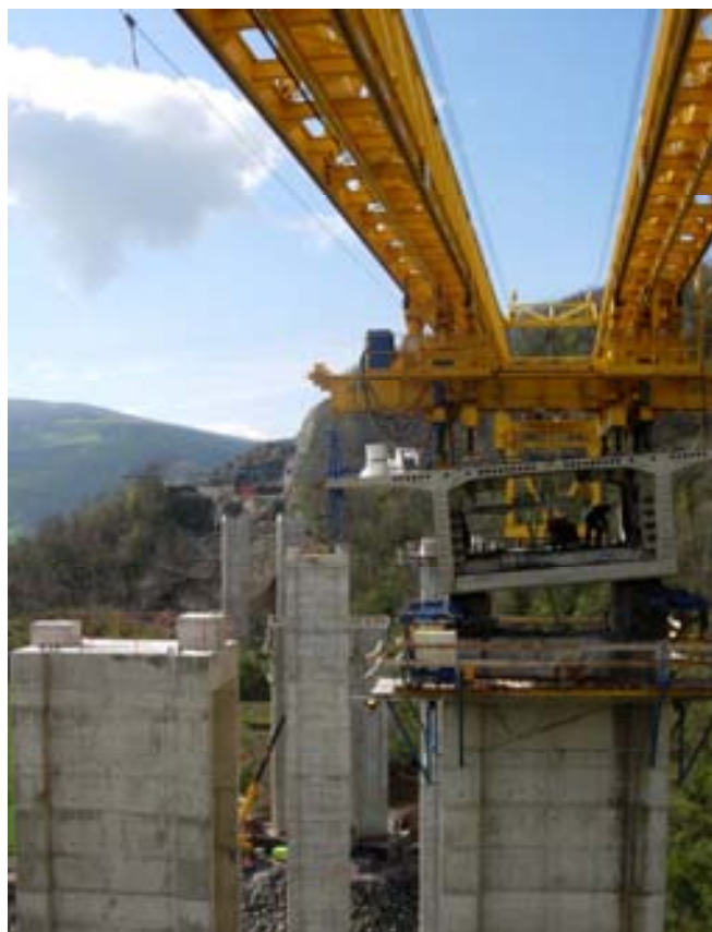
Figura 12. Colocación dovela cero
