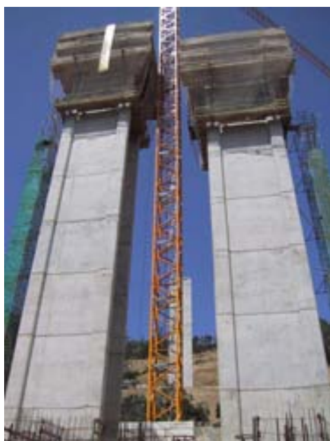
Figura 13. Pilas del viaducto de RioMayor
