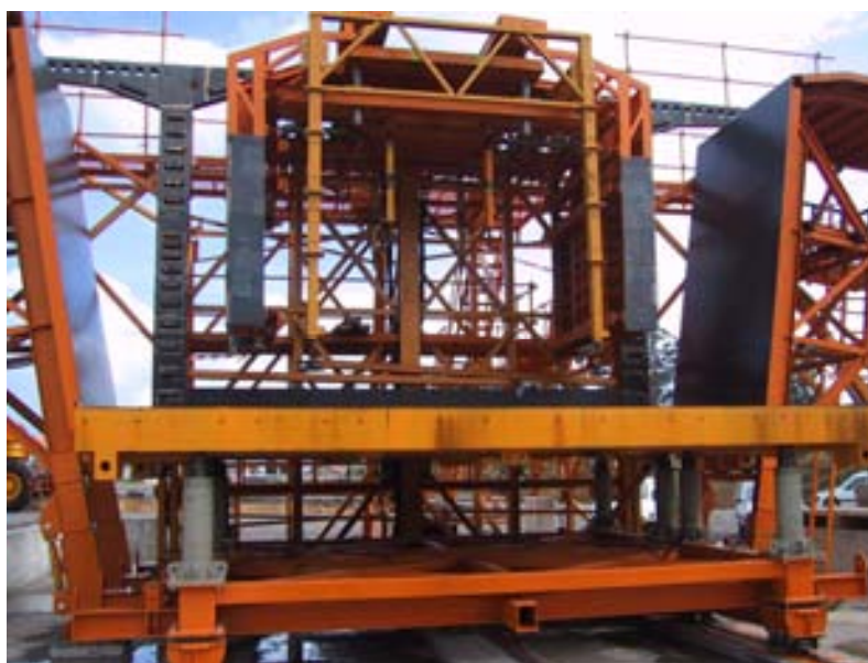
Figura 14. Moldes de fabricación de dovelas ( RioMayor)
