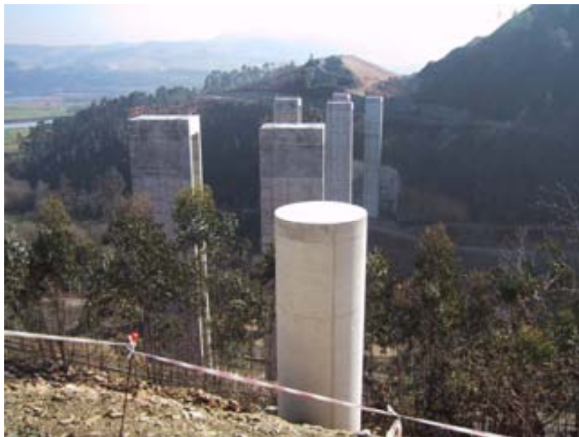
Figura 16. Pila auxiliar para dovelas descompensadas ( RioMayor)
