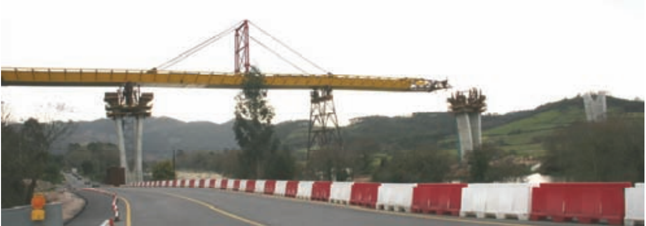
Fig. 8 Lanzamiento del tablero sobre el vano principal de 124 m con una torre intermedia auxiliar.
