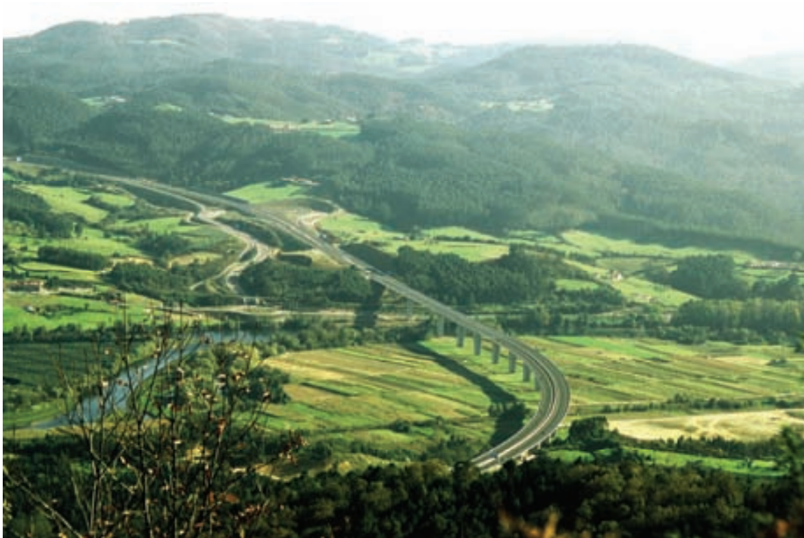
Fig. 13 Vista superior del viaducto y de su entorno.
