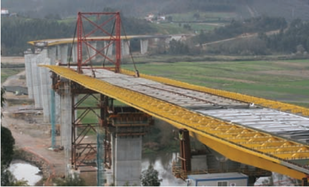
Fig. 8 Vista general del lanzamiento desde ambos estribos.
