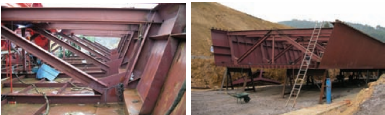
Fig. 4 Vista interior del tablero. Diafragmas.
