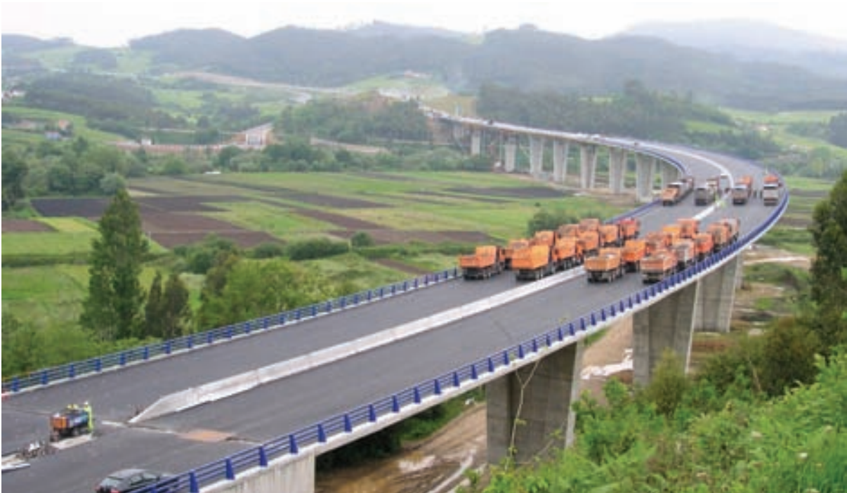
Fig. 10 Vista del viaducto en el momento de la prueba de carga.
