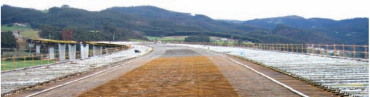
Fig. 9 Construcción de la losa superior del tablero.
