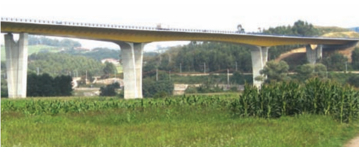
Fig. 12 Imagen del vano principal sobre el cauce del río Nalón terminado.
