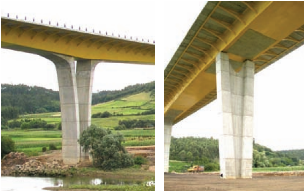
Fig. 7 Pila principal (izq). Pila tipo (dcha).
