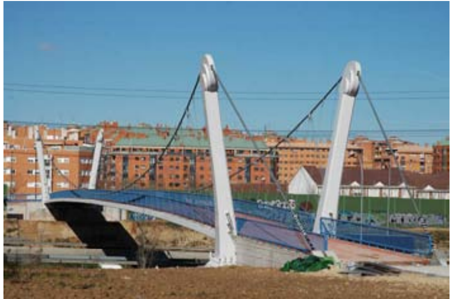
Fig. 2 Pasarela sobre la M-40
