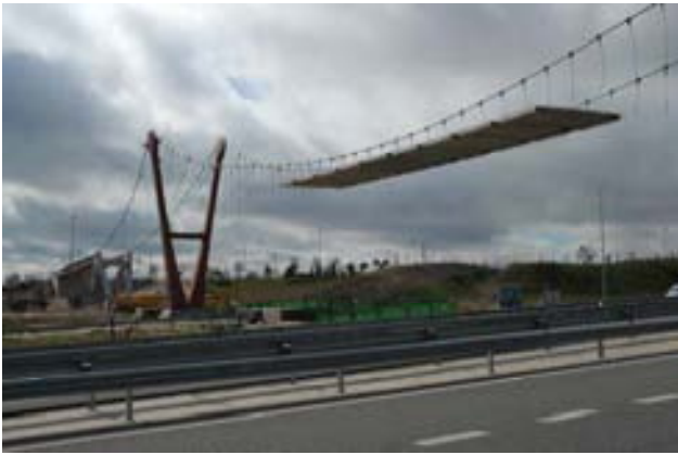
Fig. 14 Pasarela sobre la R-3 en construcción
