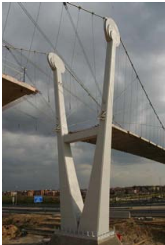
Fig. 11 Torre de la Pasarela sobre la R-3
