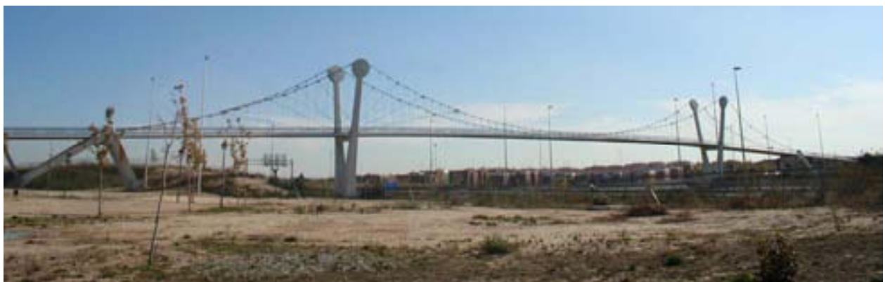
Fig. 16 Pasarela sobre la R-3
