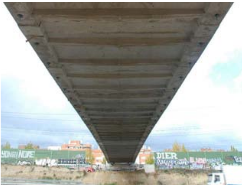
Fig. 9 Vista inferior del tablero
