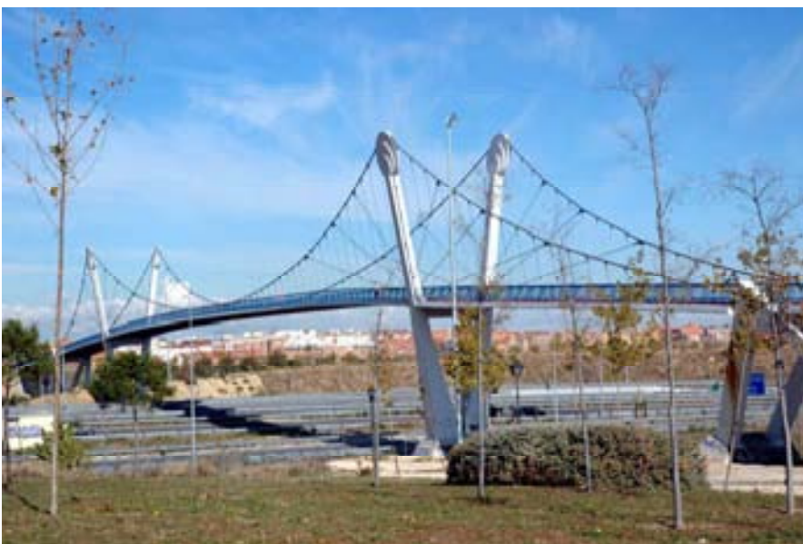
Fig. 3 Pasarela sobre la R-3
