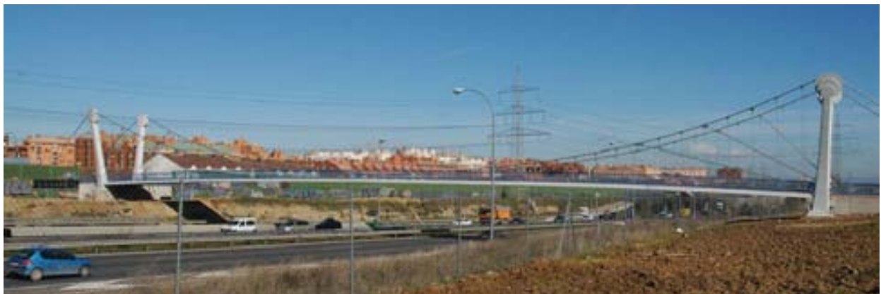
Fig. 15 Pasarela sobre la M-40
