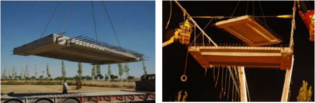
Fig. 8 Dovelas prefabricadas del tablero
