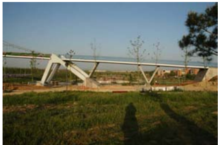
Fig. 13 Pasarela sobre la R-3. Bípode de anclaje y acceso a la pasarela colgada
