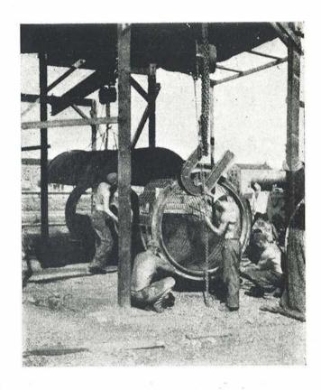
FOTO N.º 3.—Terminado el montaje del molde, se traslada desde el cobertizo en el que se ha ejecutado, a otro donde se realiza el vertido del hormigón. Para ello se cuelga, por medio de unos tornillosprensa que lo sujetan por los extremos, de unas trócolas que se deslizan por unos carriles constituídos por perfiles en U, que van colocados sobre durmientes de madera.
