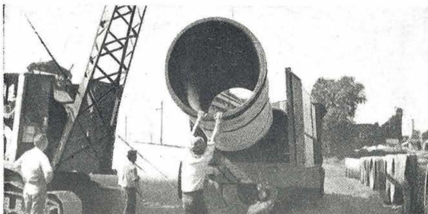
FOTO N.º 18.—Acabada la fabricación, se recubre la tubería interiormente con una ligera mano de asfalto, quedando lista para su transporte a obra. En la fotografía se recoge el momento en que una de estas piezas es cargada en los coches-remolques que se utilizaron para trasladarlas desde Chicago a la ciudad de Granite, si-
