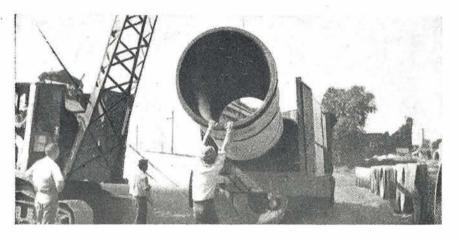
FOTO N.º 18.—Acabada la fabricación, se recubre la tubería interiormente con una ligera mano de asfalto, quedando lista para su transporte a obra. En la fotografía se recoge el momento en que una de estas piezas es cargada en los coches-remolques que se utilizaron para trasladarlas desde Chicago a la ciudad de Granite, si-
