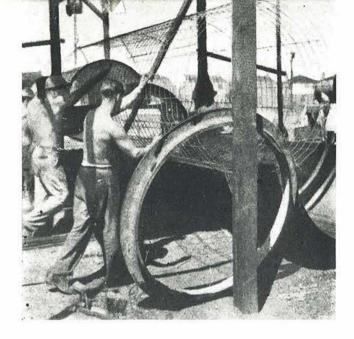
FOTO N.º 1.—Colocación en el molde de una jaula de alambre pre-atirantado, destinado a reforzar las paredes de hormigón de una tubería de 4'90 m. de largo y 1'40 m. de diámetro, calculada para una presión de 7'6 Kgs./cm.² La malla de la jaula es de 10×20 cm. y está constituída por alambre del núm. 7 y núm. 4.
