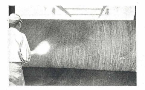
FOTO N.º 16. — Terminada la formación de la armadura, se somete la tubería a un giro lento, a razón de 2 r. p. m. y con gunita se forma una capa de mortero de cemento de unos 2 cm. de espesor, que recubre totalmente las espiras de alambre, protegiéndolas y dando a las mismas una mayor trabazón.
