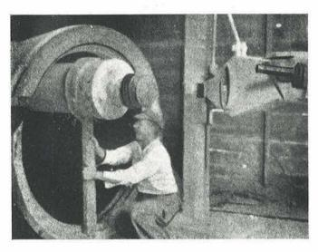
FOTO N.º 5.—Introducido el árbol en el inteterior del molde, se sujetan los extremos
