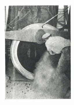
FOTO N.º 9.—Al terminar el hormigonado, que dura una media hora, se echa una mezcla seca de arena y cemento, para dar a la superfície interior de la tubería un acabado perfecto. Posteriormente, se saca el rodillo del interior del molde y se somete el hormigón a una cura de vapor durante la noche.
