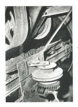
FOTO N.º 7.—El transportador entra en voladizo en el hueco central del molde, y movido por un torno de mano, coloca el hormigón exactamente en el sitio que se quiera. Obsérvese la consistencia del hormigón sobre la correa transportadora y la correa múltiple en V que hace girar el árbol, accionada por un motor eléctrico de 30 H. P.
