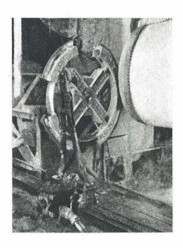
FOTO N.º 13.—Al ir dando vueltas la tubería, se va enrollando con la tensión conveniente, hasta alcanzar los 9.850 Kgs./cm², el alambre de la armadura, que pasa por una polea colocada en la parte alta de un caballete, que se desliza sobre el carril de la fig. 11, de un extremo al otro de la tubería, al mismo tiempo que esta gira.
