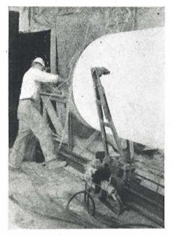
FOTO N.º 11.-Una vez endurecido el hormigón, se acopla a la tuberia un torno devanadera que se desliza por un carril, colocado paralelamente al sentido longitudinal de la tubería, y provee a ésta en la segunda etapa del proceso de fabricación, del alambre que constituye su armadura de pretensado.
