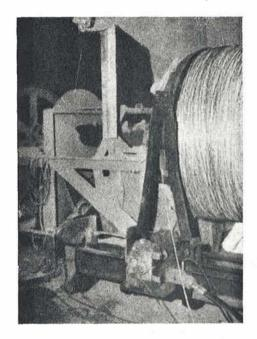
FOTO N.º 14.—De esta manera se forma con el alambre un entramado parecido al de las telas metálicas. La velocidad de desplazamiento del caballete es graduable, con el fin de que el paso de las espiras sea en todo momento el preciso para que las dos componentes, longitudinal y radial, en que queda dividido el esfuerzo total de pretensado producido, tengan la magnitud requerida.
