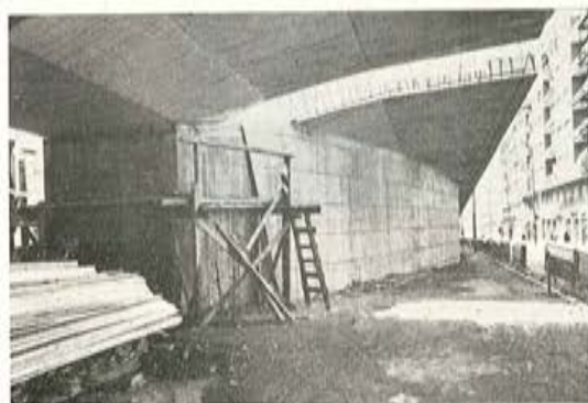
Fig. 9. — Franja de hormigonado posterior para igualar las deformaciones del voladizo transversal en el tablero y estribo.
