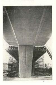
de 21 m. La sección transversal tiene 9,8 m de ancho y está formada por una losa trapecial aligerada de 3 m en la base y 1,2 m de canto y dos vuelos laterales de canto variable de 0,5 a 0,3 m que completan la envergadura transversal (fig. 12).
