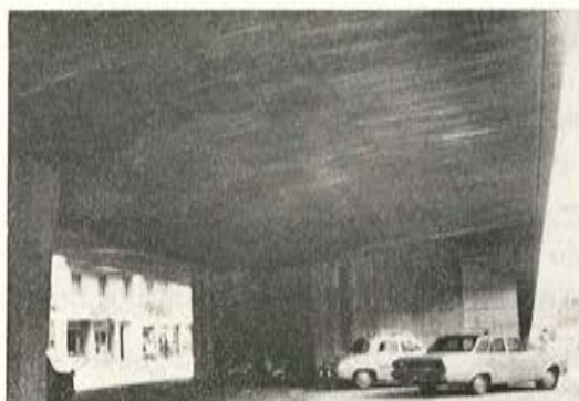
Fig. 4. — Encuentro del dintel con el estribo.
