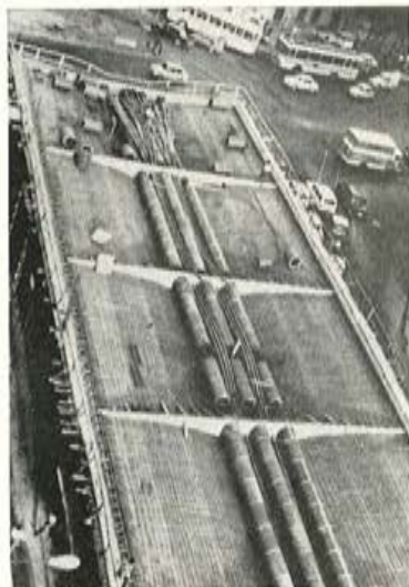
Fig. 6. — Aligeramientos y cableado longitudinal del dintel.
