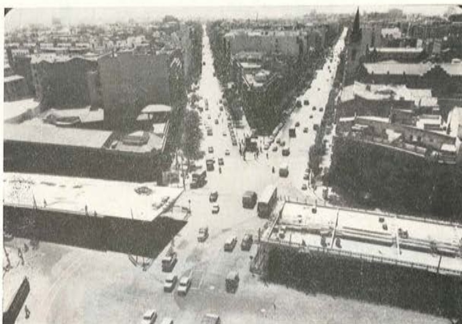
Fig. 8. — Proceso de construcción del puente.
