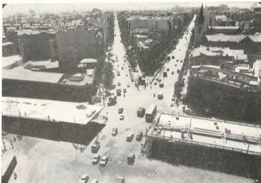
Fig. 8. — Proceso de construcción del puente.
