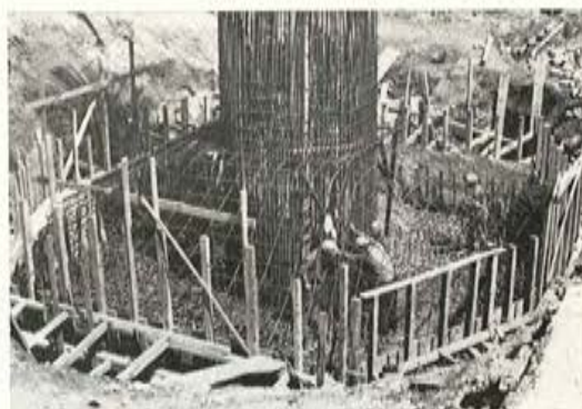
Fig. 25. — Armadura de pila y encepado en pilotes.
