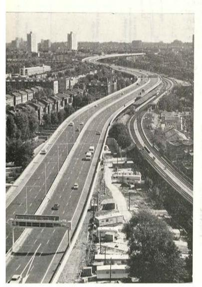
La sección más larga, constituida por 19 tramos continuos, generalmente de 62 m de luz, corre en gran parte paralela a las líneas principales de los Ferrocarriles Británicos de la Región Occidental. En una zona su trazado es curvo y cruza, en esviaje, las vías ferroviarias (figs. 23 y 24).
