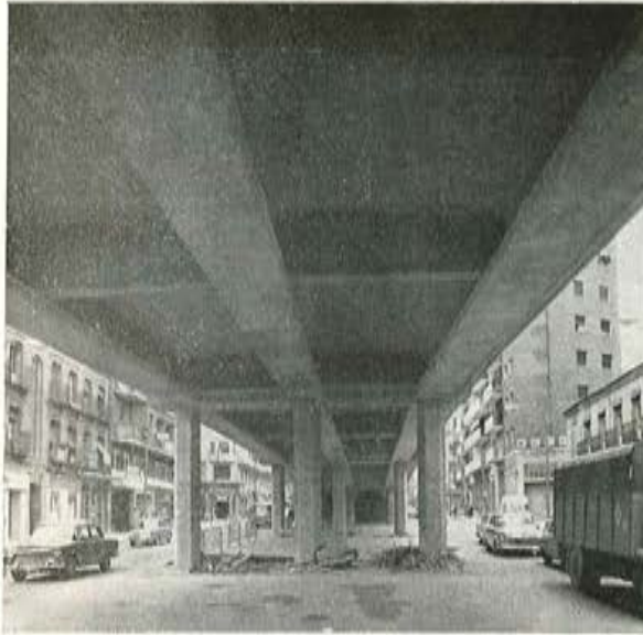
Fig. 1.—Vista inferior de los tramos de 20 m y de tres vigas del ramal principal.
