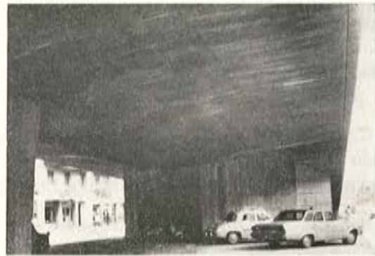
Fig. 4. — Encuentro del dintel con el estribo.
