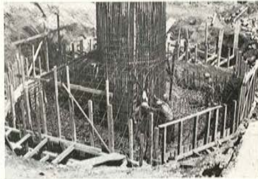
Fig. 25. — Armadura de pila y encepado en pilotes.
