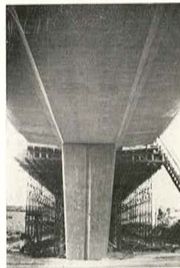
Fig. 15. — El primer tramo del puente se encuentra descimbrado y la cimbra ha pasado el tramo siguiente.
