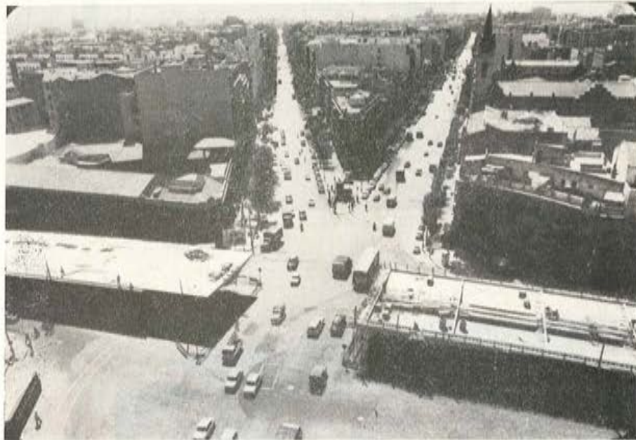
Fig. 8. — Proceso de construcción del puente.
