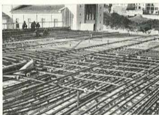
Fig. 22. — Pretensado del dintel.
