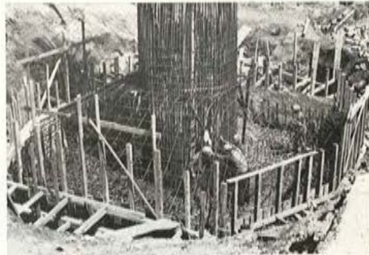
Fig. 25. — Armadura de pila y encepado en pilotes.
