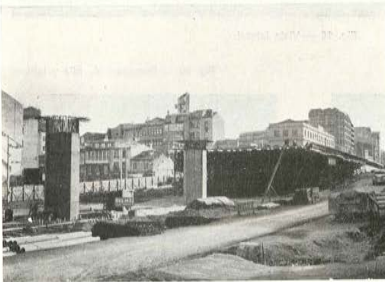
Fig. 24. — Situación intermedia del proceso constructivo.
