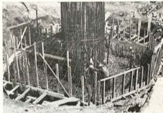
Fig. 25. — Armadura de pila y encepado en pilotes.
