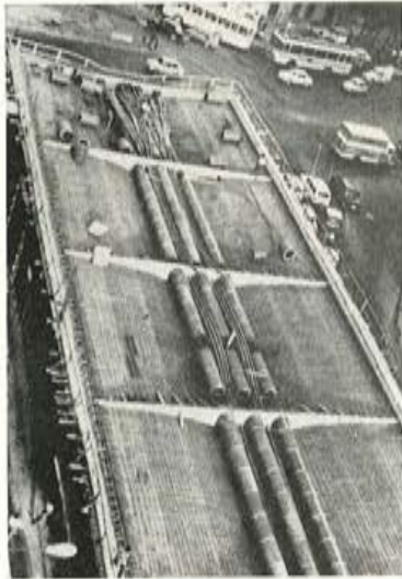
Fig. 6. — Aligeramientos y cableado longitudinal del dintel.
