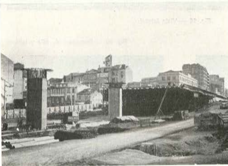
Fig. 24. — Situación intermedia del proceso constructivo.
