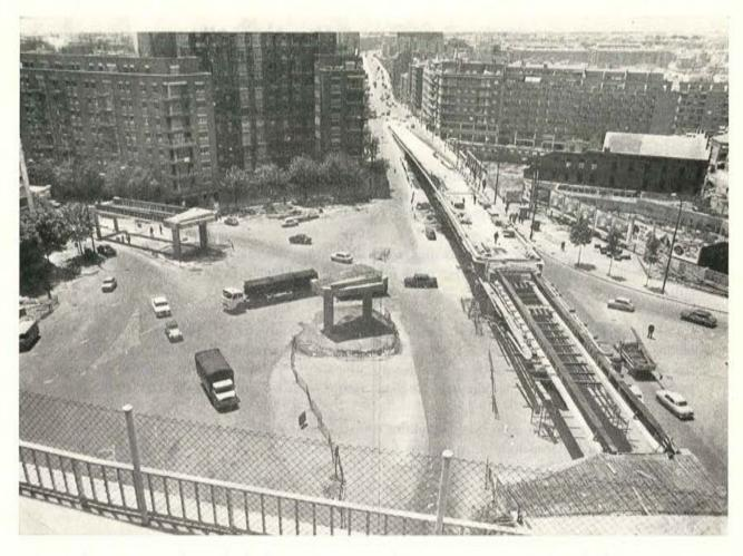
Dos vigas Preflex en un tramo de 35 m en el paso elevado de Capitán Cortés. Véase la colocación de las viguetas del encofrado del tablero, que va a ser soportado"por las vigas Preflex sin ningún apeo y conservando el paso de la circulación
