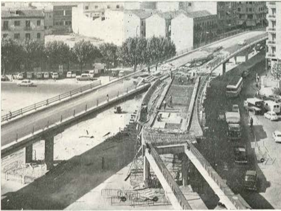
Fig. 4. — Entronque del ramal secundario con el principal.
