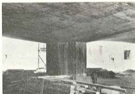
Fig. 20. — Encuentro de pila y tablero.
