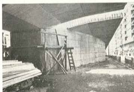
Fig. 9. — Franja de hormigonado posterior para igualar las deformaciones del voladizo transversal en el tablero y estribo.
