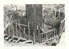
Fig. 25. — Armadura de pila y encepado en pilotes.
