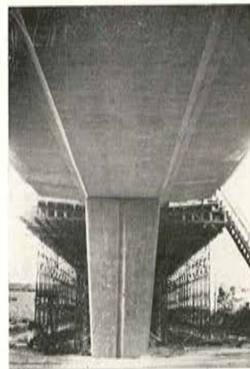
Fig. 15. — El primer tramo del puente se encuentra descimbrado y la cimbra ha pasado el tramo siguiente.
