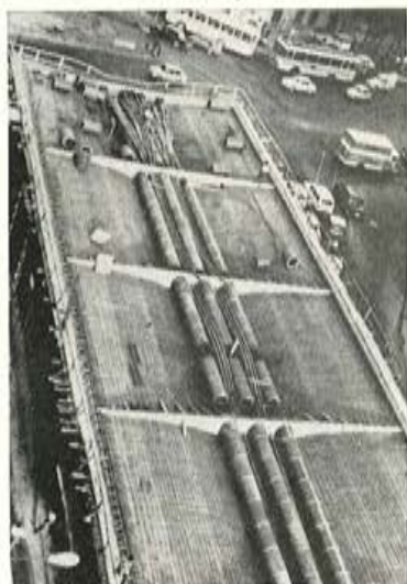
Fig. 6. — Aligeramientos y cableado longitudinal del dintel.
