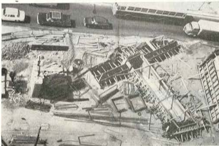
Fig. 11. — Encepado pretensado que sirve de apoyo del frente para salvar el paso del Metro.
