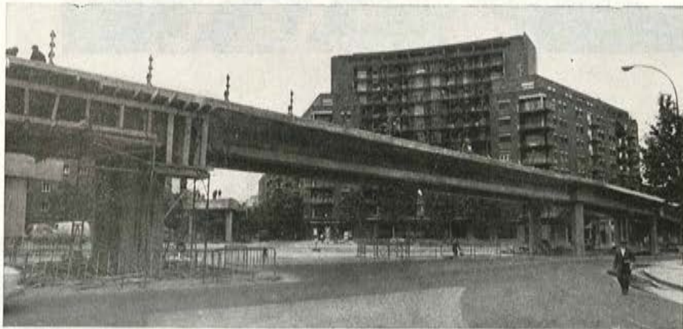
Fig. 2.—Vista de un tramo de 40 m del ramal principal.
