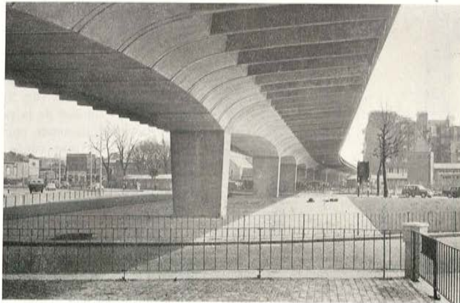
Fig. 2. — Paso elevado de Hammersmith, en Londres.
