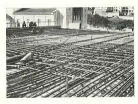
Fig. 22. --- Pretensado del dintel.
