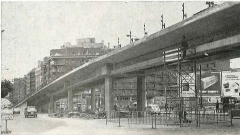
Fig. 3.—Vista de los tramos de 20 m y de dos vigas del ramal principal.
