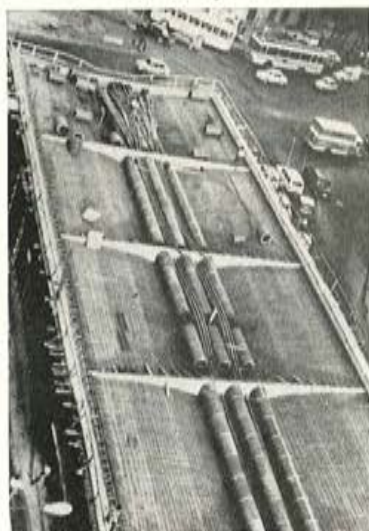
Fig. 6. — Aligeramientos y cableado longitudinal del dintel.
