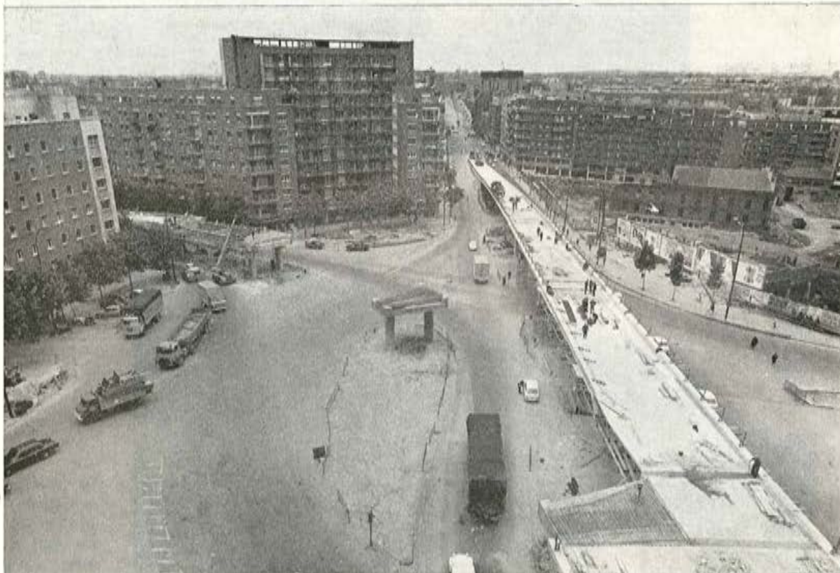
Fig. 5. — Vista del ramal principal y arranque del ramal secundario.
