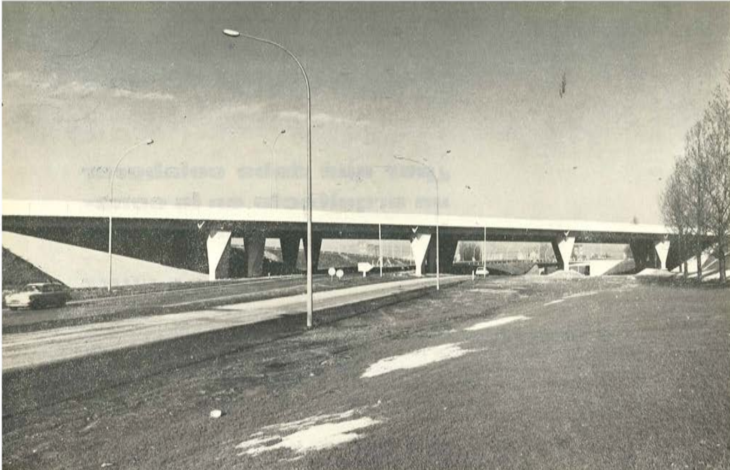
El cruce de la N-20 por el puente del ramal C-6 (Orleáns) de la autopista del Sur.
