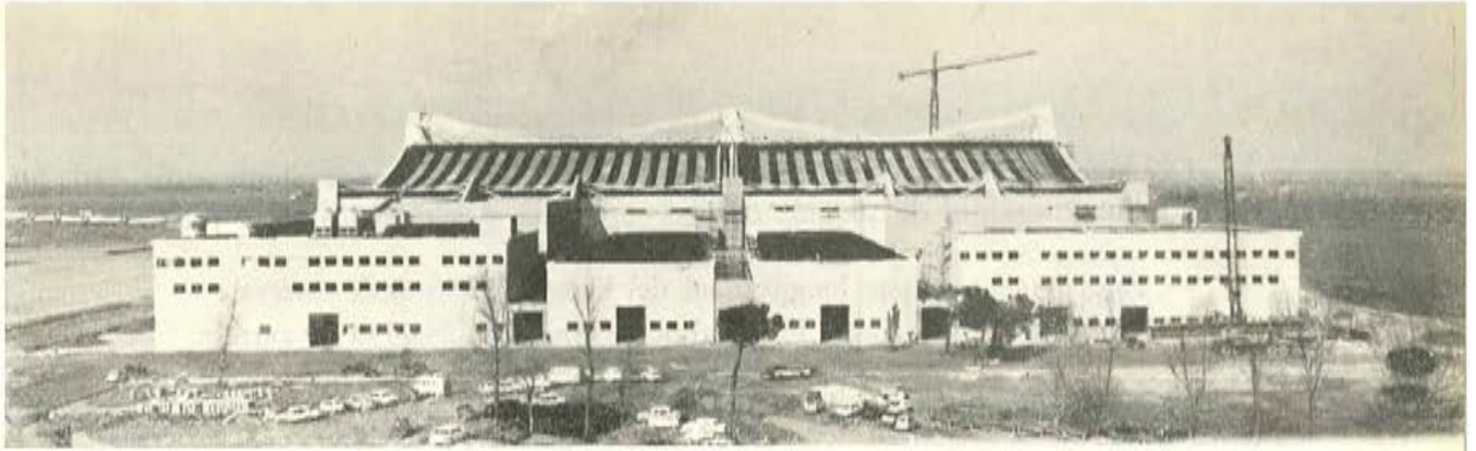
Fig. 12. — Vista posterior del edificio.
