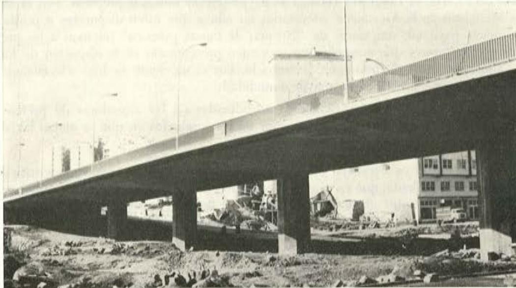
Viaducto de San Pedro de Mezonzo. La Coruña.
