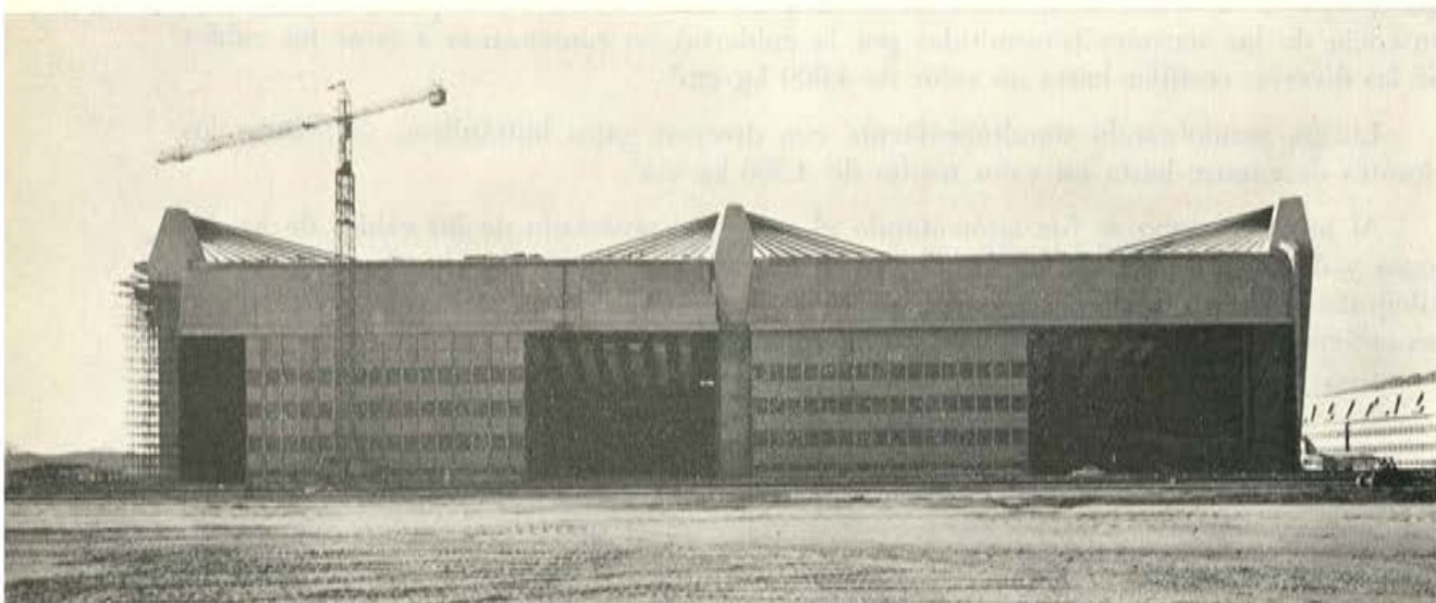
Fig. 18. — Los hangares 4 y 5 del aeropuerto internacional de Fiumicino, casi terminados.
