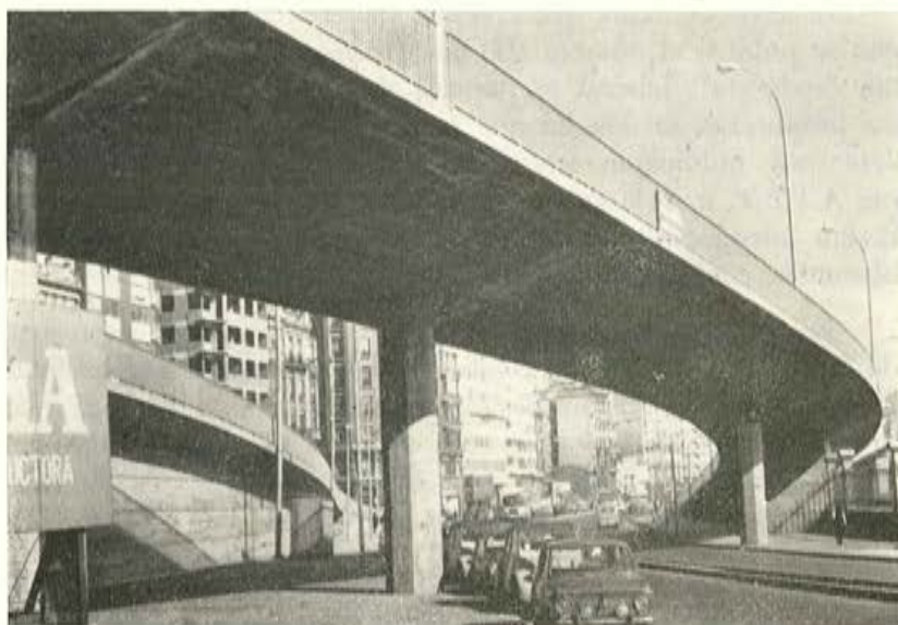
Viaducto de la Avenida de Primo de Rivera. La Coruña.
